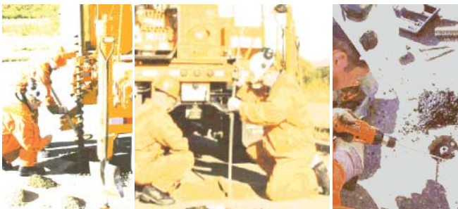
Installation d'un gelmètre dans la chaussée
