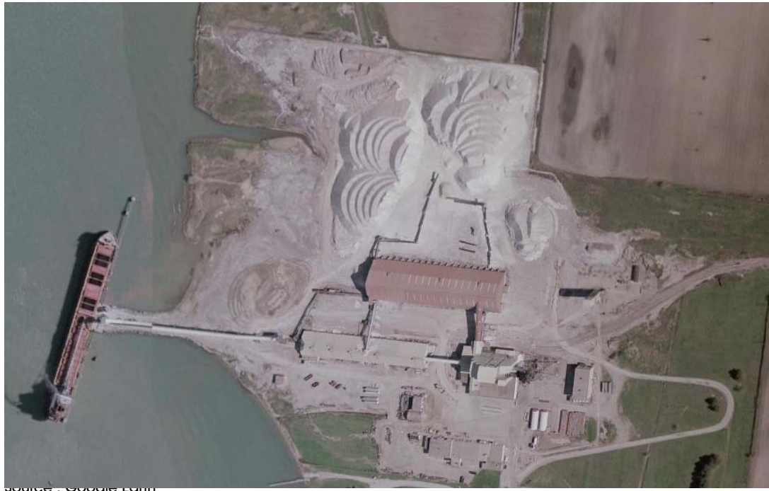
Figure 2 Installations de sel à Windsor
