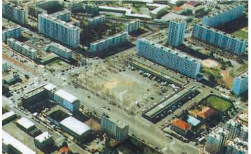
Place avant aménagement
