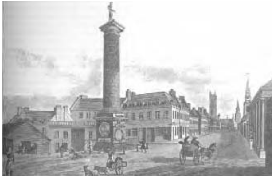
Vue de la rue Notre-Dame vers l'ouest en 1830, montrant le premier emplacement de l'église Notre-Dame au centre de l'artère (dessin de Robert Auchmaty Sproule)
