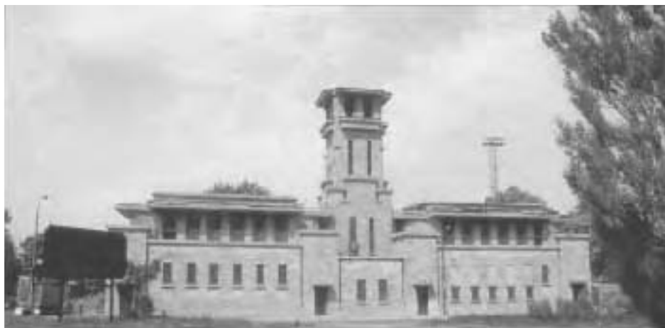
La caserne Létourneux, ancien poste de pompiers # 1 de Maisonneuve
