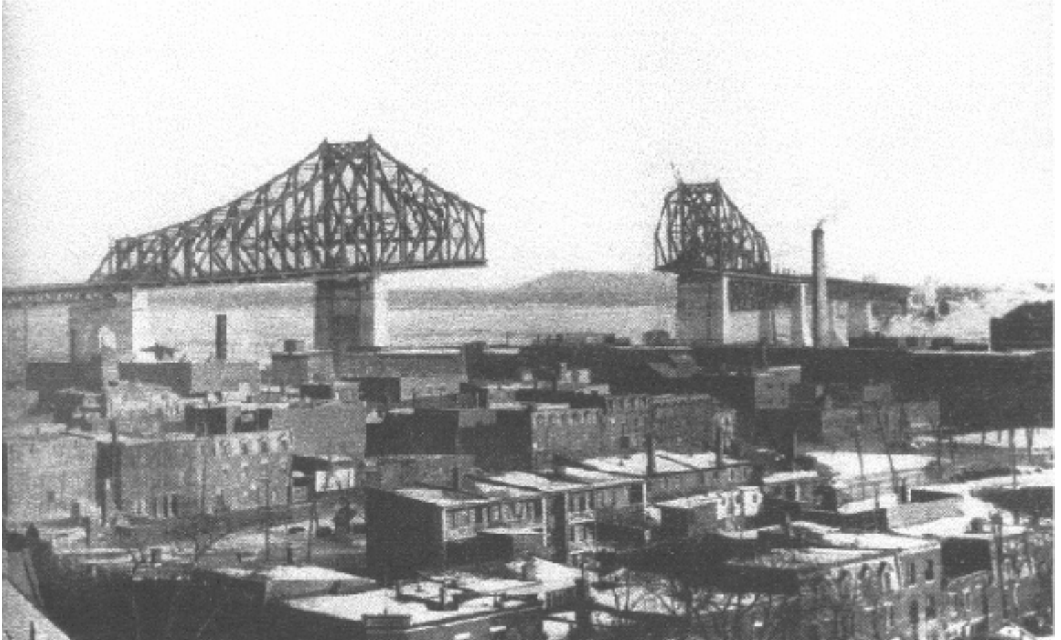
Le Pont Jacques-Cartier en construction en 1929
