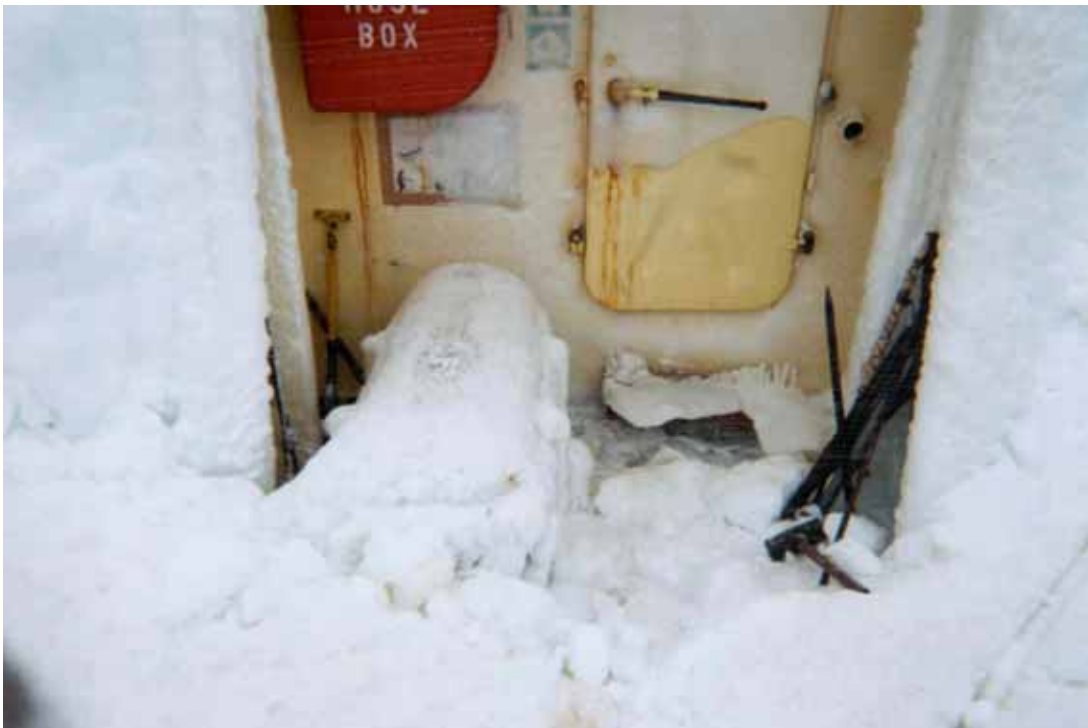
Figures 5.3D – Entrée du château avant et radeau pneumatique inutilisable
