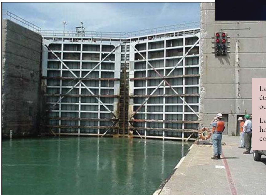
Porte busquée inférieure de l'écluse Eisenhower Source : Saint Lawrence Seaway Development Corporation
