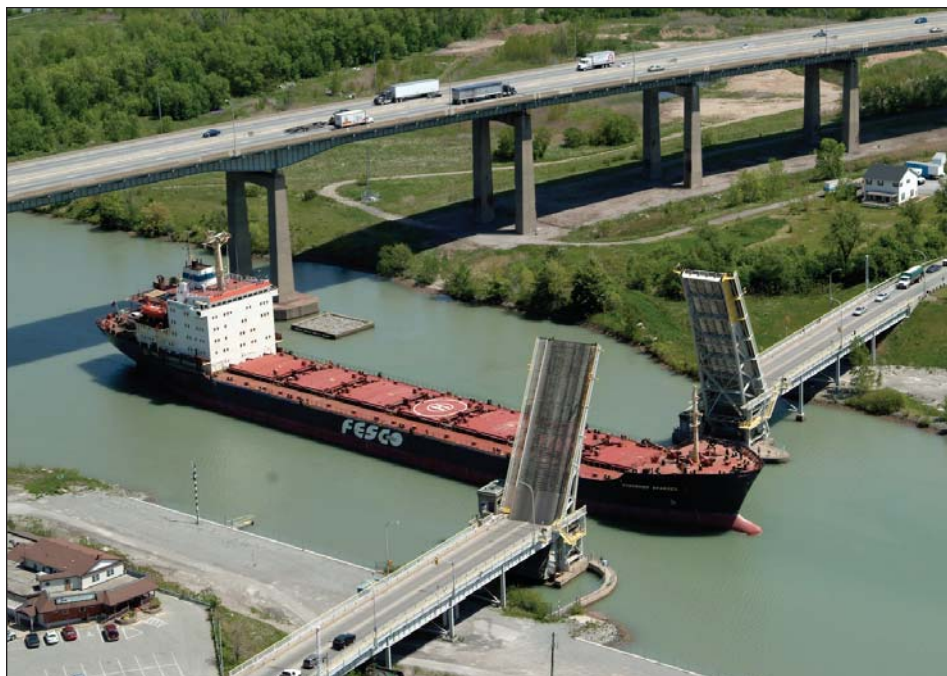
Soulèvement du tablier d'un pont levant pour le transit d'un navire
