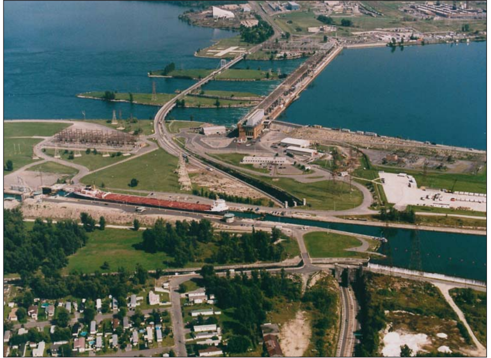
Vue aérienne du barrage et de la centrale de Beauharnois, à côté de l'écluse inférieure de Beauharnois Source : Corporation de gestion de la Voie maritime du Saint-Laurent
