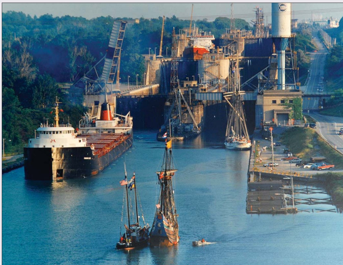
Vue rapprochée des écluses 4, 5 et 6 à Thorod (quatrième canal Welland) Source : Thies Bogner, photographe
