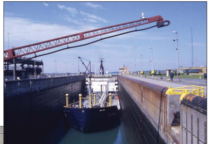
Navire levé dans le sas d'écluse Source : Corporation de gestion de la Voie maritime du Saint-Laurent
