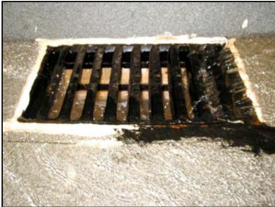
Fig. 4.1 - Grille d'égout pluvial
