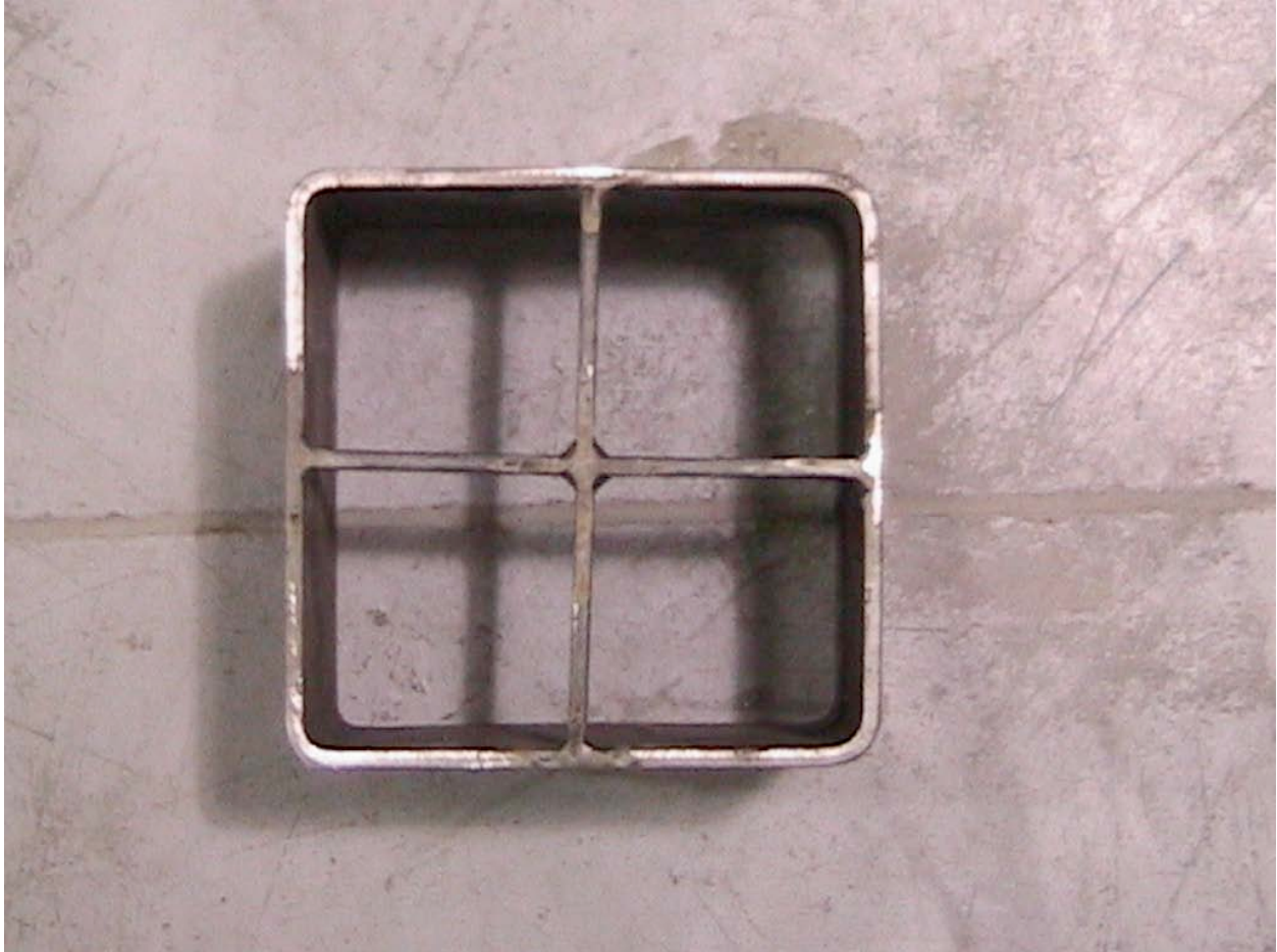
Fig. 4.80 – Grille drain de pont
