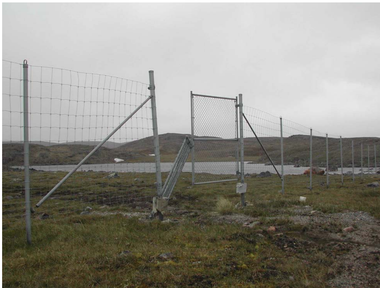
Figure 63 Clôture expulsée par le soulèvement au gel non loin de la piste de Salluit
