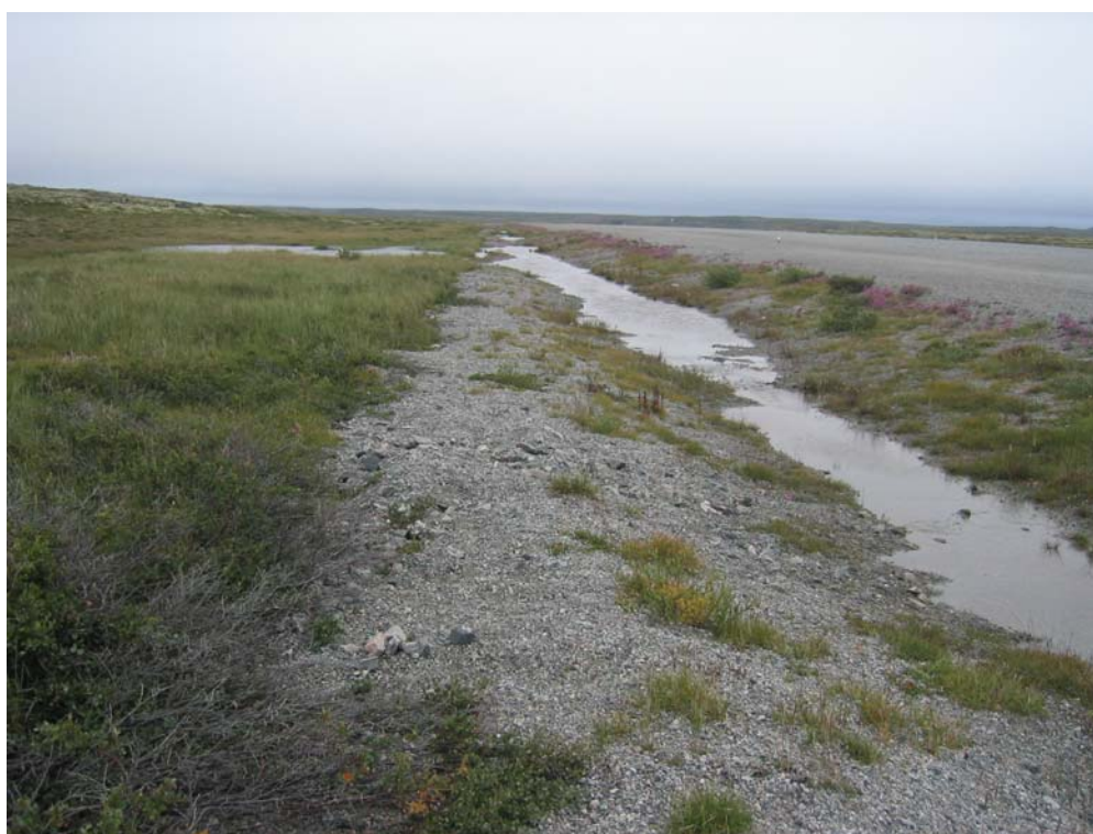
Figure 23 Fossé contenant de l'eau en bordure nord de la piste
