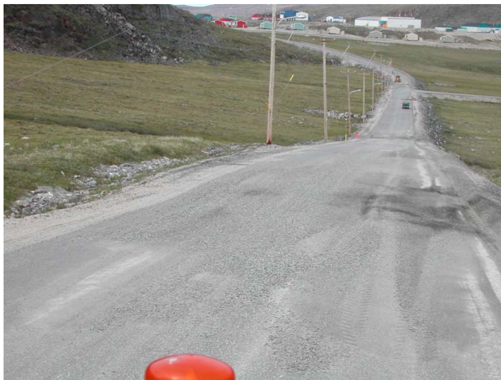
Figure 60 Remplissage des dépressions par ajout de gravier par-dessus l'asphalte (juillet 2006)
