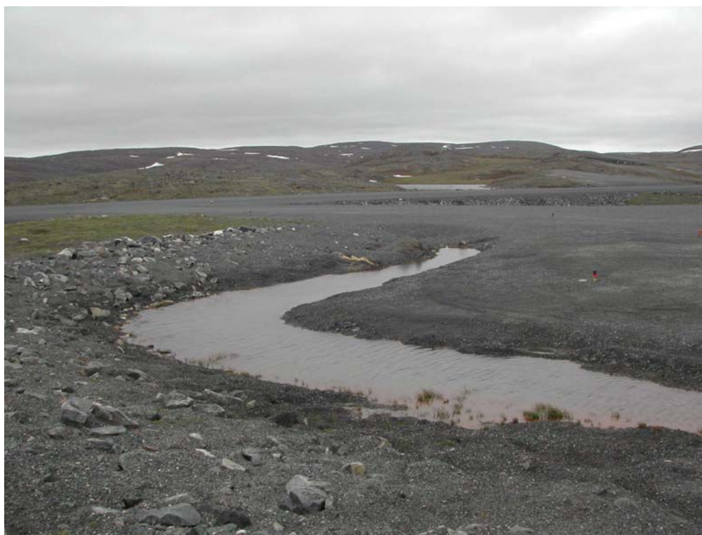
Figure 70 Inondation du secteur nord de la voie de circulation de la piste de Salluit
