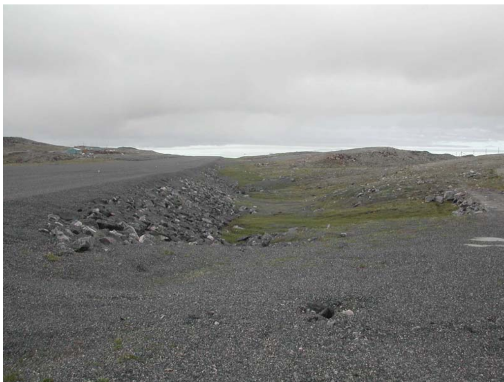
Figure 72 Combe à neige en bordure est de la piste de Salluit
