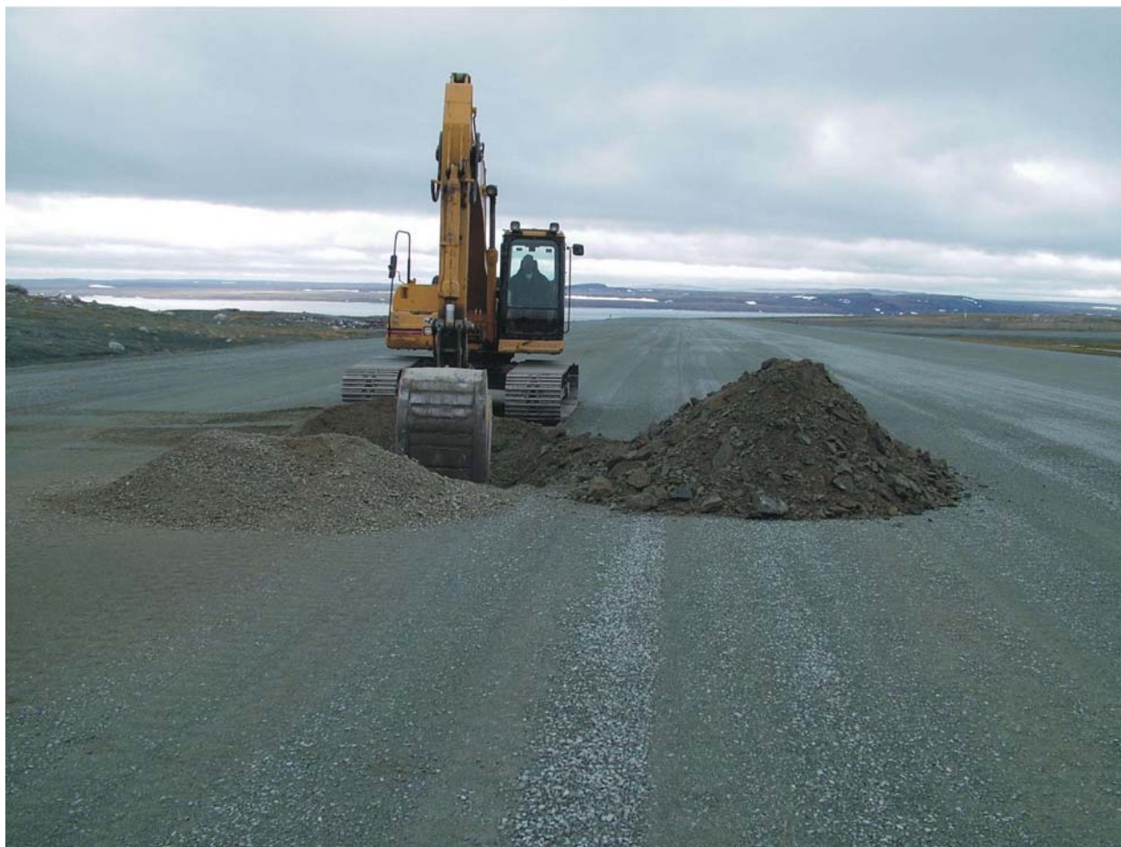
Figure 95. Excavation faite dans la piste de Kangirsuk le 19 juin 2005
