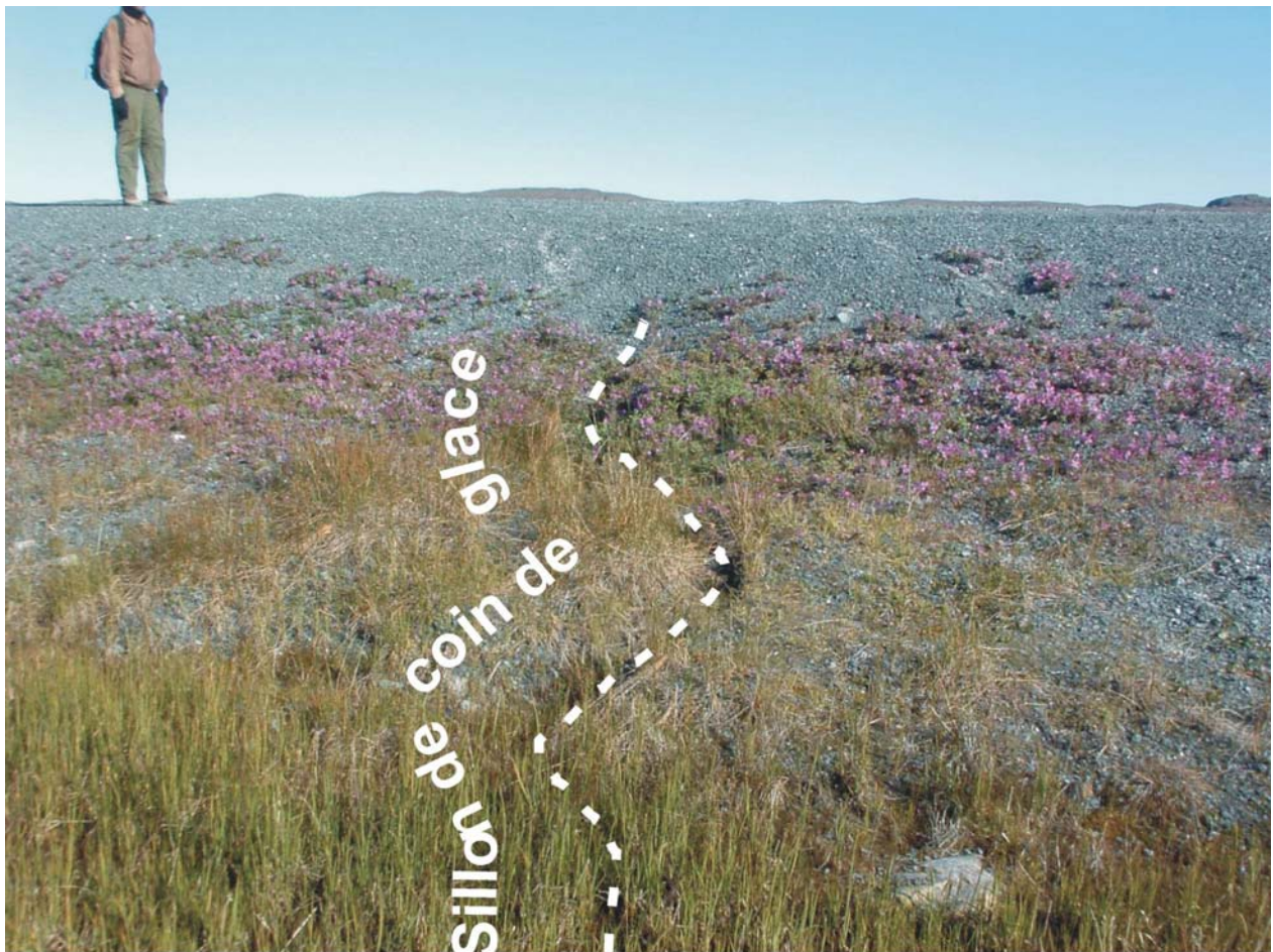
Figure 43 Coin de glace se propageant sous le remblai de la piste d'Akulivik et incisant la base du talus
