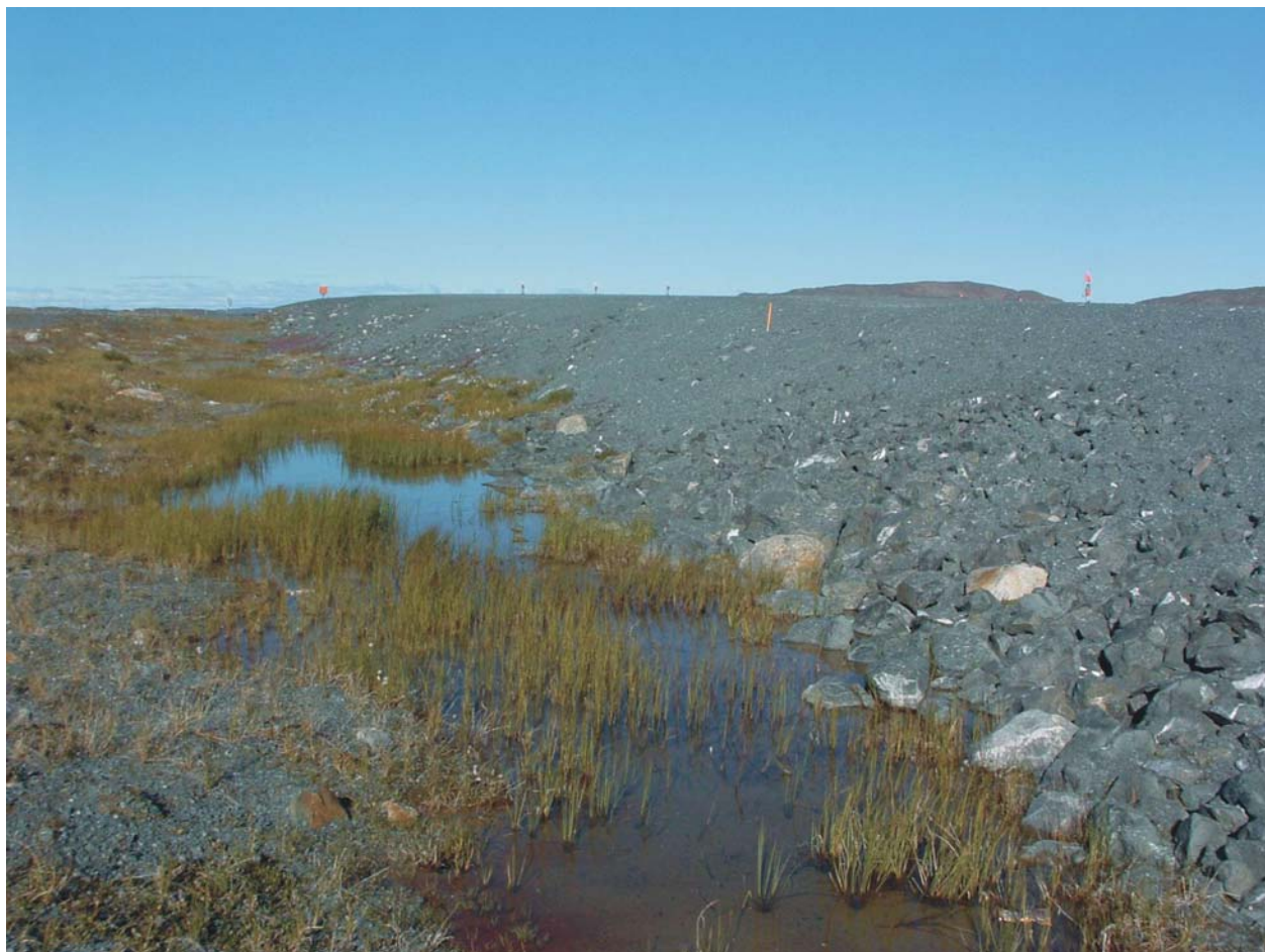
Figure 40 Fossé de drainage de la section est, côté nord, de la piste d'Akulivik
