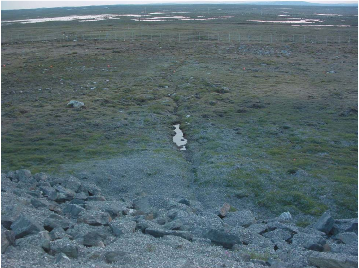
Figure 105 Coin de glace passant sous la piste d'atterrissage d'Aupaluk
