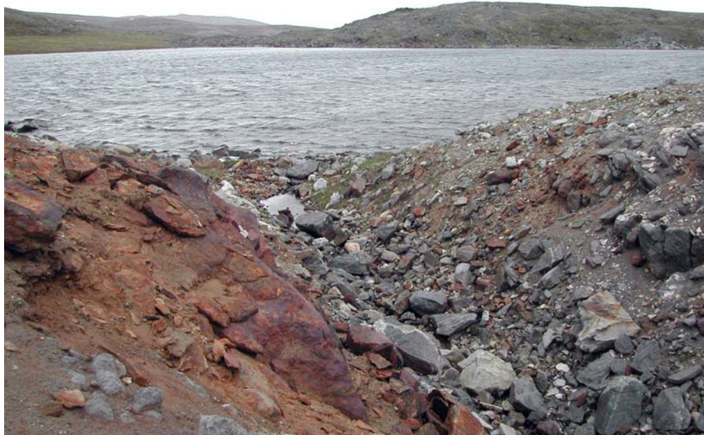
Figure 71 Exutoire bouché du lac proche du côté est de la piste de Salluit
