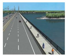
Une piste multifonctionnelle fera partie du pont. Son but est de permettre une traversée aisée et sécuritaire des piétons et des cyclistes. D'une largeur de trois mètres, cette piste sera directement intégrée au tablier du pont et sera séparée des voies de circulation automobile par une glissière de sécurité. Un garde-corps sera également installé du côté de la rivière.
