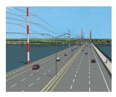
Du côté de Laval, il s'agira d'une section d'environ 512 mètres suspendue au moyen de câbles en acier appelés haubans. Deux pylônes seront nécessaires au support des haubans, espacés de 280 mètres. Cette grande distance entre les pylônes a l'avantage d'éviter de perturber une fosse à esturgeons jaunes considérée comme un habitat faunique important.
