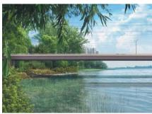
Les techniques de stabilisation des berges prévues de part et d'autre des rives du pont, permettront de conserver leurs aspects naturels. De plus, les herbiers aquatiques perturbés lors de la construction des piles du pont du côté de Montréal seront remplacés de façon à recréer un milieu similaire.
