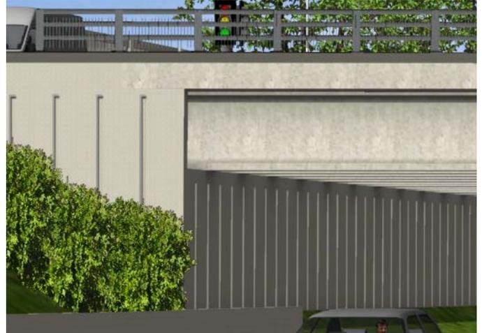
Des modèles pour les culées et murs de soutènement optionnels ont été réalisés et sont décrits en détail plus loin dans ce rapport.
