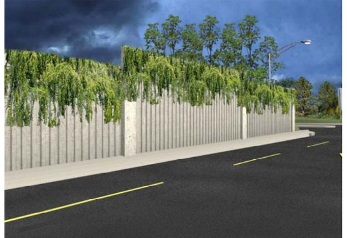
Afin d'assurer la durabilité, nous fournirons des murs antibruit revêtus d'un fini naturel en béton. Comme pour les structures du pont, ce fini de béton vieillira bien et s'incorporera au paysage visible avoisinant. Les parements verticaux des murs de soutènement recevront aussi un traitement de modelage de forme rectiligne similaire à celui des culées. Des options de modelage de forme rectiligne ont été réalisées et sont présentées plus loin dans ce rapport.
