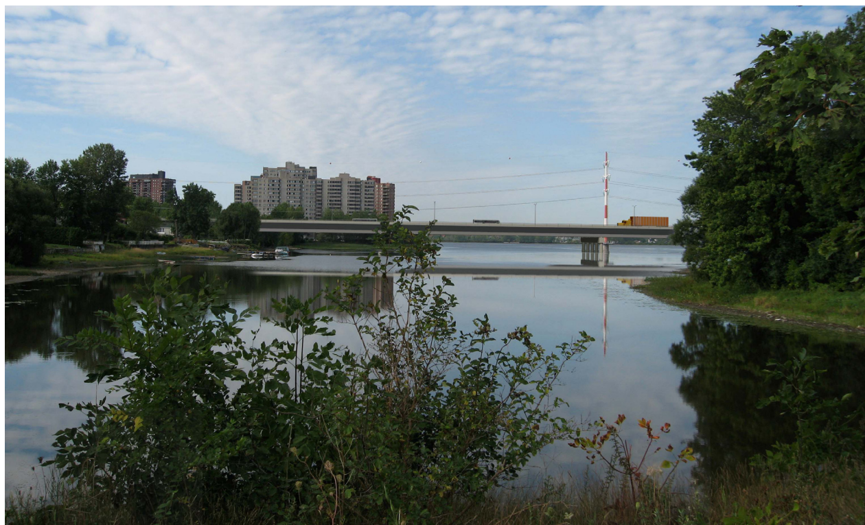
Situation projetée Photo no. 34
