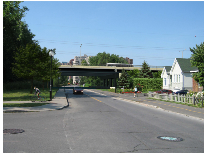
Situation projetée Photo no. 8
