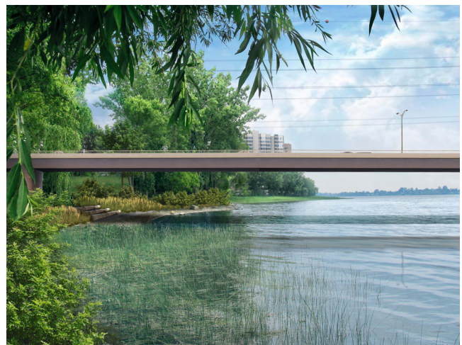
Situation projetée Photo no. 30
