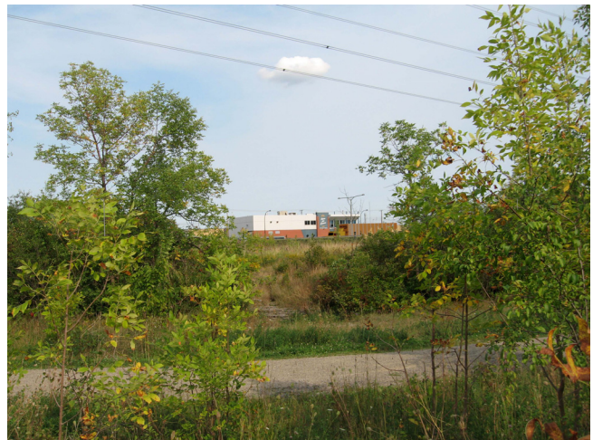
Situation projetée Photo no. 12
