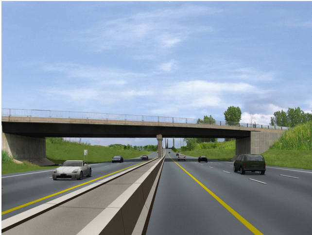
Concept 1 Vue vers le sud (Montréal) à partir du viaduc ferroviaire Photo no. 27
