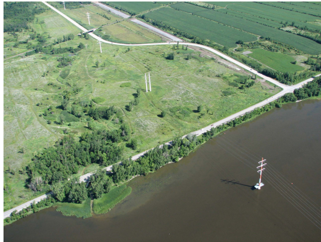
Situation actuelle Photo no. 24
