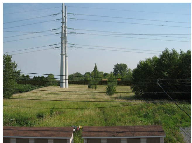
Situation projetée Photo no. 10
