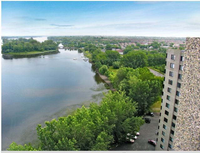
Situation actuelle Photo no. 31
