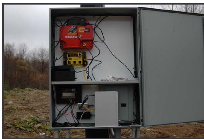
L'équipement électrique nécessaire au fonctionnement de la clôture électrique.
