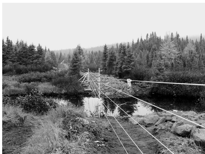
Un tronçon de clôture électrique de cinq kilomètres a été érigé le long d'un secteur particulièrement problématique (Km 175 à 180) dans la réserve faunique des Laurentides. L'efficacité de cette clôture est actuellement évaluée dans le cadre d'un projet de recherche.
