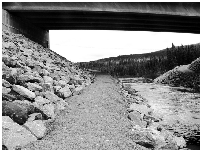
Un passage à faune permet aux animaux de traverser en toute sécurité sous la route, le long de la clôture électrique.
