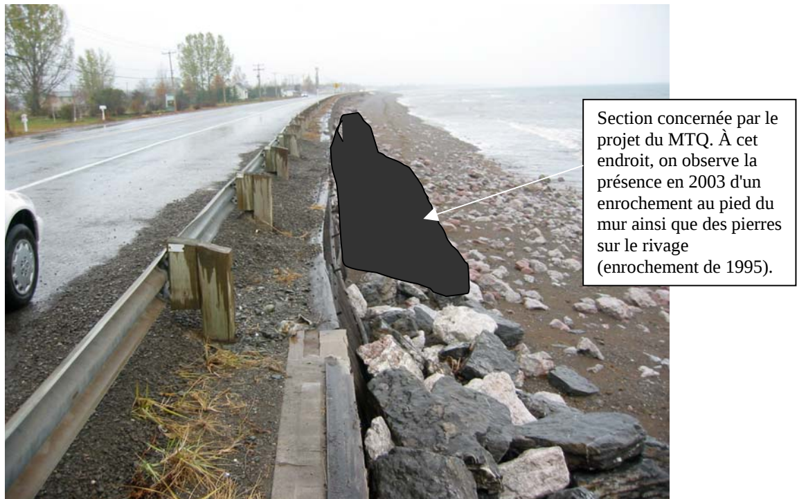
Photo 2 : Partie de mur détériorée à Maria (direction est), secteur immédiatement à l'est du ruisseau Martien (29 octobre 2003)
