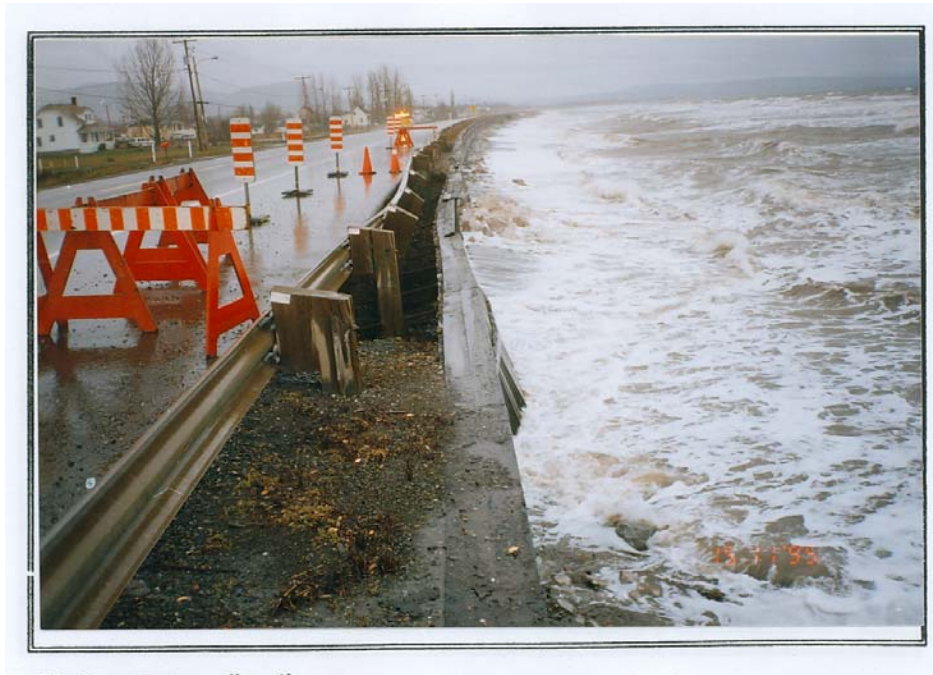
Photo 1 : Bris du mur de Maria lors d'une tempête en 1995 (direction est) ayant fait l'objet de travaux d'urgence, secteur immédiatement à l'est du ruisseau Martien (15 novembre 1995)
