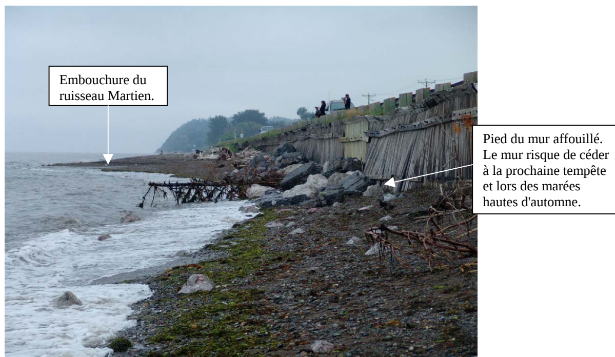
Photo 5 : Pied du mur affouillé à Maria (vue rapprochée en direction ouest), secteur immédiatement à l'est du ruisseau Martien (19 juillet 2004)
