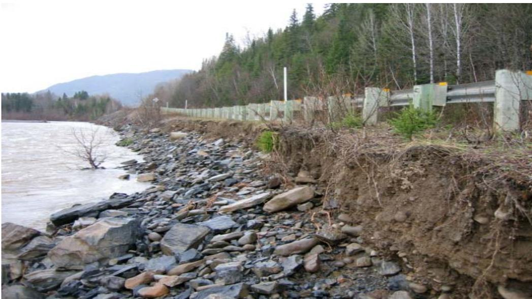
**Figure 4 : Érosion de la base de la glissière de sécurité (site 9)**
