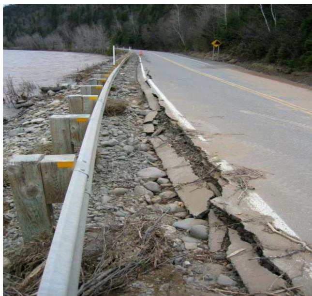
**Figure 6 : Érosion sous le pavage de la route**
