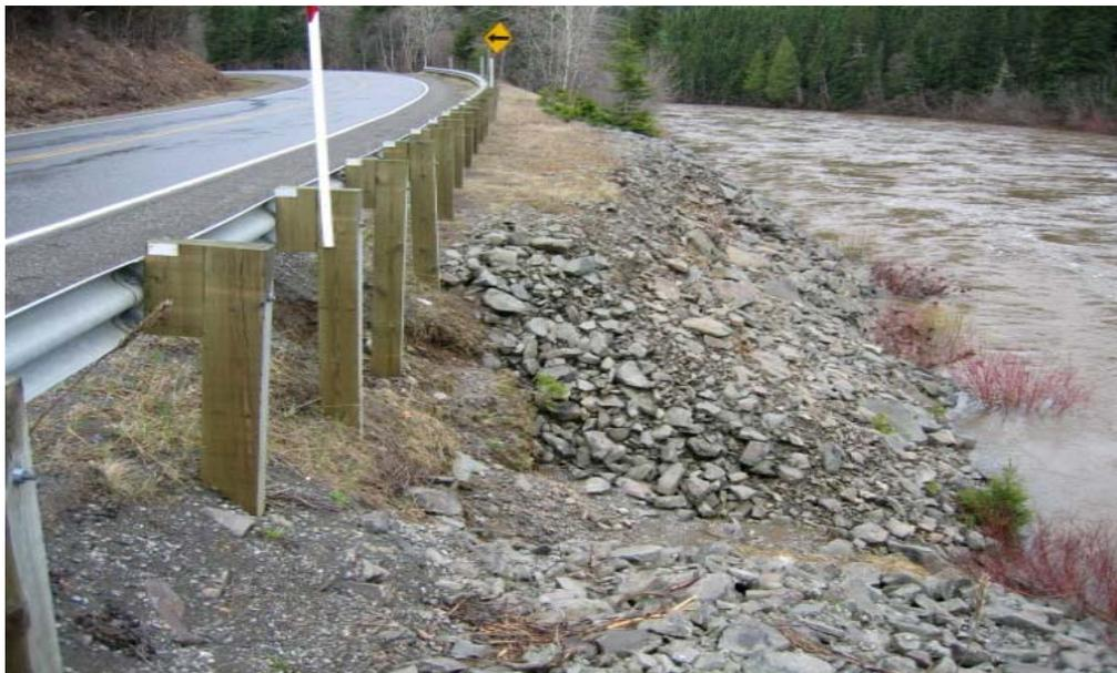
**Figure 5 : Érosion entre la bordure du pavage et la glissière de sécurité**
