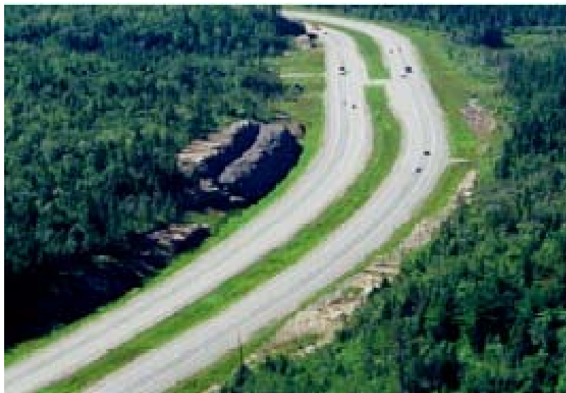
FIGURE 2 : EXEMPLE D'UNE ROUTE À QUATRE VOIES DIVISÉES AVEC OUVERTURE DANS LE TERRE-PLEIN CENTRAL
