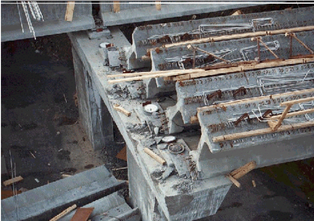
Figure 3.4 Vue aérienne des poutres 1 à 4 à la pile 4 (photo 308.3.12)
