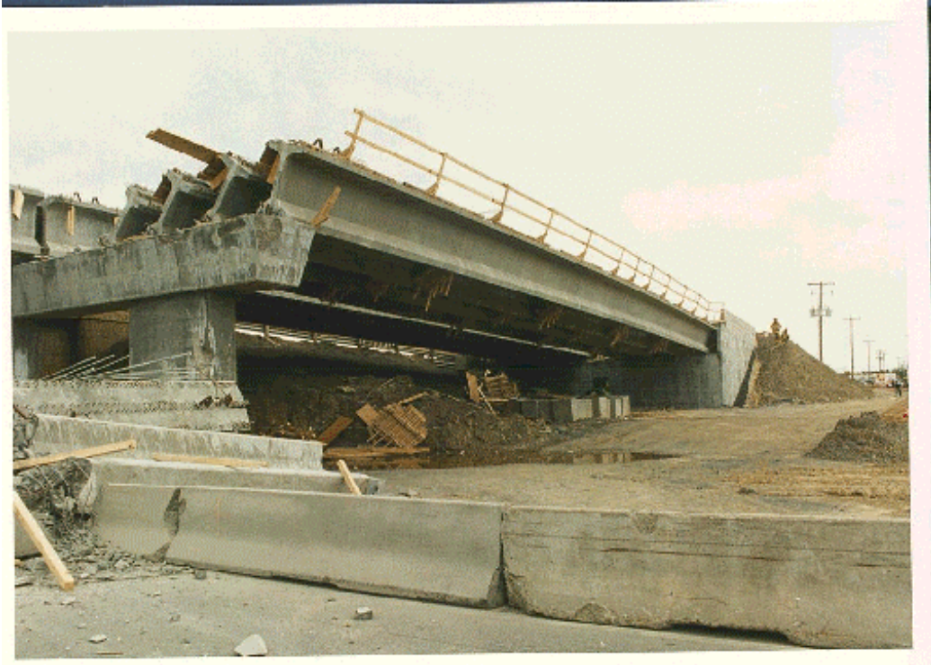
Figure 3.3 Vue des poutres 1 à 4 de la travée 4 (Photo SQ-B11)
