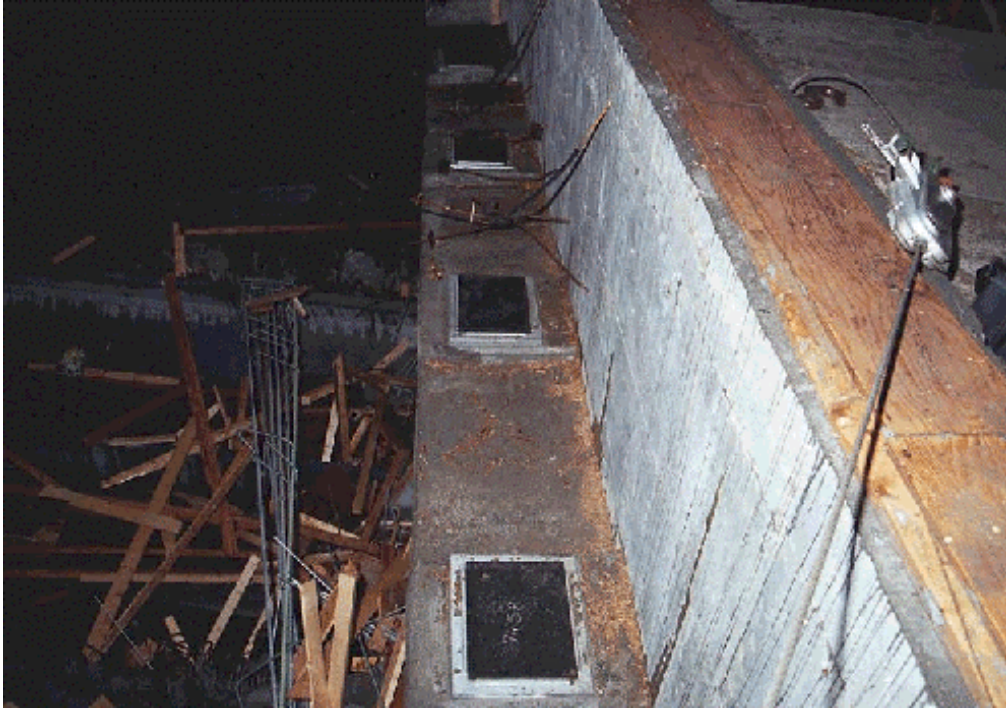
Figure 3.27 Vue vers le sud des appareils d'appui des poutres 1 à 4 à la culée 1 (photo 280.3.06)
