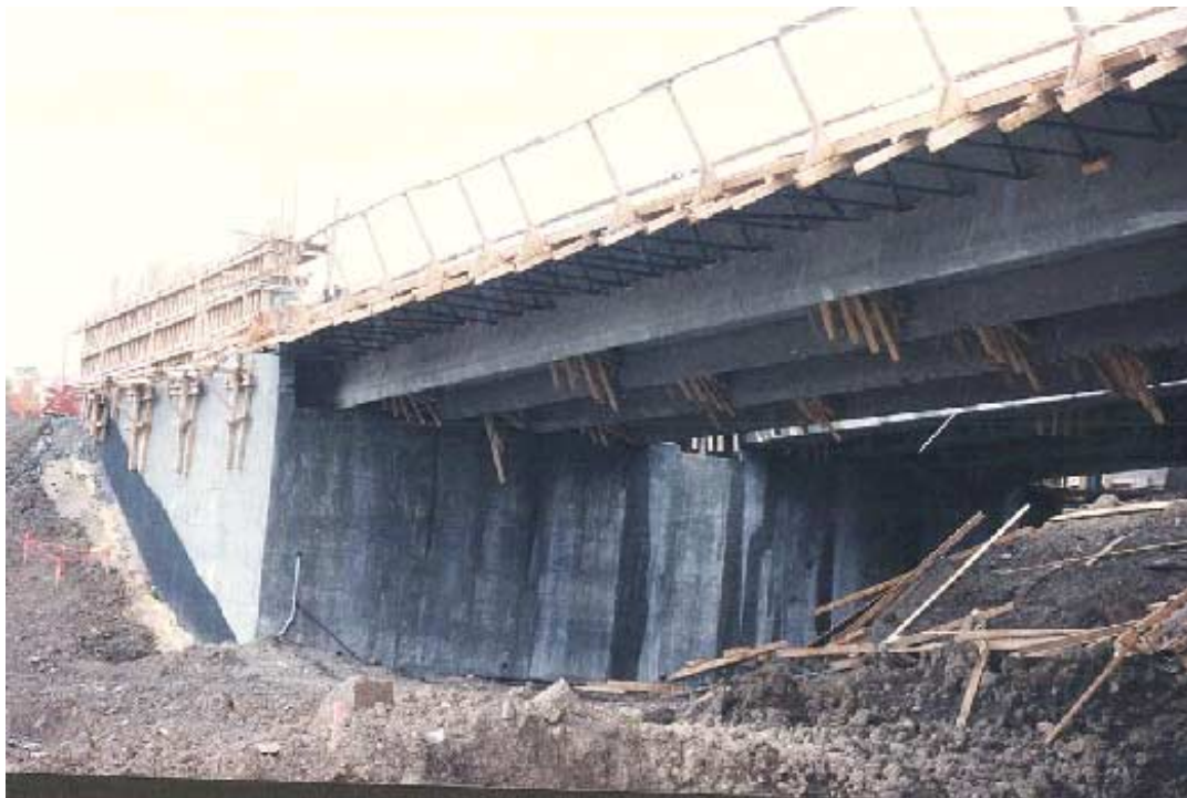
Figure 3.6 Vue des poutres 1 à 4 de la travée 1 à la culée 1 (photo pom.26)
