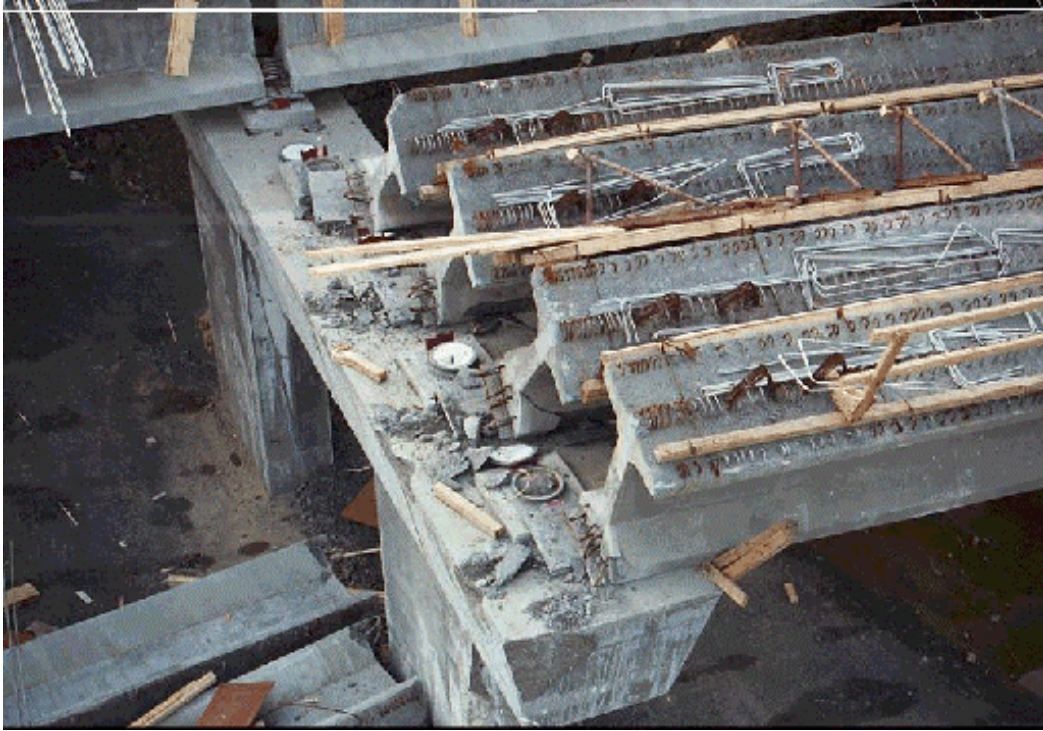
Figure 3.18 Vue de l'extrémité des poutres 1 à 4 à la pile 4 (photo 308.3.13)
