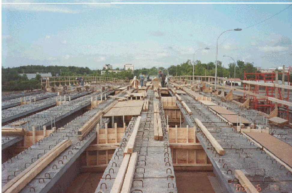
Figure 2.20 Plancher de travail et coffrage des entretoises intermédiaires à la travée 3 (photo DES.216, vue vers l'ouest)
