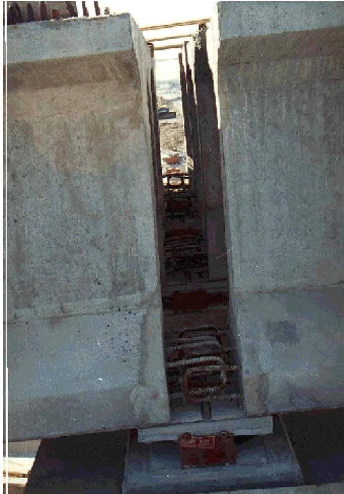
Figure 2.11 Vue vers le sud de l'appui des poutres 8 à la pile 4 (Photo 330.1.21 1 )
