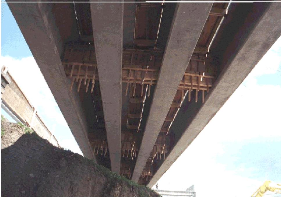
Figure 2.22 Coffrage de la dalle et des entretoises intermédiaires de la travée 4 (Photo 280.2.22, prise après l'accident)
