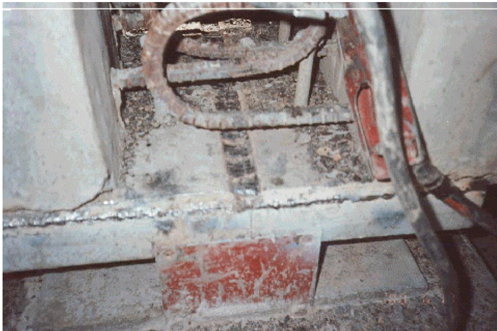
Figure 2.19 Soudure des plaques d'assise des poutres à un appui à la pile 3 (Photo DES.212)
