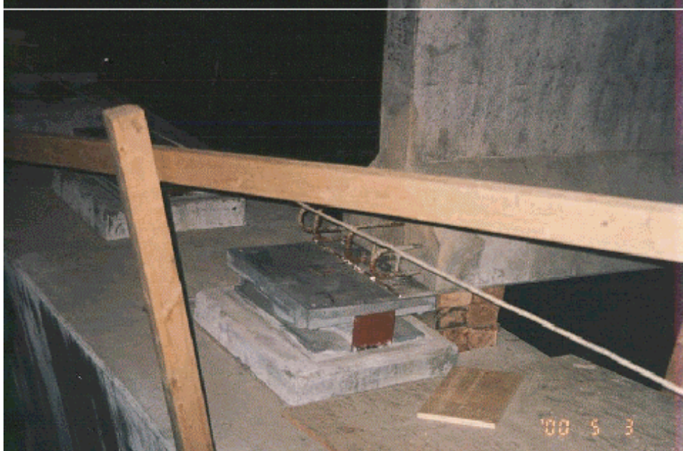
Figure 2.13 Installation de la poutre no.8 de la travée 1 (Photo CSST.4)
