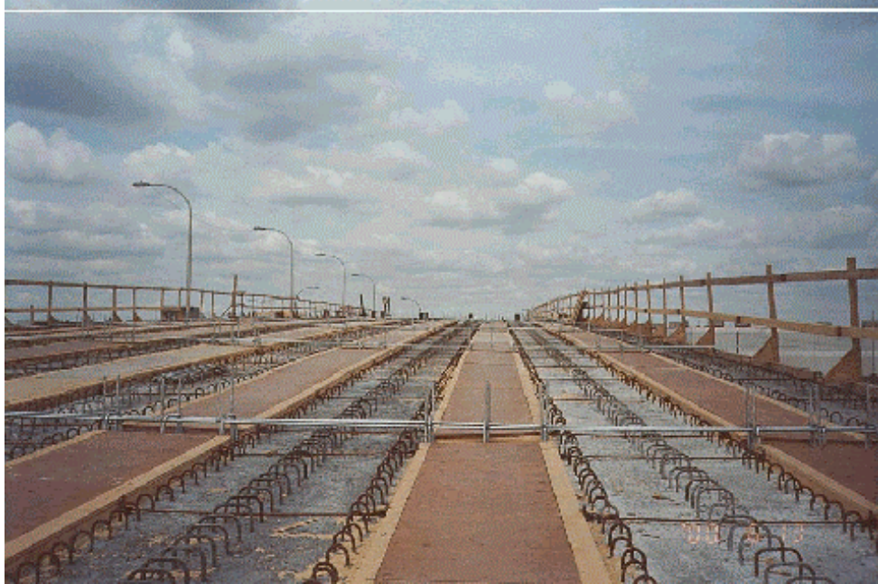
Figure 2.27 Coffrage de la dalle terminé dans la partie ouest (photo DES.186)
