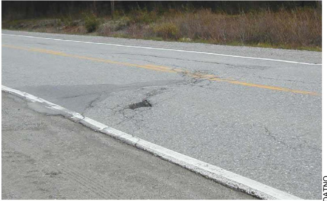
Une chaussée déficiente par rapport au confort de roulement peut être le résultat d'un vieillissement normal ou accéléré. Dans ce dernier cas, il est possible que la déficience fonctionnelle (mauvaise qualité de roulement) provienne d'une déficience structurale, dont il faudra identifier la cause.
