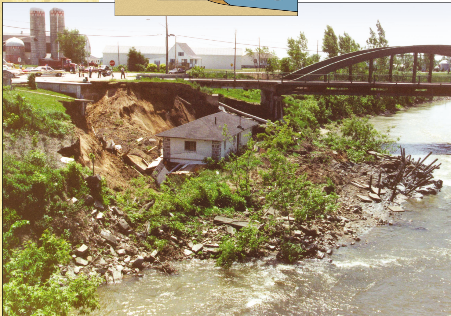
Figure 5 : Croquis et photo d'un glissement rotationnel
