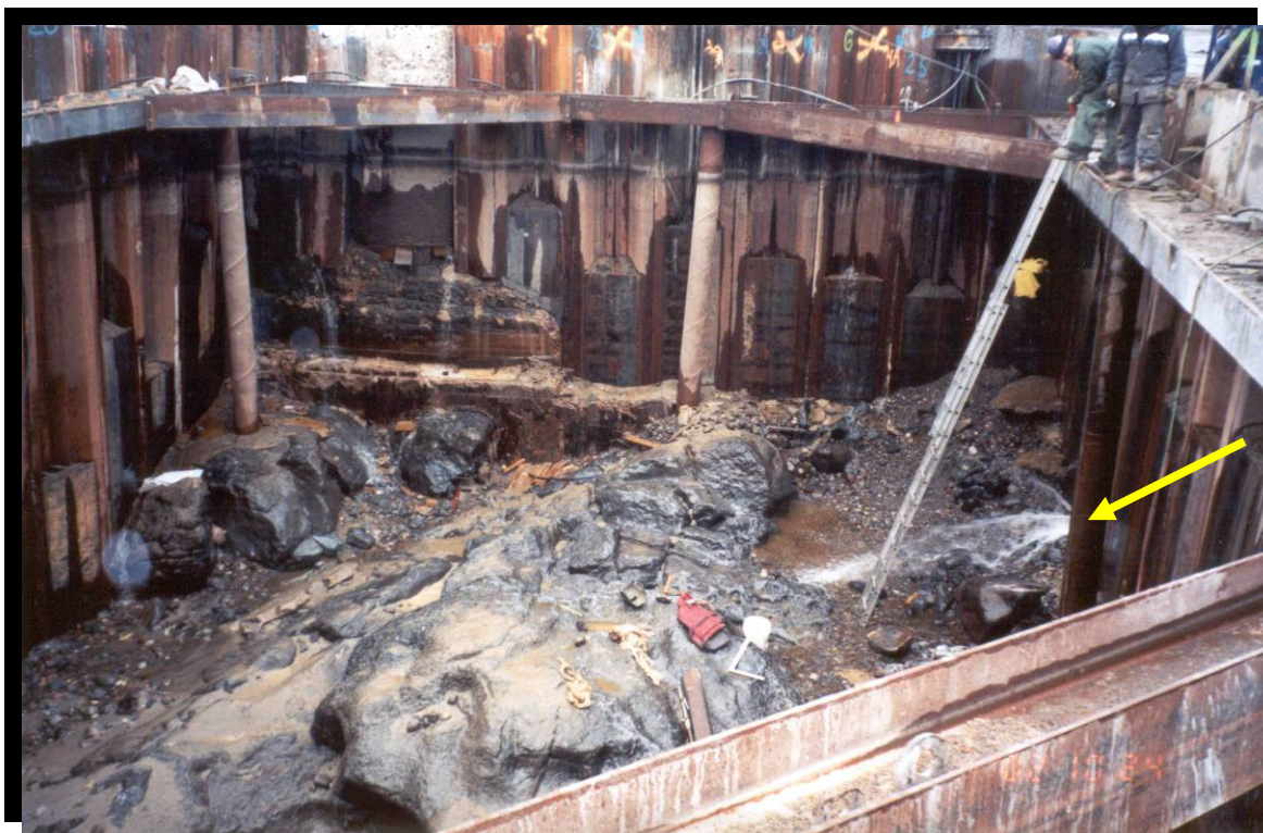
FIGURE 84 Batardeau aménagé dans la rivière la Grande Décharge pour la construction d'un pilier. Infiltration d'eau qui nécessite l'étanchement des palplanches d'acier par injection de béton. Route 169 à Alma. (2002.1141)
