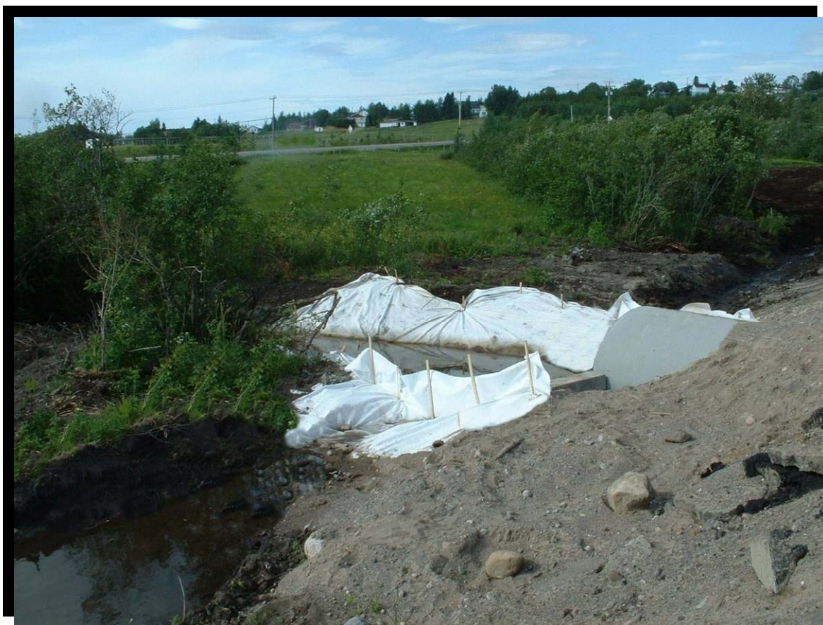
FIGURE 136 Utilisation de barrières géotextiles. Route 155 à Saint-François-de-Sales. (2002.1030)
