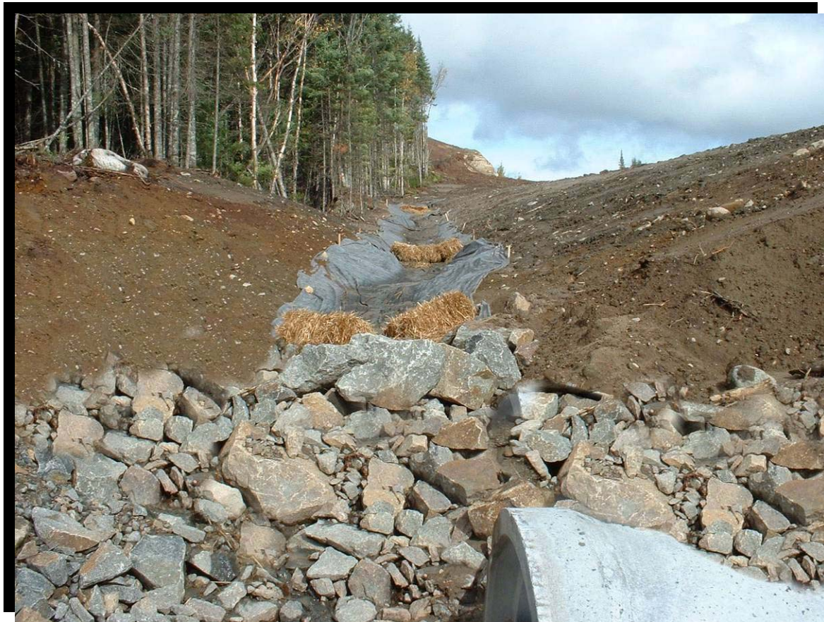
FIGURE 140 Stabilisation temporaire d'un fossé en construction avec membrane géotextile et ballots de paille. L'extrémité du ponceau est empierrée immédiatement de façon permanente. Route 175 dans la réserve faunique des Laurentides, au kilomètre 189, secteur du lac des Uries. (2003.1090)
