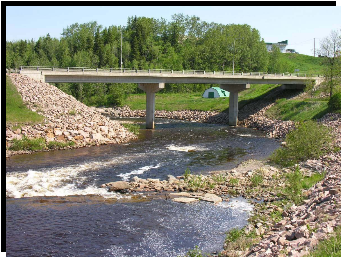
FIGURE 86 Pont à poutres de béton avec 2 piliers. Reconstitution du lit du cours d'eau. Engazonnement et plantation sur les bandes riveraines. Route 381 à La Baie, rivière à Mars. (2005.1103)
