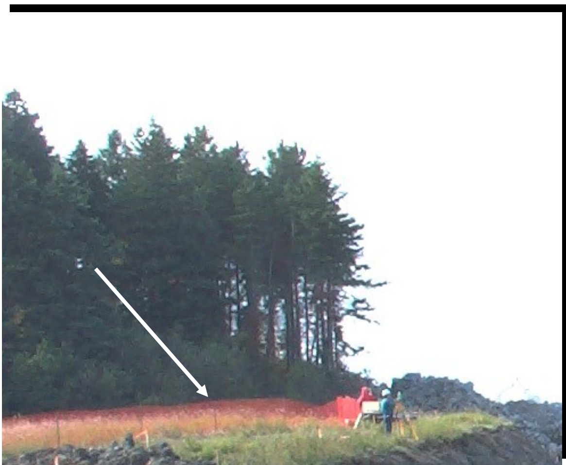
FIGURE 47 Clôture de protection d'un îlot boisé à conserver à l'intérieur d'un échangeur. Autoroute 70 à Jonquière, secteur du carrefour Saint-Hubert. (2000.1043)
