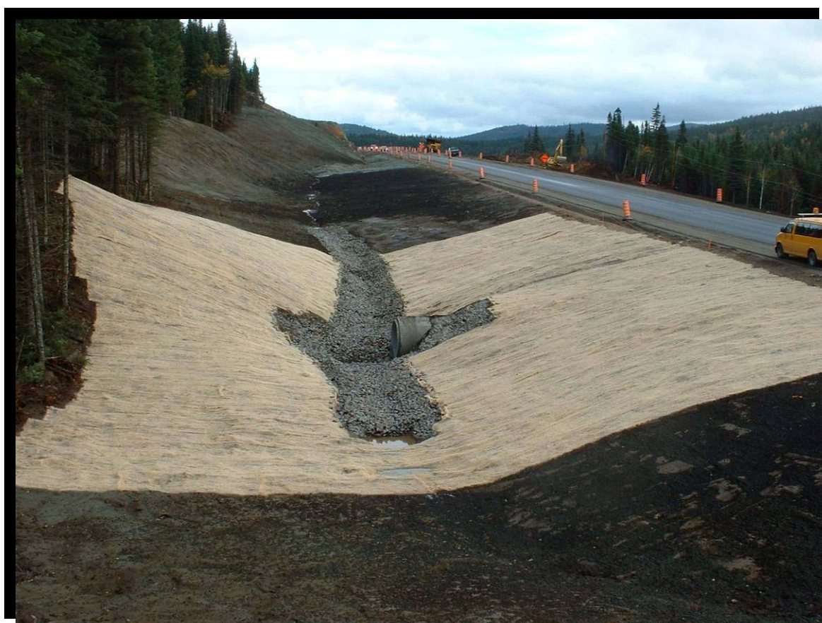
FIGURE 145 Stabilisation immédiate et permanente au droit d'un ponceau de drainage qui se déverse à l'extérieur de l'emprise. Empierrement des fossés, du ponceau et du lit du cours d'eau intermittent. Fosses de captation, engazonnement et matelas de fibre de bois. Route 175 dans la réserve faunique des Laurentides, au kilomètre 189, secteur du lac des Uries. (2003.1059)
