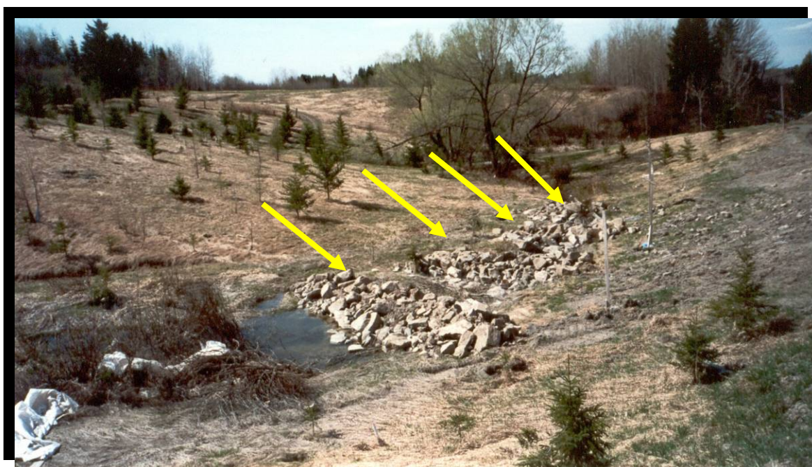
FIGURE 125 Bermes filtrantes et trappes à sédiments dans un fossé. Autoroute 70 à Jonquière, pont de la rivière aux Sables. (2001.1033)
