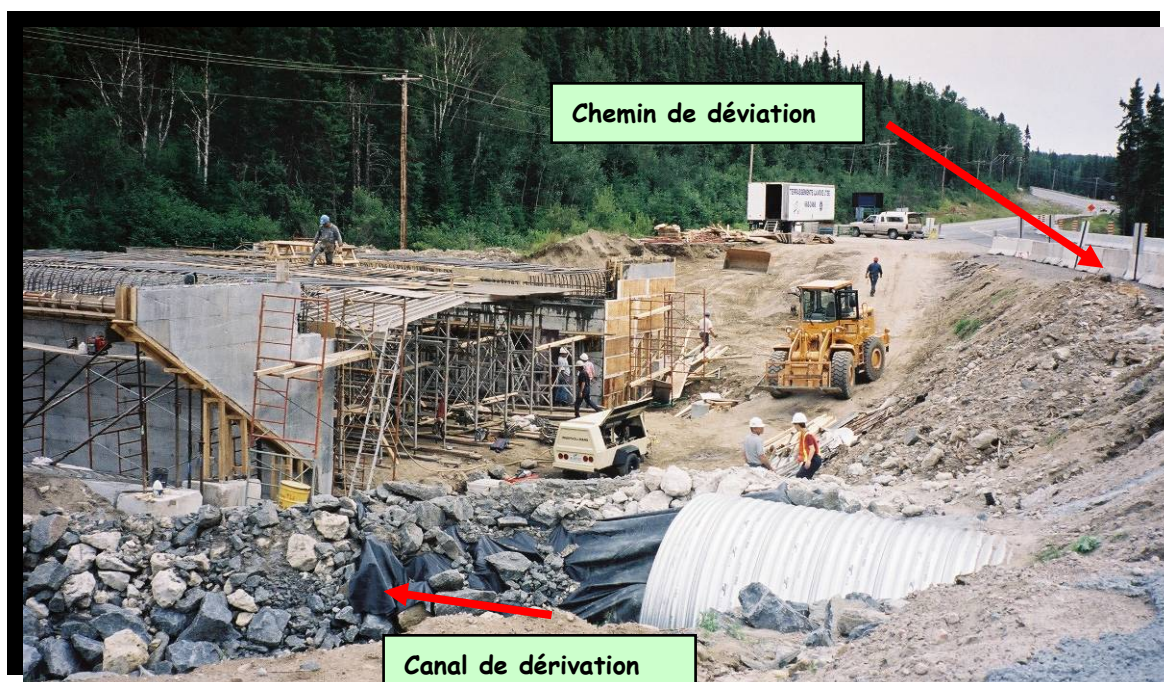
FIGURE 75 Chantier de construction d'un pont de type portique sur semelles. Route 169 dans la réserve faunique des Laurentides, rivière Sawine, au kilomètre 43. (2001.1184)
