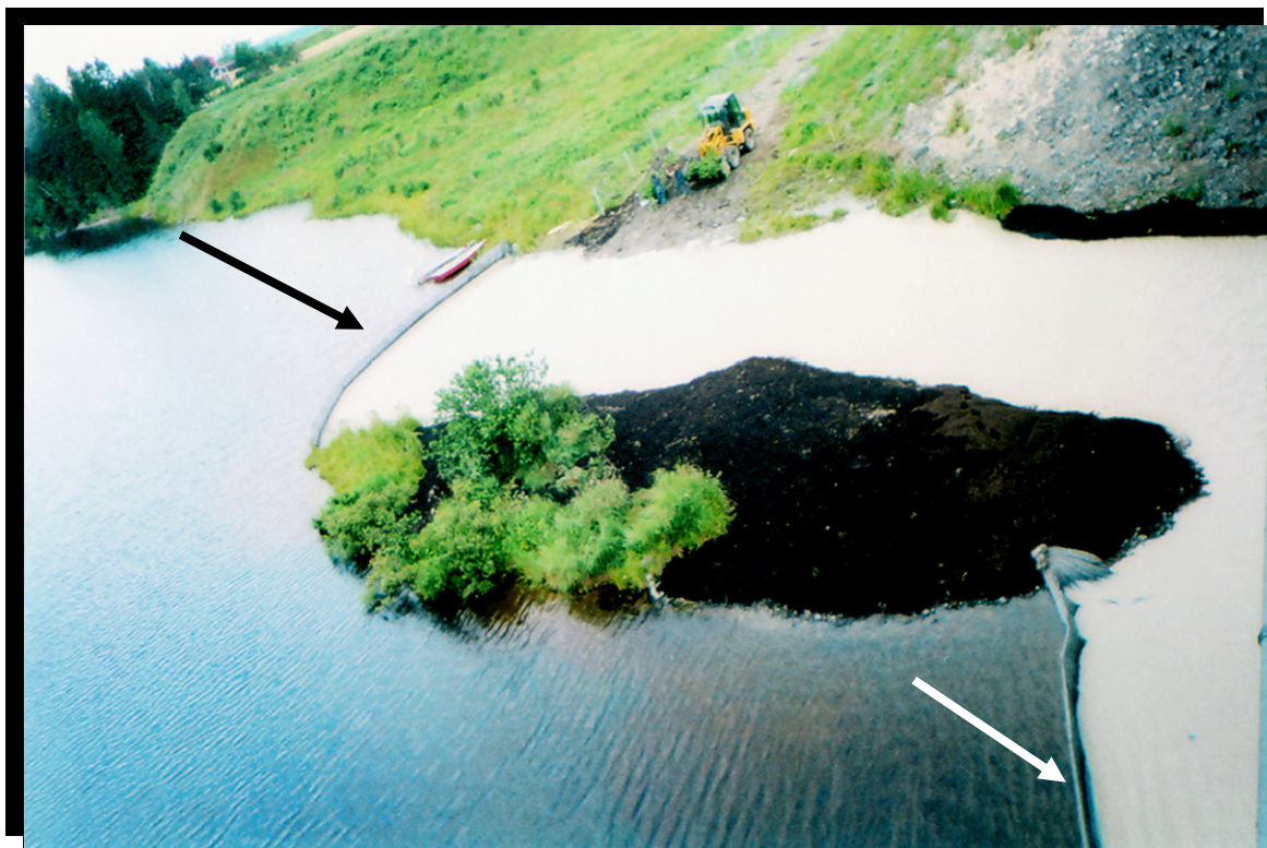
FIGURE 137 Utilisation d'un rideau de confinement ancré au fond de l'eau à l'aide de poteaux. Autoroute 70 à Jonquière, pont de la rivière aux Sables. (2003.1161)
