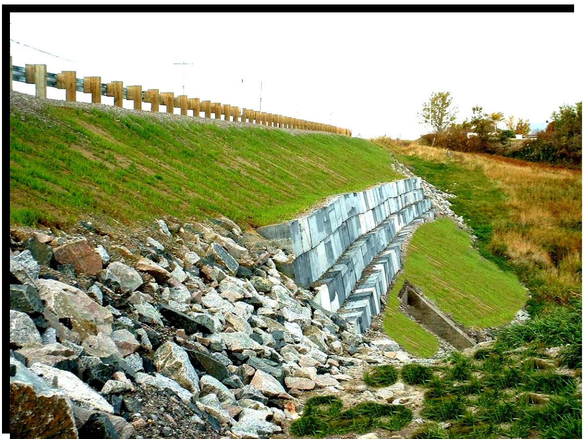
FIGURE 26 Route 170 à Saint-Gédéon, ruisseau agricole. (2002.1024) Construction d'un mur de soutènement constitué d'un mur-poids en blocs de béton afin d'éviter l'acquisition supplémentaire d'emprise en milieu agricole. (Composantes acquisition et agriculture du milieu humain)
