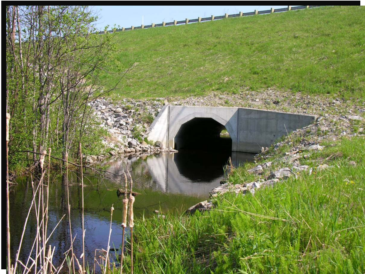
FIGURE 93 Ponceau voûté avec radier dans l'émissaire du lac Goth. Engazonnement sur les bandes riveraines. Route 170 à Saint-Félix-d'Otis. (2005.1108)
