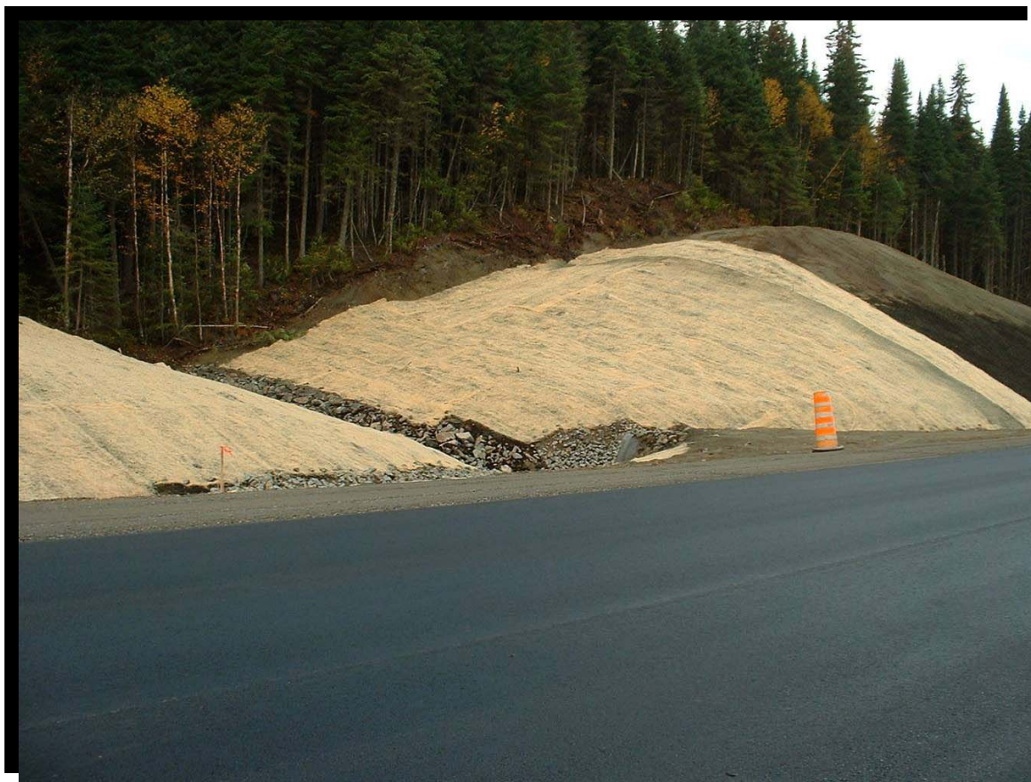
FIGURE 144 Stabilisation immédiate et permanente au droit d'un ponceau en zone de déblai. Empierrement des fossés, du ponceau et du lit du cours d'eau. Fosses de captation, engazonnement et matelas de fibre de bois. Route 175 dans la réserve faunique des Laurentides, au kilomètre 189, secteur du lac des Uries. (2003.1081)
