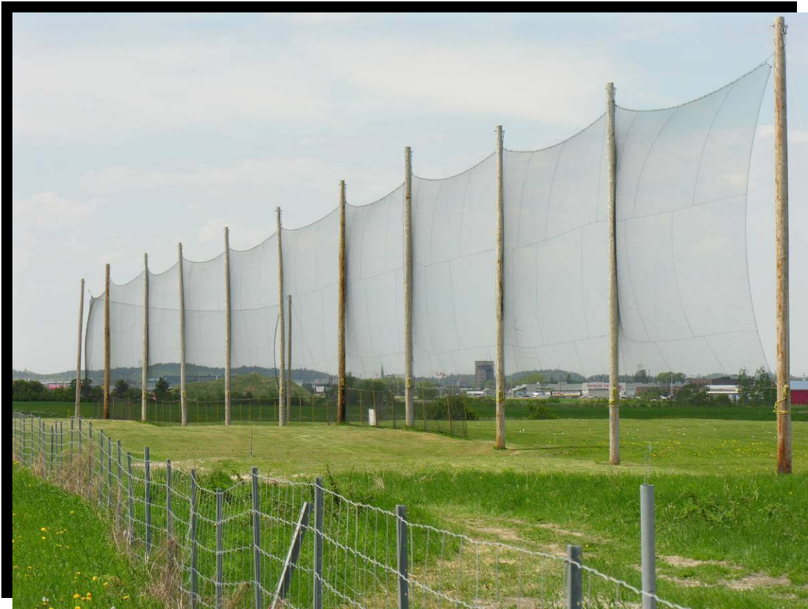
FIGURE 168 Filet trappe pour les balles de golf placé à l'extrémité d'un club de pratique en bordure de la clôture d'emprise. Environ 7,6 mètres de hauteur sur 120 mètres de longueur. Autoroute 70 à Jonquière. (2005.1124)
