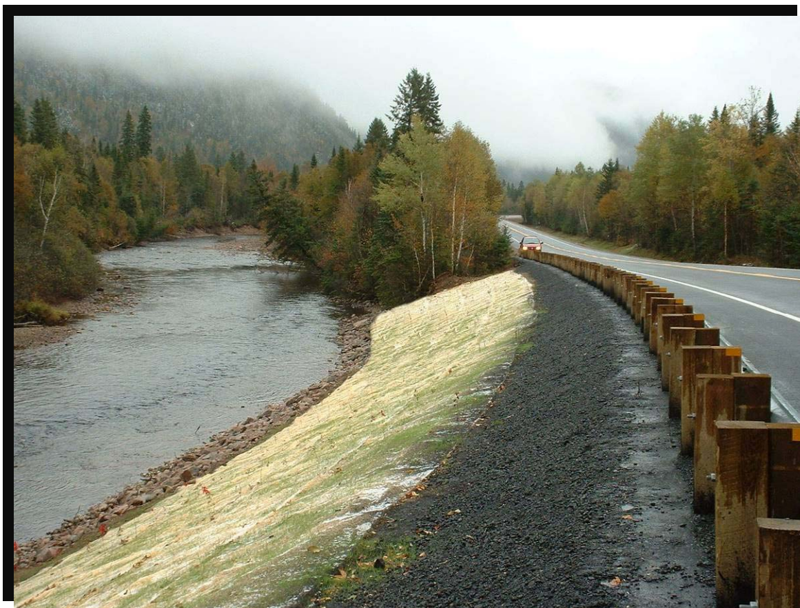
FIGURE 60 Remblai pour l'élargissement de l'accotement et la pose de glissières de sécurité. - Aménagement paysager du remblai de pierre : terre végétale, engazonnement avec matelas de fibre de bois et plantation. Dans ce cas, des frênes rouges, des vinaigriers, des myriques beaumiers et des érables de l'Amur. Espacement de 1 mètre entre les plants. - Aménagement d'un patron de plantation répété tous les 25 mètres, en considération du statut panoramique de la route, de la façon suivante : 10 mètres (engazonnement) - 5 mètres (plantation) - 5 mètres (engazonnement) - 5 mètres (plantation). Route 172 dans le canton Durocher, au kilomètre 64,7, rivière Sainte-Marguerite. (2002.1066)
