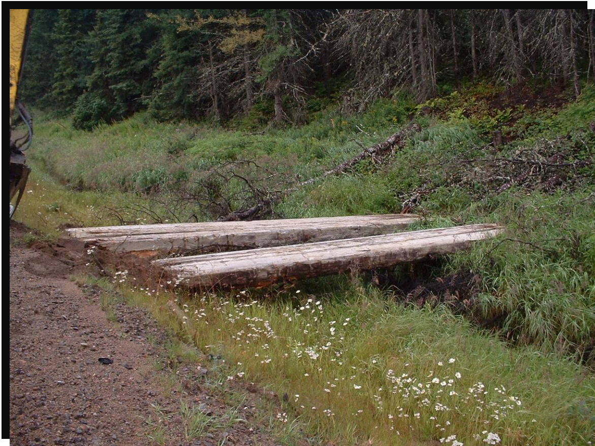
FIGURE 38 Utilisation d'un pontage temporaire pour la traversée d'un cours d'eau. Route 175 dans la réserve faunique des Laurentides, au kilomètre 149, rivière Pikauba. (2004.1076)
