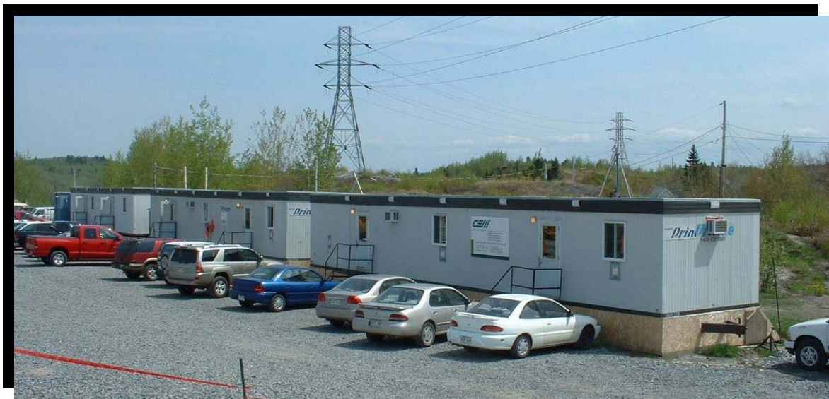
FIGURE 174 Bureaux de chantier lors de la construction du pont au-dessus de la rivière la Grande Décharge. Route 169 à Alma. (2003.1026)
