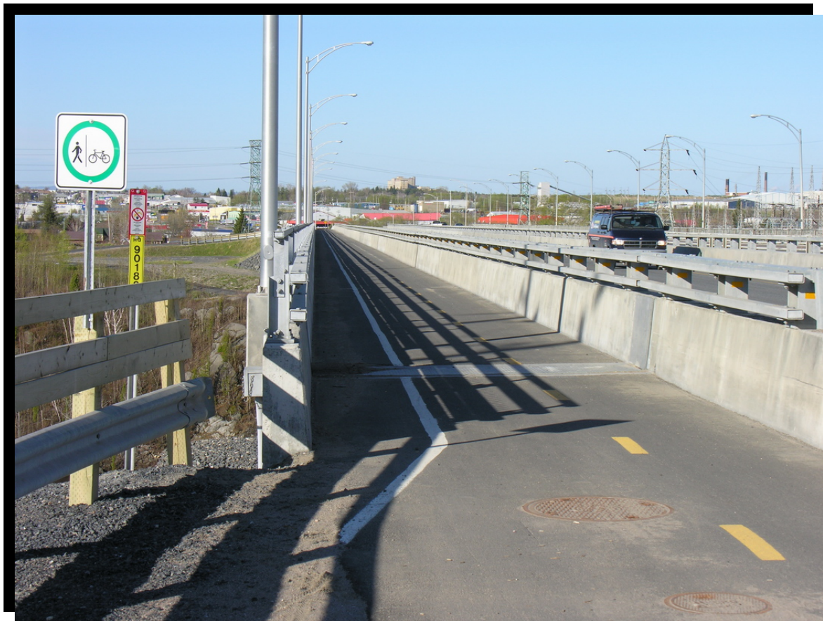
FIGURE 16 Route 169 à Alma, pont au-dessus de la rivière la Grande Décharge. (2003.1077) Aménagement d'une piste multifonctionnelle d'une largeur de 3,6 mètres à même le tablier du pont pour les piétons, les vélos et les motoneiges. (Composantes du milieu humain)
