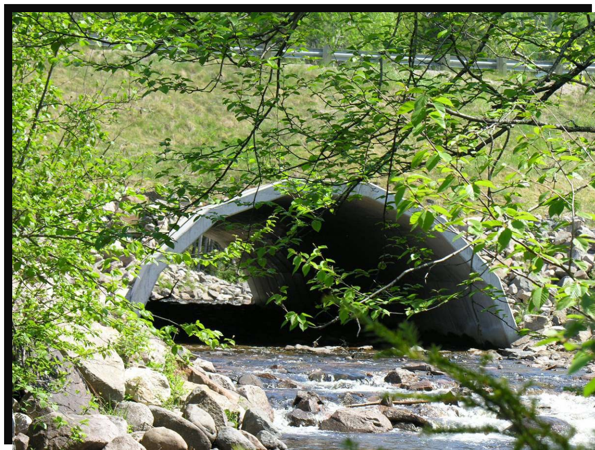
FIGURE 92 Ponceau voûté sur semelles, au-dessus de l'émissaire du Petit lac Saint-Germains. Reconstitution du lit du cours d'eau. Engazonnement et plantation sur les bandes riveraines. Route 172 à Sainte-Rose-du-Nord. (2005.1107)
