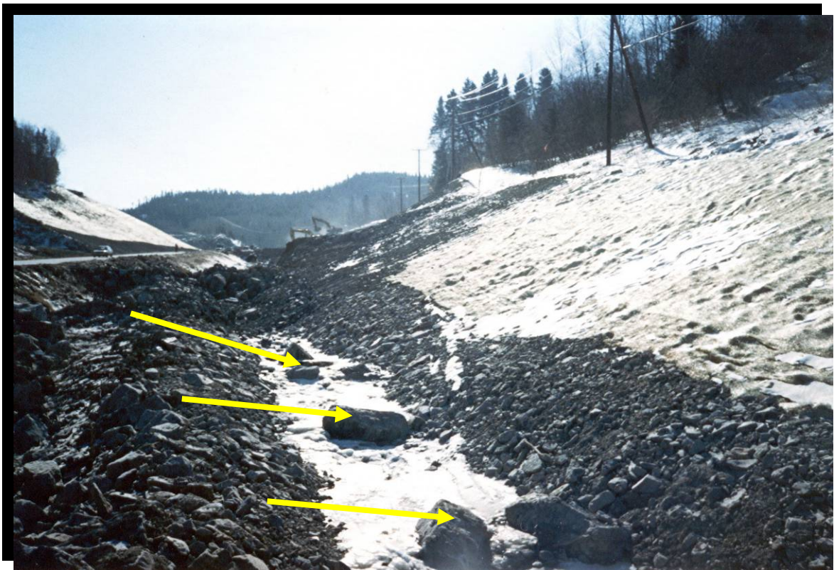
FIGURE 114 Blocs de pierre installés dans un fossé présentant une longue déclivité afin de réduire les vitesses d'eau. Route 170 à La Baie, côte à Caribou. (1996.1146)
