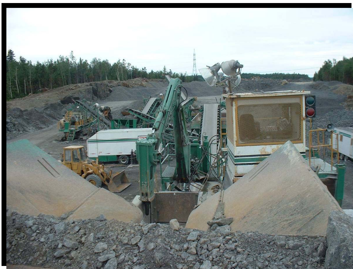
FIGURE 45 Activités de concassage dans l'emprise de l'autoroute en construction. Autoroute 70 à Jonquière, à l'ouest du pont de la rivière aux Sables. (2002.1125)
