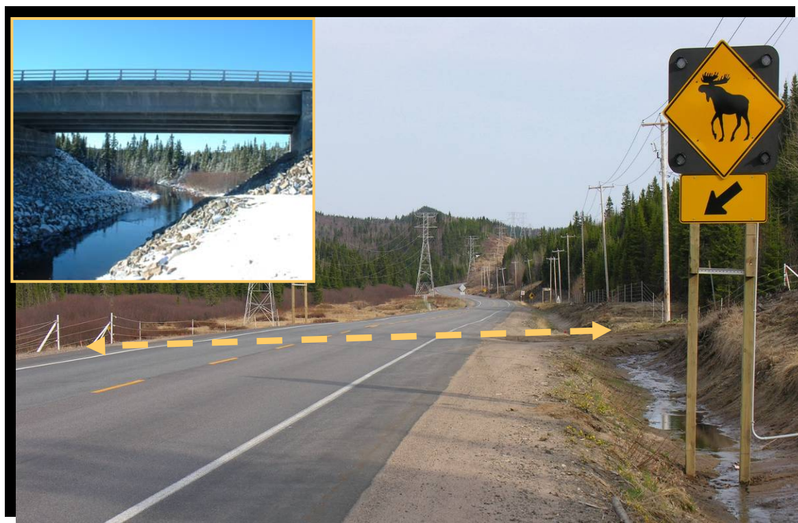
FIGURE 160 Passage pour la grande faune sur la chaussée de la route 169 (kilomètre 33) dans un secteur avec clôture électrique sur 10 km. Route à 2 voies à faible débit. Au coin gauche, passage pour la grande faune sous la chaussée de la route 175, au kilomètre 178, dans un secteur avec clôture électrique sur 5 km. Réserve faunique des Laurentides. (2005.1168)
