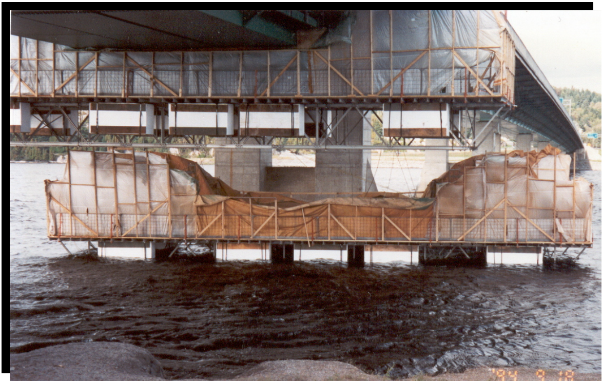
FIGURE 110 Décapage (sablage) par projection d'abrasifs (dans ce cas, des billes d'acier ont été utilisées) et peinture des poutres-caissons. Pont Dubuc au-dessus de la rivière Saguenay à Chicoutimi. (1994.1152)
