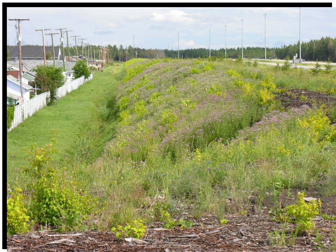
FIGURE 171 Butte antibruit d'une hauteur de 5,5 m, aménagée en bordure du quartier résidentiel de la rue Lesage. Autoroute 70 à Jonquière, secteur du carrefour Mathias. (2005.1177)
