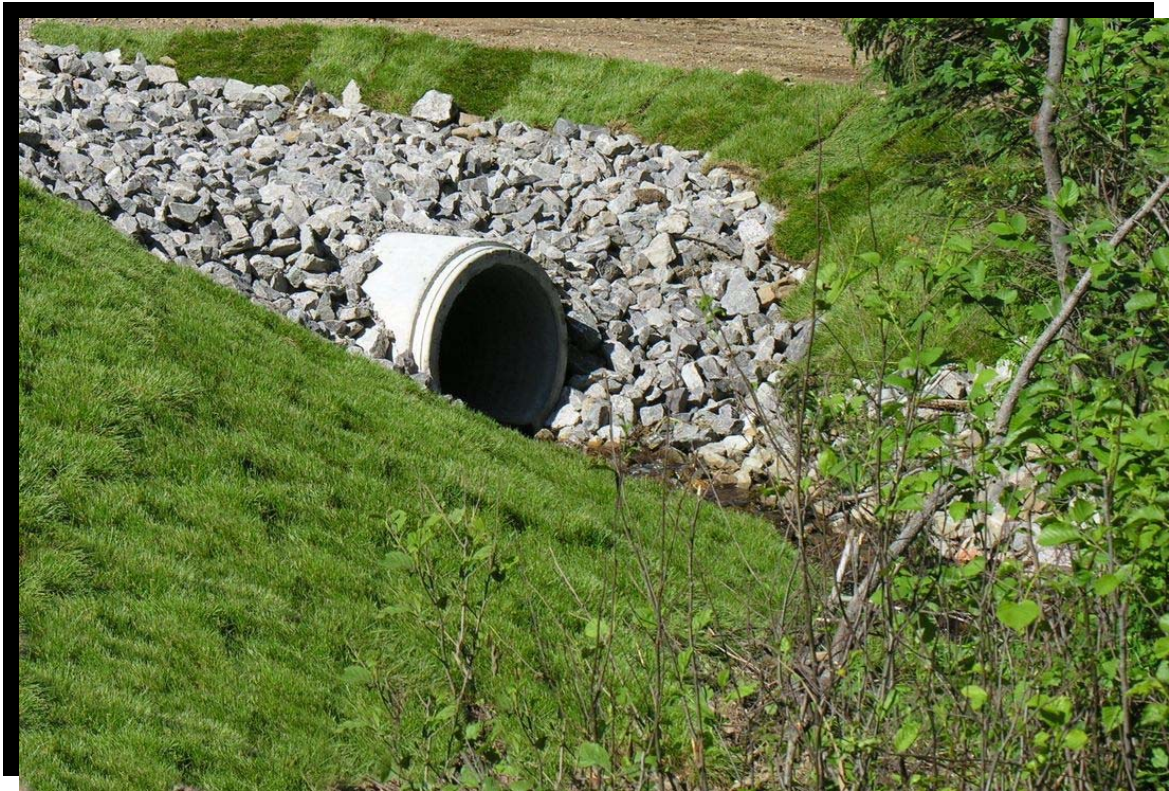
FIGURE 148 Stabilisation immédiate et permanente de la bande riveraine au droit d'un ponceau. Empierrement du ponceau et du lit du cours d'eau. Engazonnement au moyen de plaques de gazon. Route 155 à Lac-Bouchette, secteur de la côte Gagné. (2005.1162)
