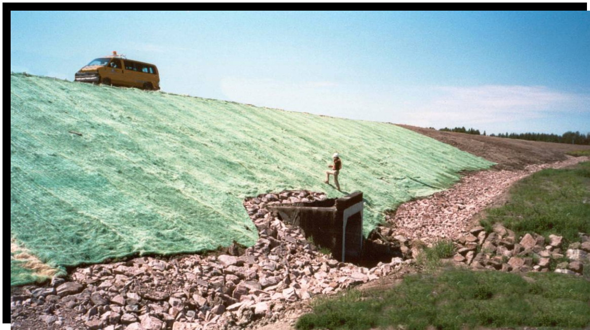
FIGURE 143 Stabilisation immédiate et permanente au droit d'un ponceau en zone de remblai. Empierrement des fossés, du ponceau et du lit du cours d'eau. Fosses de captation, engazonnement et matelas de fibre de bois. Végétation existante conservée près de l'emprise. Autoroute 70 à Jonquière, secteur de la savane. (2000.1040)
