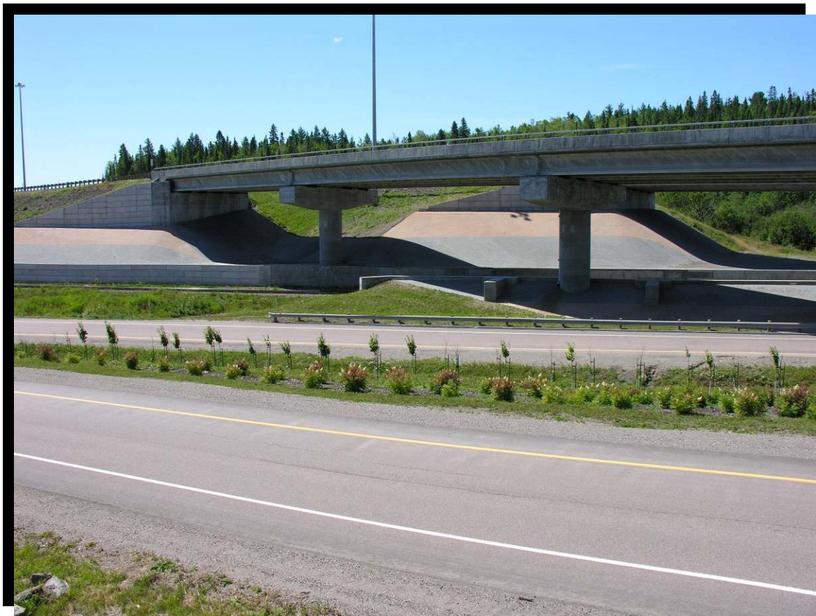
Figure 172 Aménagement paysager d'un carrefour étagé à la limite ouest de la ville de Saguenay. Engazonnement, plantation et pose de pavés (2 couleurs) au pied des culées. Autoroute 70 à Jonquière. (2005.1178)
