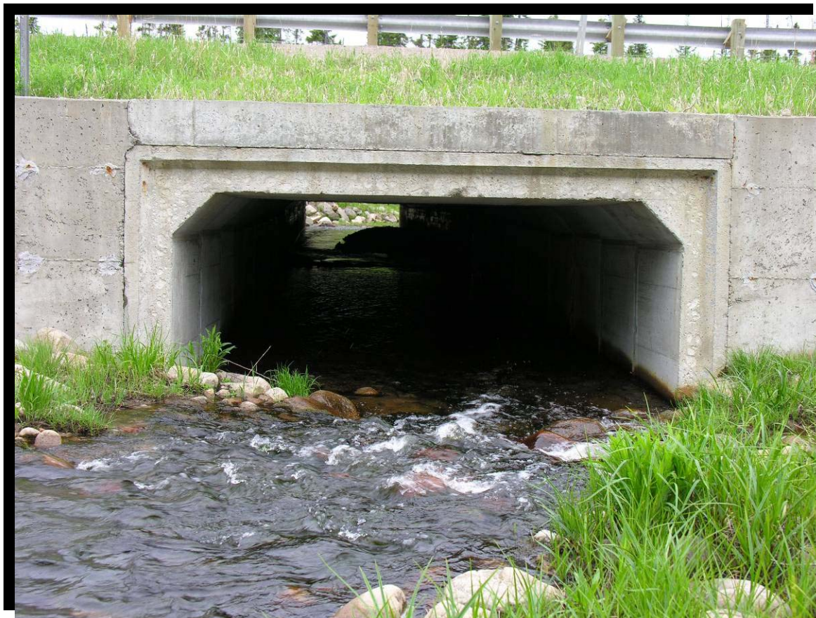
FIGURE 97 Ponceau rectangulaire en béton armé (PBA) dans l'émissaire du lac Grelon. Reconstitution du lit du cours d'eau sur le radier. Route 175 dans la réserve faunique des Laurentides, au kilomètre 166. (2005.1110)
