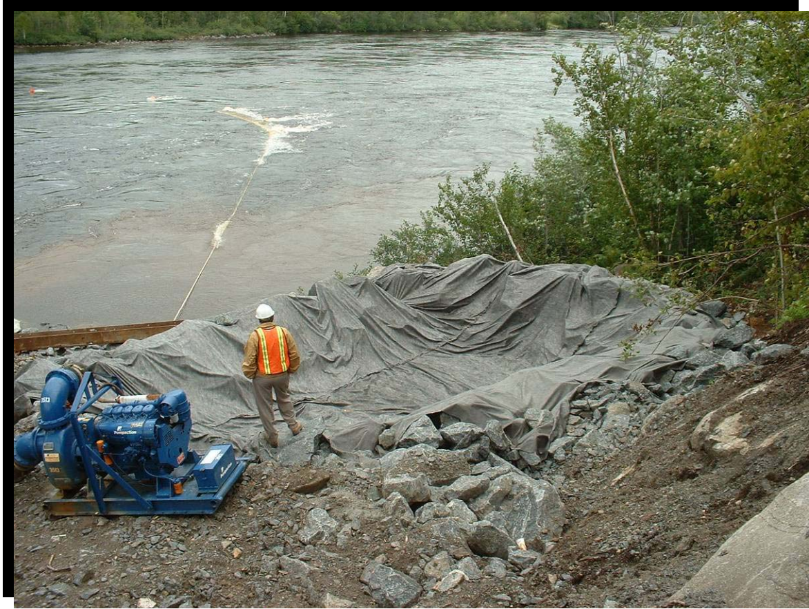
FIGURE 122 Bassin de sédimentation. Route 169 à Alma, pont de la rivière la Grande Décharge. (2002.1032)
