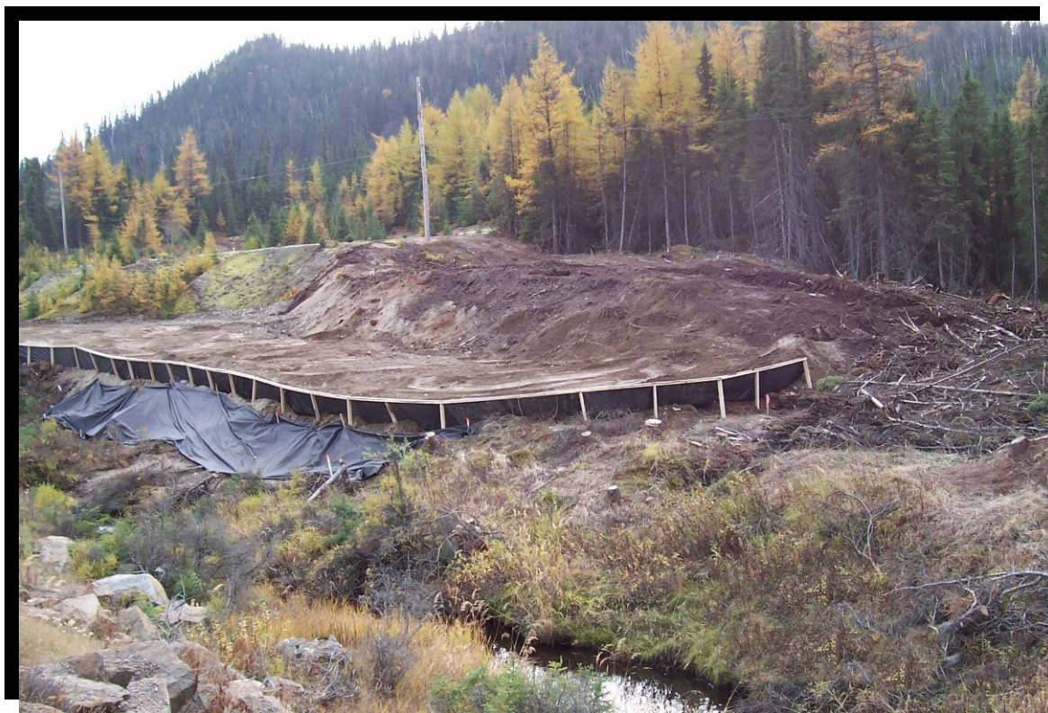
FIGURE 134 Utilisation d'une barrière géotextile près d'un tributaire de la rivière Pikauba. Route 175 dans la réserve faunique des Laurentides, au kilomètre 151. (2004.1061)
