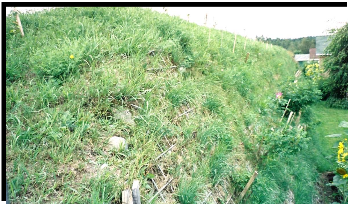
FIGURE 27 Route 170 à Larouche. (2001.1025) Construction d'une butte antibruit constituée d'un remblai renforcé par des géotextiles avec talus végétal de type Textomur, afin d'éviter l'acquisition supplémentaire de terrain privé résidentiel. (Composantes bruit et acquisition du milieu humain)
