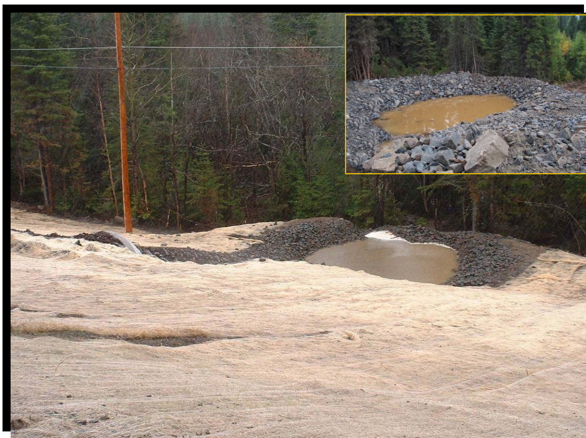
FIGURE 121 Bassin de sédimentation permanent. Route 175 dans la réserve faunique des Laurentides, au kilomètre 189, secteur du lac des Uries. (2003.1082)
