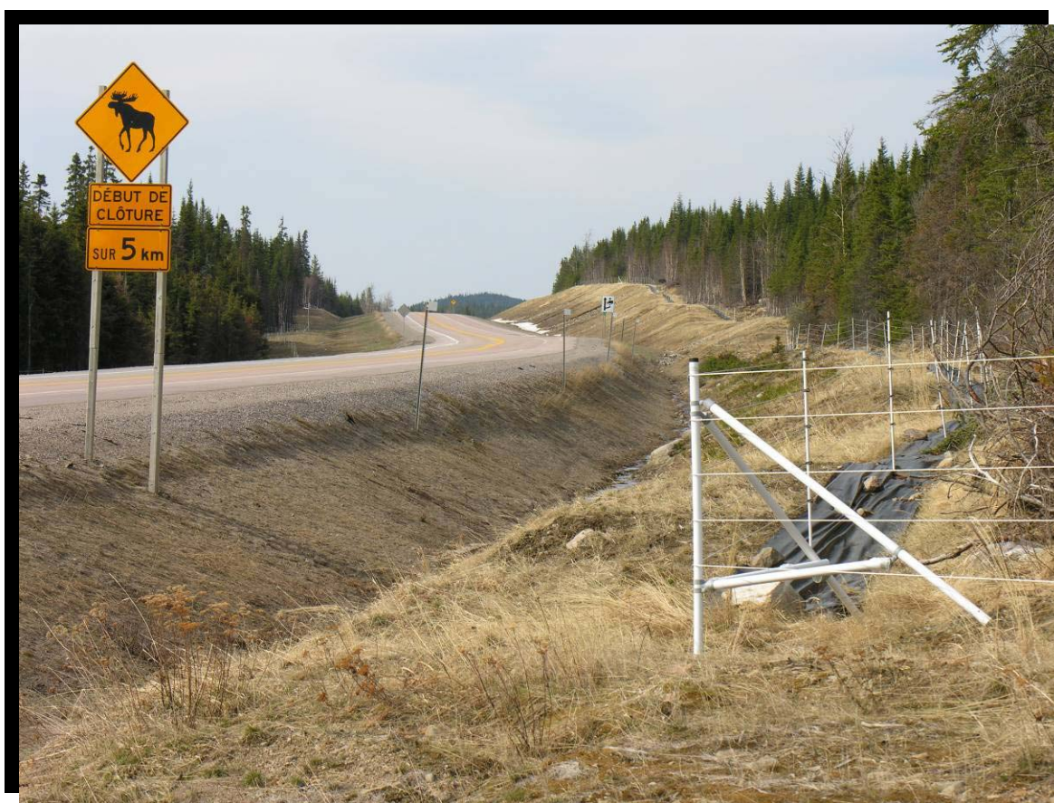
FIGURE 159 Clôture électrique et panneau de signalisation surdimensionné avec panonceaux, dans l'emprise de la route 175, du kilomètre 175 au kilomètre 180. Réserve faunique des Laurentides, secteur du lac Tourangeau. (2005.1170)
