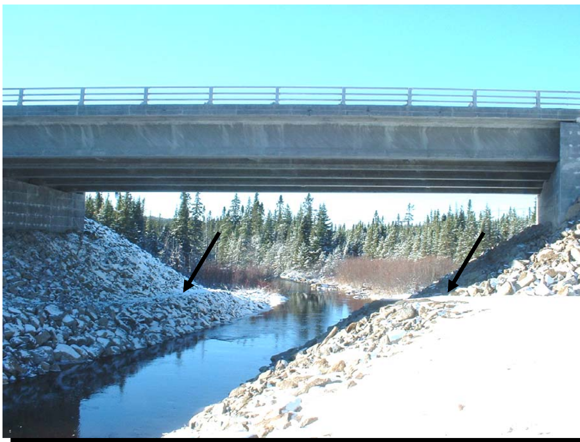
FIGURE 10 Route 175 dans la réserve faunique des Laurentides, secteur du lac Tourangeau, au kilomètre 177,7. (2002.1009) Aménagement d'un passage pour la grande faune sous la structure de l'émissaire du lac Tourangeau dans une section de 5 km (du kilomètre 175 au kilomètre 180) protégée par des clôtures électriques . ( Composante grande faune du milieu naturel biologique )
