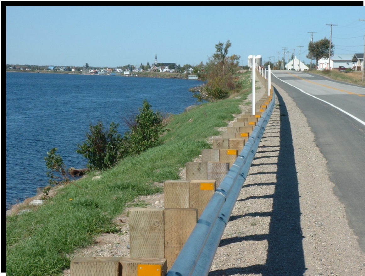
FIGURE 59 Remblai pour l'élargissement de l'accotement et la pose de glissières de sécurité. Protection de la végétation existante au pied du talus en bande riveraine et engazonnement. Route 169 à Pérignon en bordure de la rivière Pérignon. (2001.1002)
