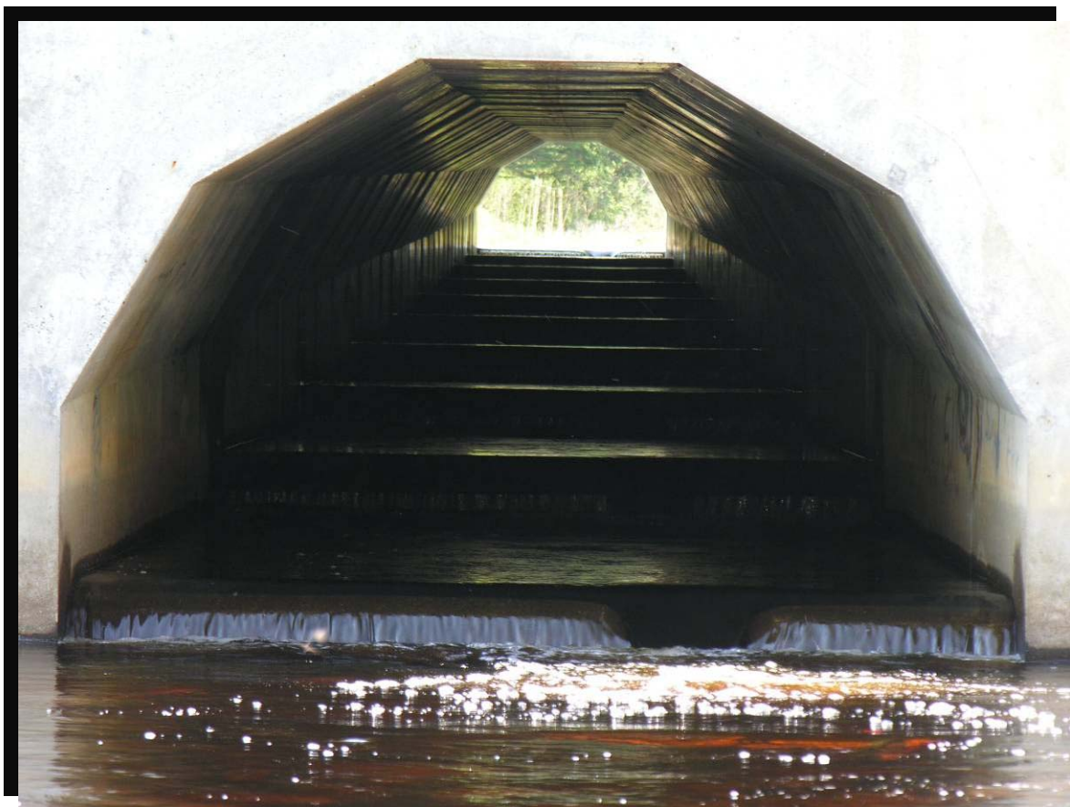
FIGURE 94 Ponceau voûté avec radier dans l'émissaire du lac Goth. Déversoirs pour la montaison de l'omble de fontaine. Route 170 à Saint-Félix-d'Otis. (2005.1109)
