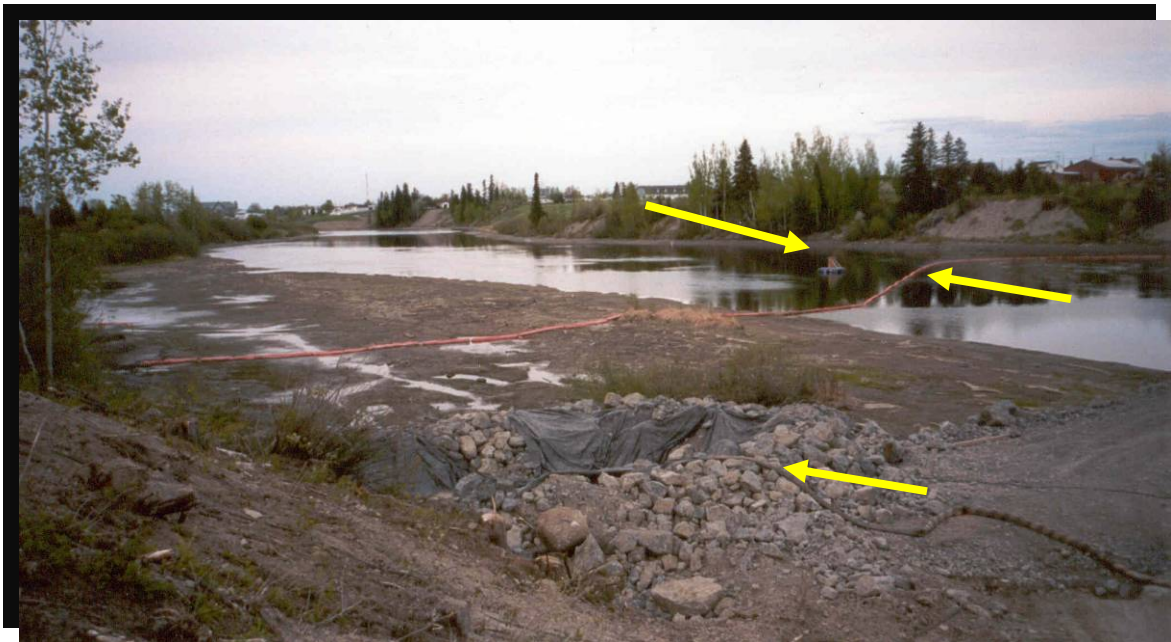
FIGURE 39 Utilisation d'une estacade flottante en aval des travaux et vue d'un bassin de sédimentation. Balisage installé conformément à la Loi sur la protection des eaux navigables. Autoroute 70 à Jonquière, pont de la rivière aux Sables. (2000.1049)
