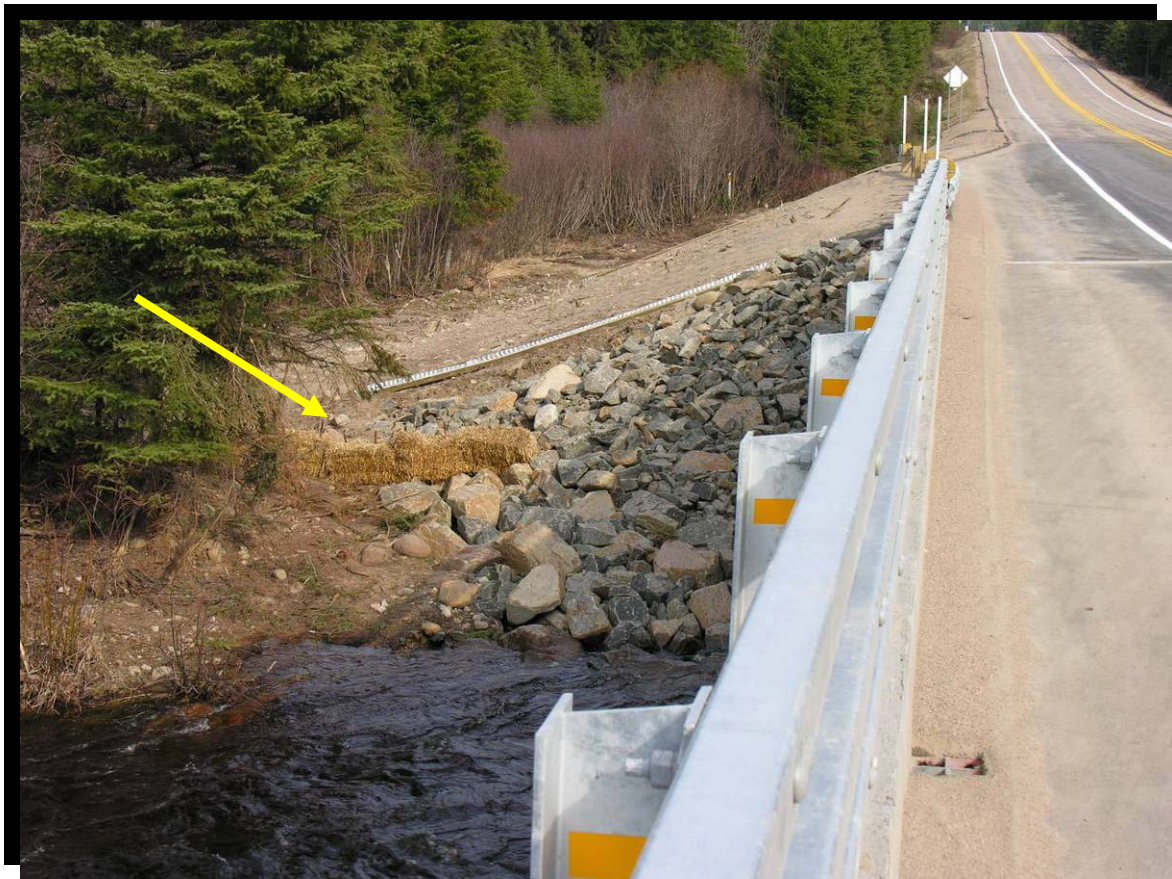
FIGURE 130 Filtre en ballots de paille dans un fossé en attente de l'engazonnement. Route 169 dans la réserve faunique des Laurentides, au kilomètre 13, pont de la rivière Pikauba. (2005.1093)
