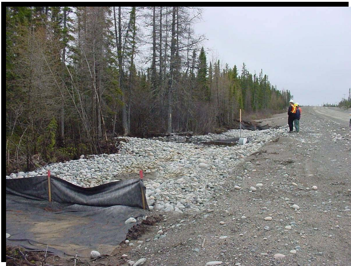
FIGURE 135 Utilisation de barrières géotextiles dans un fossé. Chemin d'accès au village des Cris d'Oujé-Bougoumou, Nord-du-Québec. (2004.1092)
