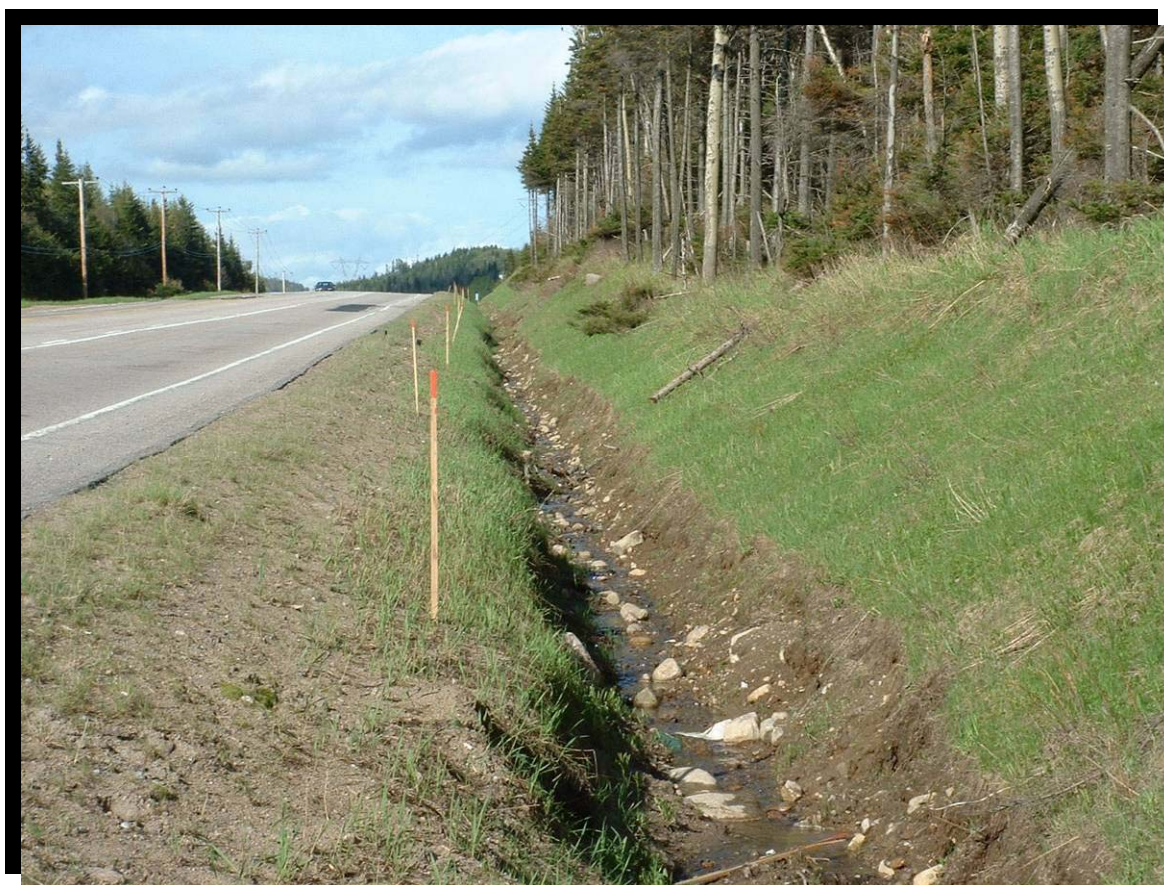
FIGURE 117 Nettoyage d'un fossé par la méthode du tiers inférieur. (0000.1149)
