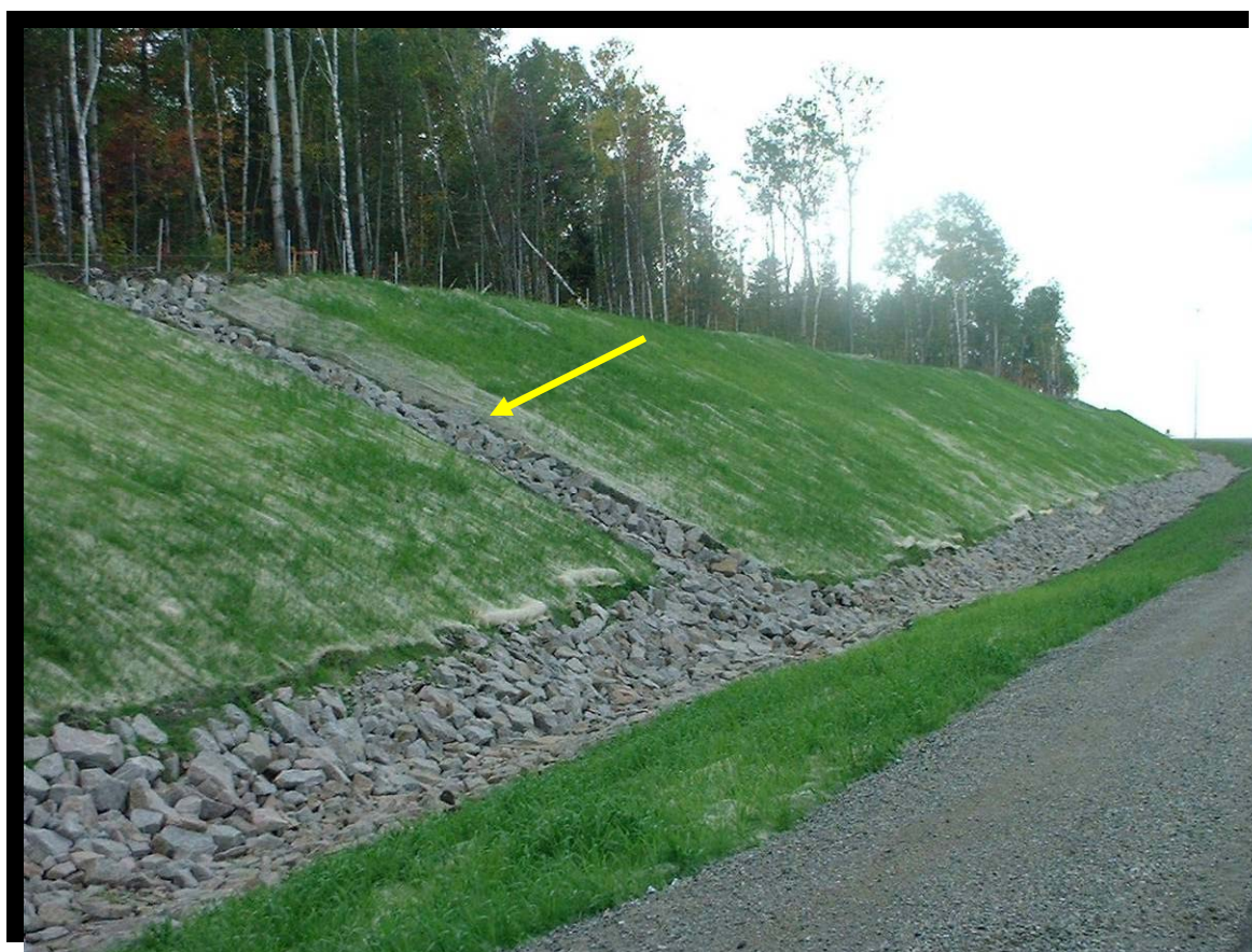
FIGURE 52 Stabilisation par empierrement d'une résurgence dans un talus de déblai. Autoroute 70 à Jonquière, secteur du ruisseau Jean-Dechêne. (2001.1041)
