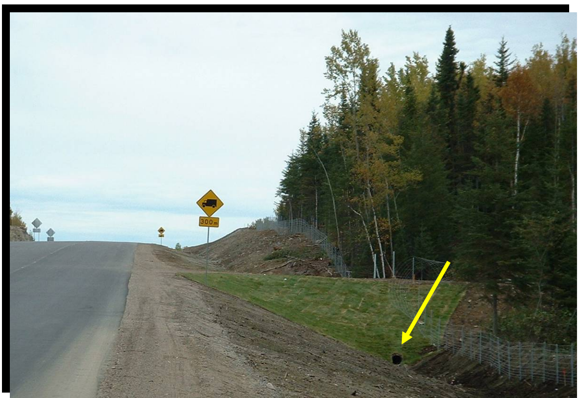
FIGURE 104 Tuyau en thermoplastique sous une entrée privée. Stabilisation des extrémités des talus de l'entrée privée avec engazonnement au moyen de plaques de gazon. Route 155 à Lac-Bouchette, secteur de la côte Gagné. (2002.1118)
