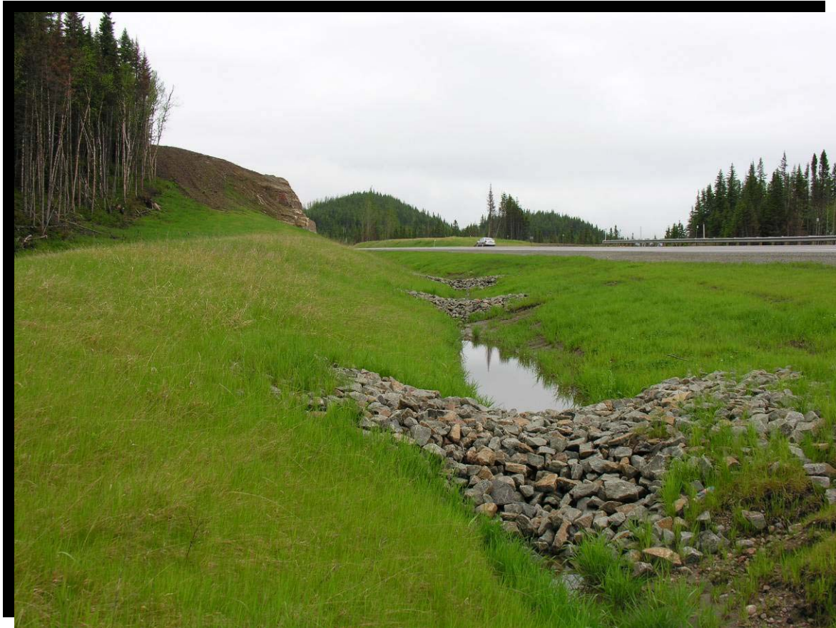
FIGURE 115 Bermes filtrantes permanentes installées dans un fossé présentant une longue déclivité afin de réduire les vitesses d'eau. Route 175 dans la réserve faunique des Laurentides, au kilomètre 189, secteur du lac des Uries. (2004.1132)
