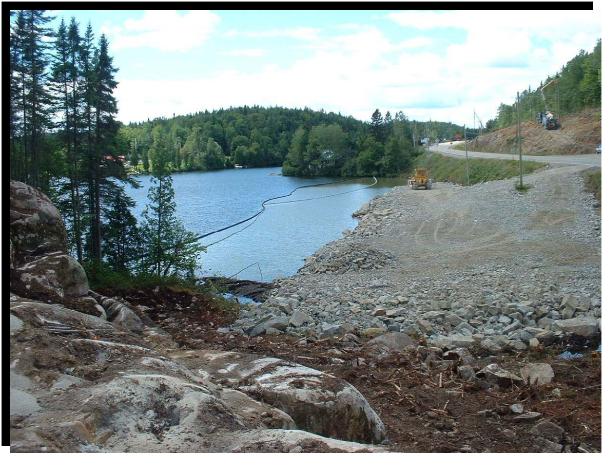
FIGURE 138 Utilisation d'un rideau de confinement retenu au fond de l'eau au droit de travaux de remblai dans le lac Bouchard, doublée du côté des travaux d'une estacade flottante de rouleaux absorbants. Longueur de 180 mètres et profondeur d'eau variant de 0 à 3,5 m. Route 172 à Sainte-Rose-du-Nord. (2005.1181)
