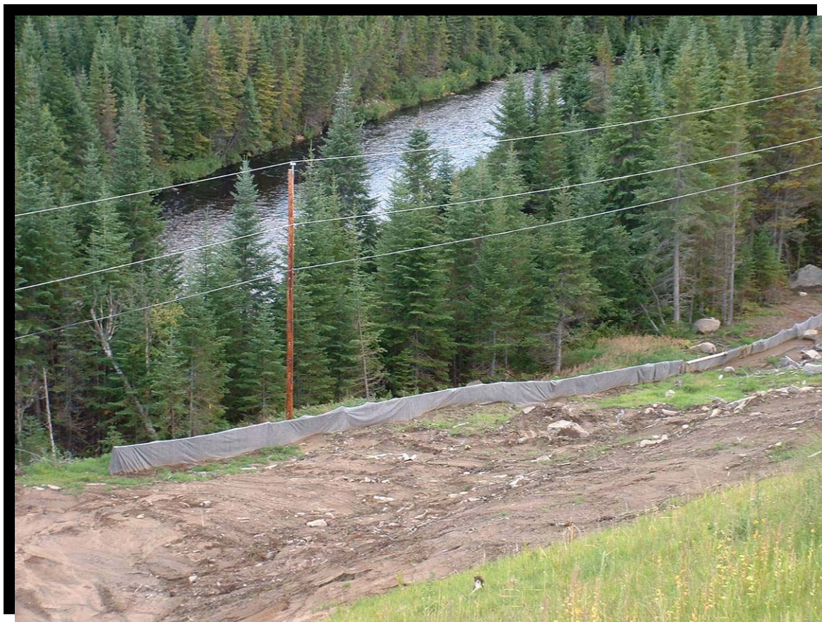
FIGURE 133 Utilisation d'une barrière géotextile près de la rivière Cyriac. Route 175 dans la réserve faunique des Laurentides, au kilomètre 189, secteur du lac des Uries. (2004.1060)
