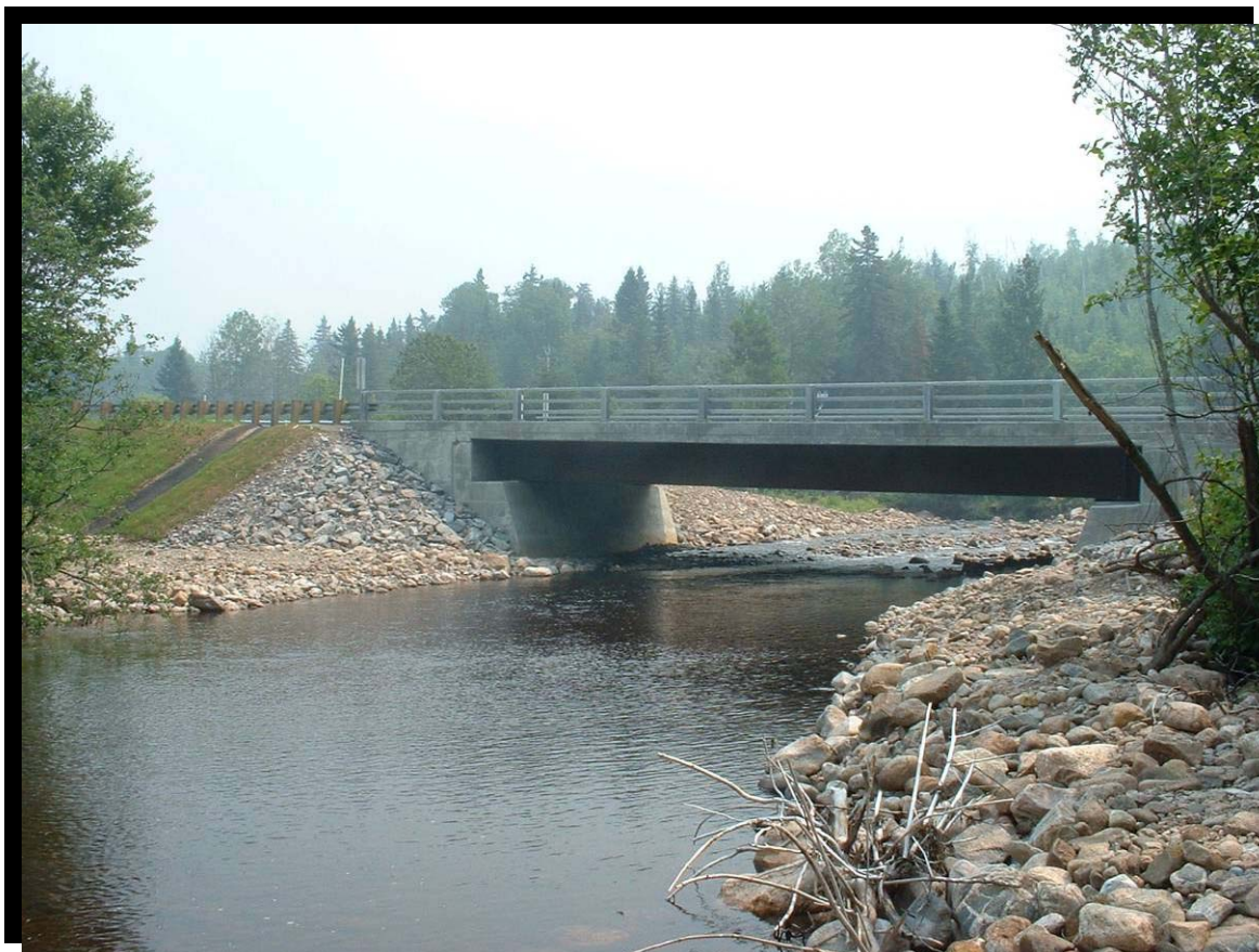
FIGURE 89 Pont à poutre d'acier, au-dessus de la rivière des Commissaires ou Quaquakamaksis. Reconstitution du lit du cours d'eau. Engazonnement et plantation sur les bandes riveraines. Route 155 à Lac-Bouchette. (2002.1105)
