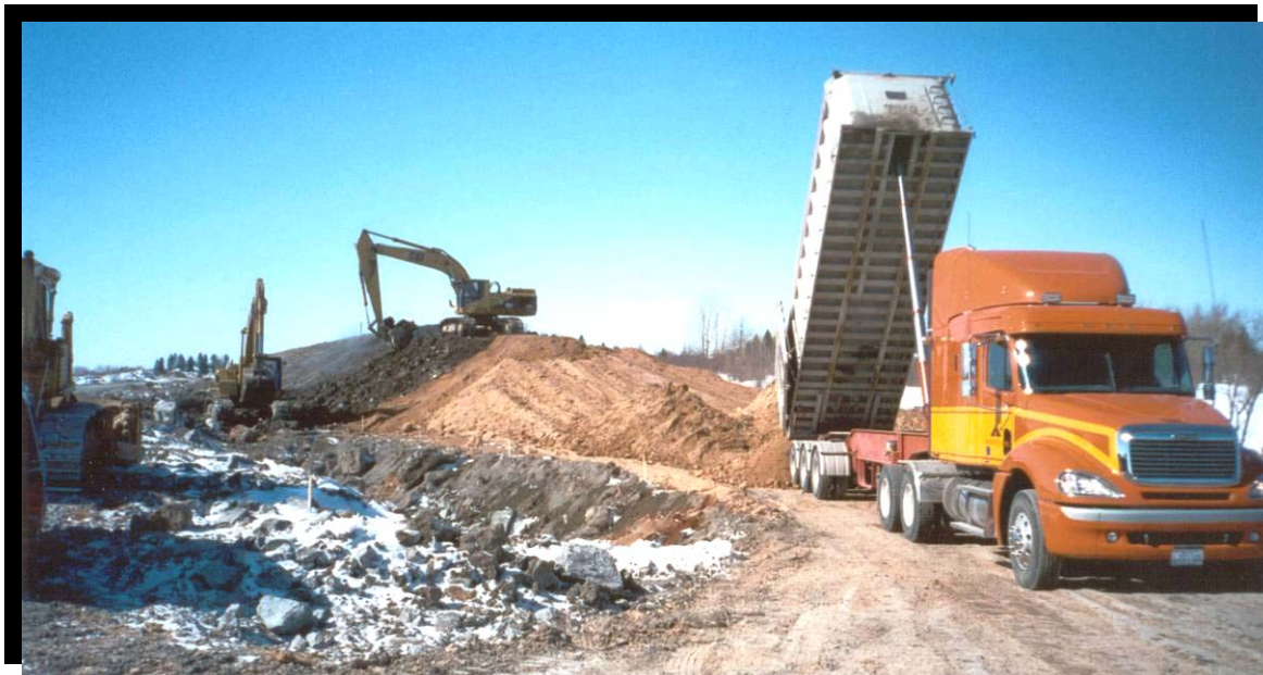
FIGURE 23 Autoroute 70 à Jonquière, secteur du carrefour Saint-Hubert. (2001.1021) Utilisation de sciure de bois dans la construction d'une butte antibruit en raison d'une problématique de capacité portante de sol nécessitant un remblai léger. (Composante sol du milieu naturel physique et mise en valeur de matières résiduelles)
