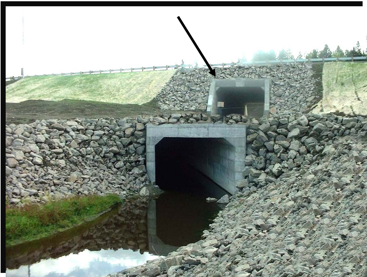
FIGURE 17 Autoroute 70 à Jonquière, secteur du ruisseau Jean-Dechêne. (2001.1014) Structure pour la traverse des motoneiges , ponceau rectangulaire de 6 mètres de largeur par 4 mètres de hauteur et 69 mètres de longueur avec platelage de bois. Cette structure a été conçue pour le passage d'une surfaceuse de sentier de motoneige pouvant mesurer jusqu'à 3,38 mètres (11 pieds - 1 pouce) de largeur sur 3,10 mètres (10 pieds - 2 pouces) de hauteur et 12,45 mètres (40 pieds - 10 pouces) de longueur. (Composante véhicules hors route du milieu humain)
