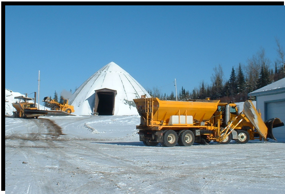
Figure 178 Entrepôt et machinerie pour l'entretien hivernal. (2005.1188)
