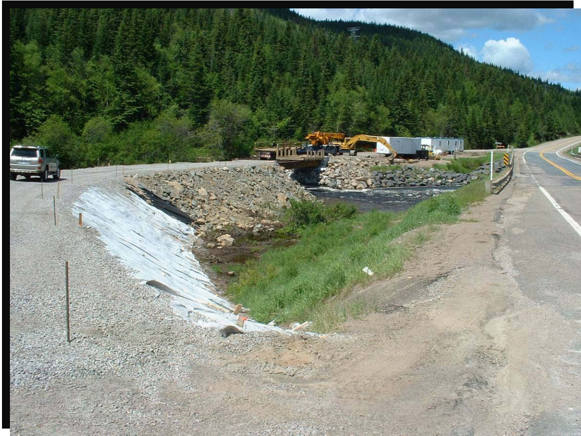
FIGURE 77 Chemin de déviation temporaire au-dessus de la rivière Pikauba. Stabilisation des talus du chemin par empierrement dans la section du cours d'eau et à l'aide de membrane géotextile dans la section de la bande riveraine. Conservation de la végétation (filtre naturel) en aval des fossés. Route 169 dans la réserve faunique des Laurentides, au kilomètre 13. (2004.1133)
