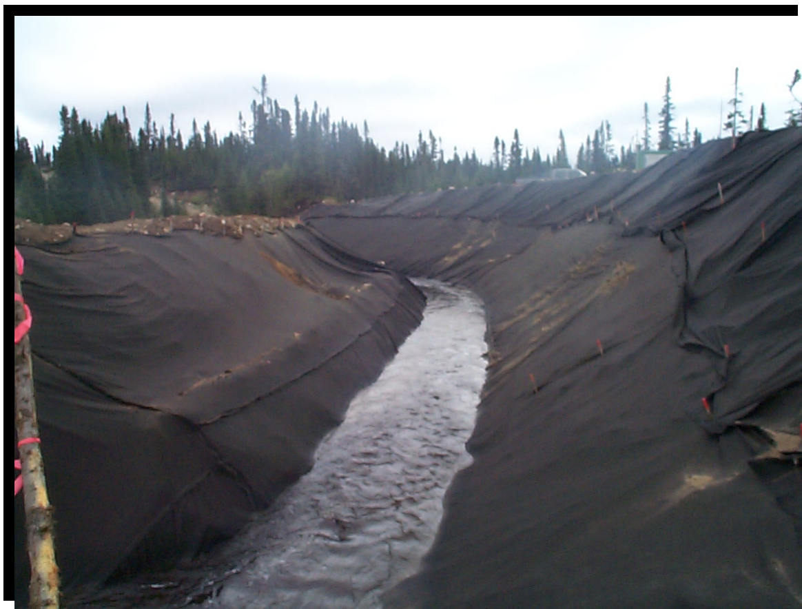
FIGURE 73 Canal de dérivation temporaire sur membrane. Photo du ministère des Ressources naturelles et de la Faune du Québec. (2005.1180)
