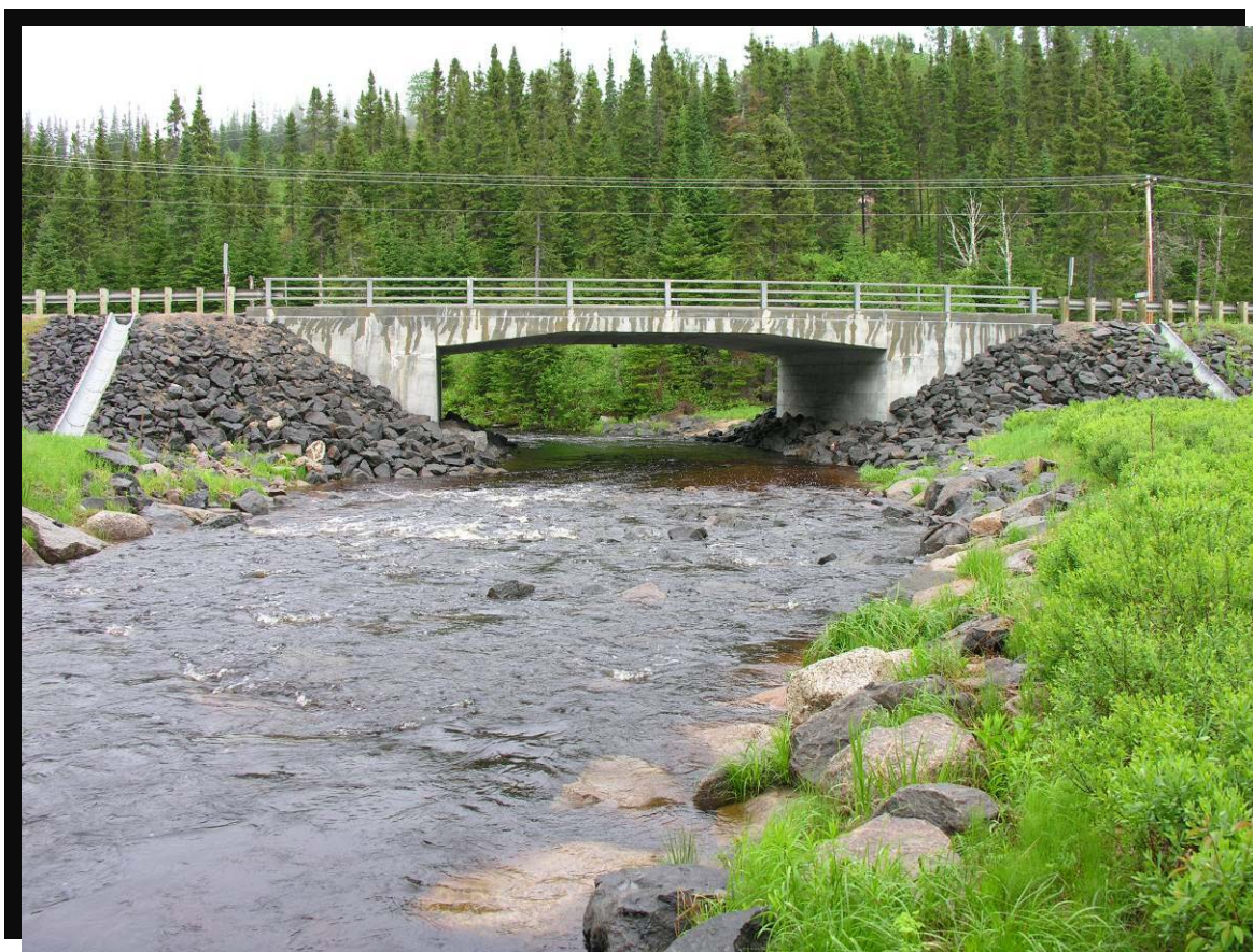
FIGURE 91 Portique à dalle épaisse sur semelles, au-dessus de la rivière Sawine. Reconstitution du lit du cours d'eau. Engazonnement et plantation sur les bandes riveraines. Route 169 dans la réserve faunique des Laurentides, au kilomètre 43. (2002.1106)
