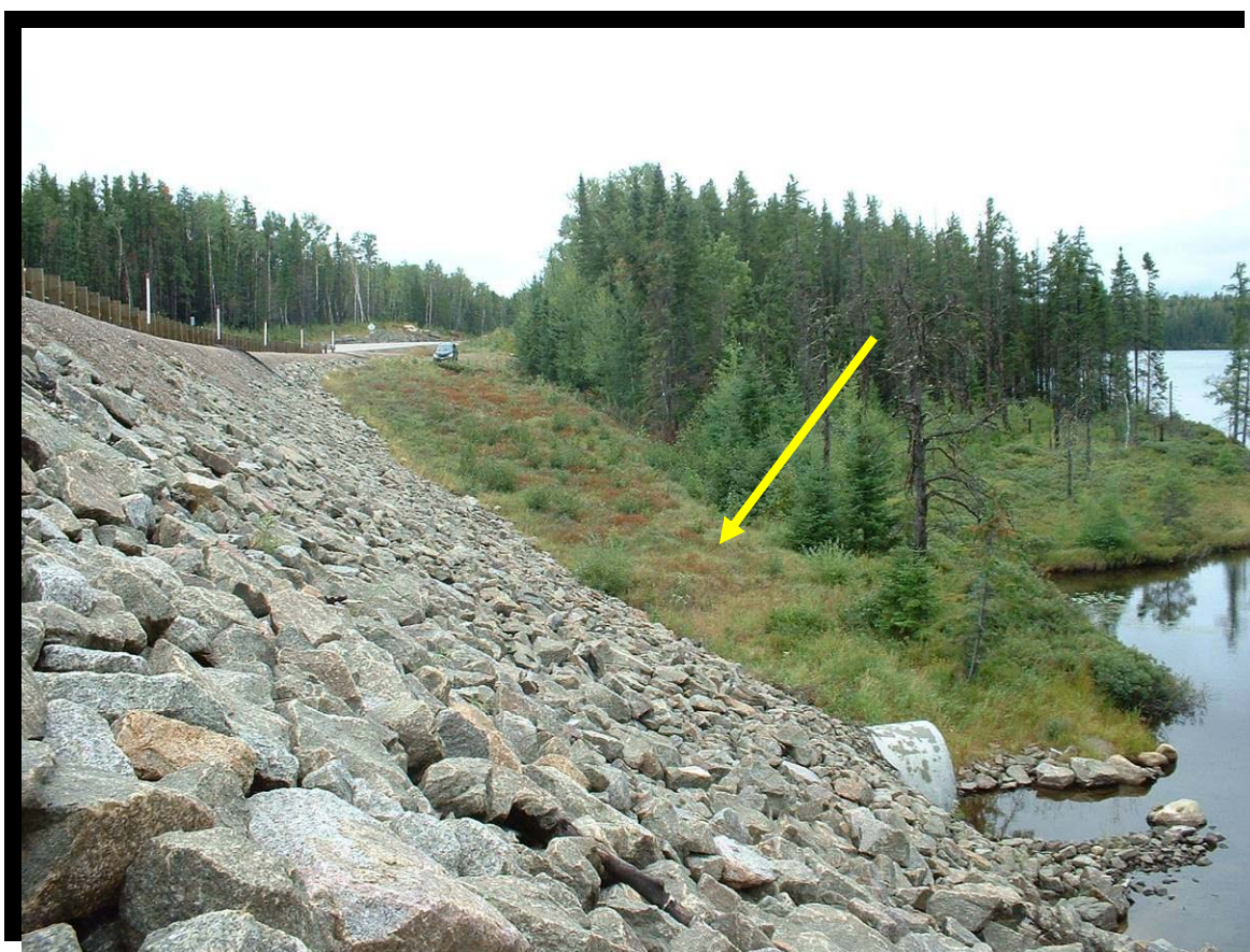
FIGURE 98 Ponceau circulaire en béton armé (TBA) dans l'émissaire du lac du Cran. Engazonnement et plantation des bandes riveraines et du chemin d'accès. Route 167 dans la réserve faunique Ashuapmushuan, au kilomètre 46. (2002.1113)
