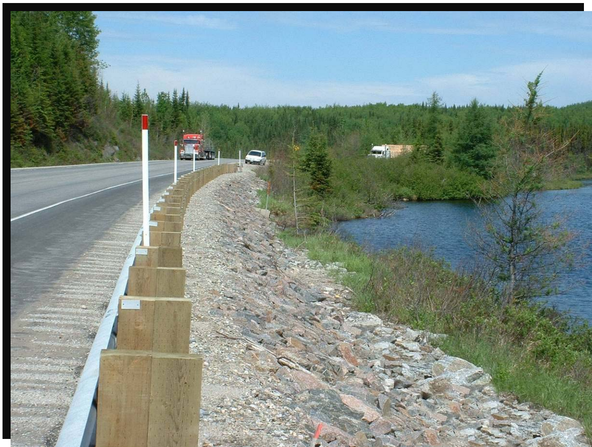
FIGURE 58 Remblai pour l'élargissement de l'accotement et la pose de glissières de sécurité. Protection de la végétation existante au pied du talus en bande riveraine. Route 167 dans la réserve faunique Ashuapmushuan, au kilomètre 158, lac des Bleuets. (2003.1067)
