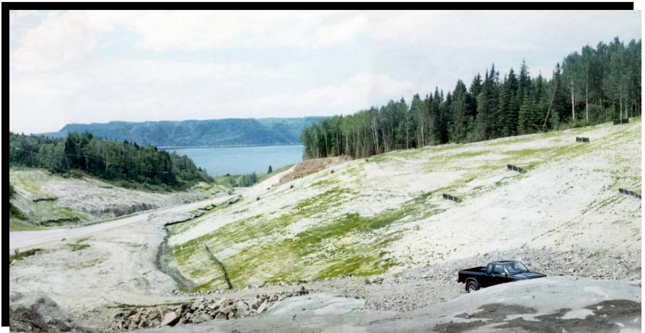
FIGURE 132 Utilisation de barrières géotextiles sur de longs talus de déblai d'argile. Route 170 à La Baie, côte à Caribou. (1996.1091)
