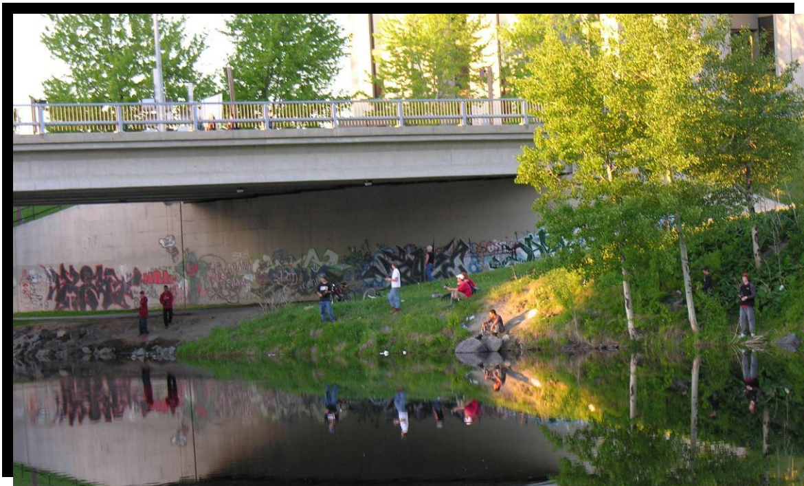
FIGURE 166 Activité de « Pêche en ville » dans la rivière aux Sables en aval des travaux de construction d'un pont. Autoroute 70 à Jonquière. (2000.1158)
