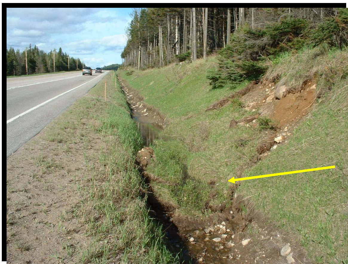
FIGURE 118 Nettoyage d'un fossé par la méthode du tiers inférieur. Il faut être prudent dans l'application de cette méthode afin de prévenir les possibles glissements de talus de déblai lorsque les pentes sont fortes. (0000.1150)
