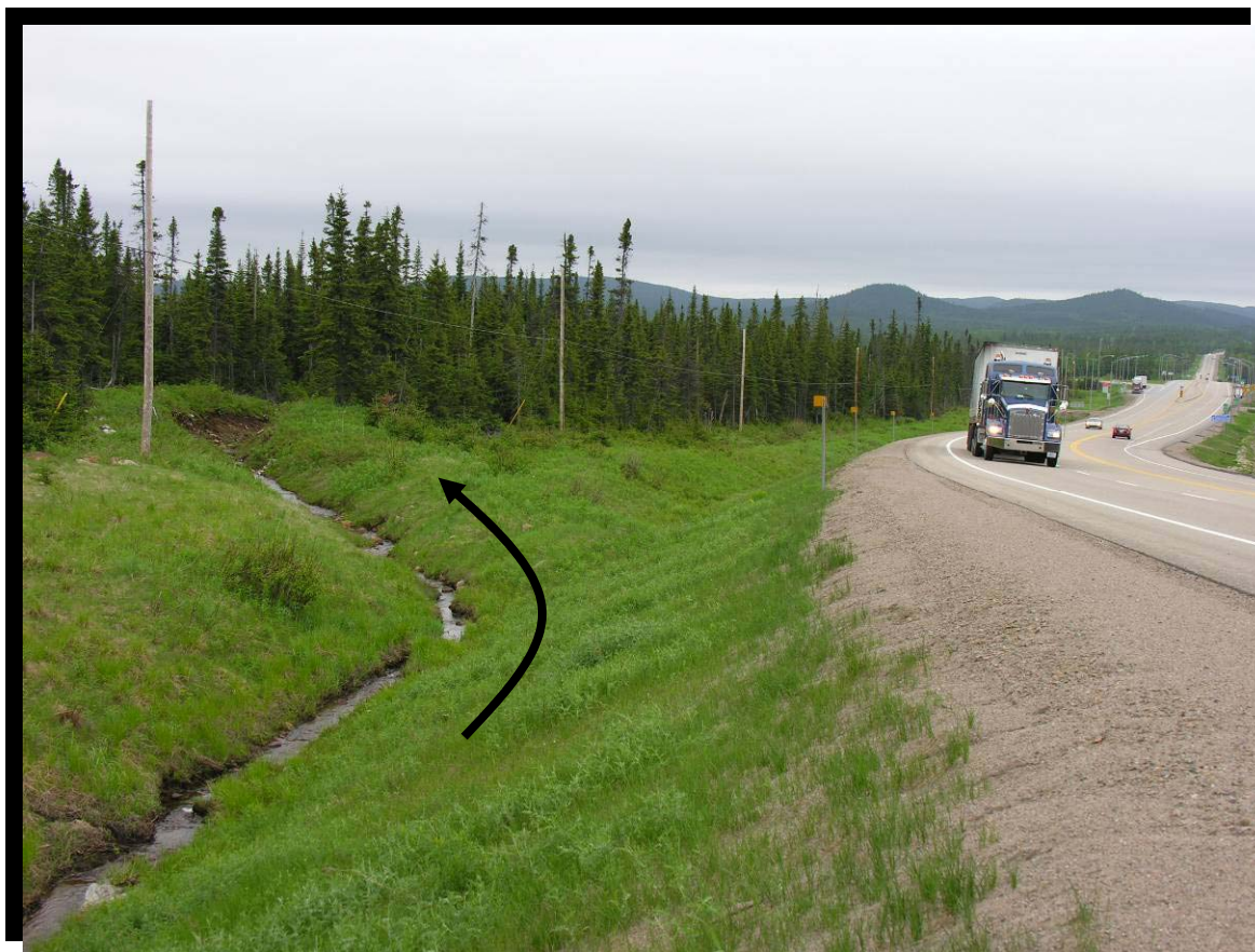
FIGURE 111 Détournement d'un fossé vers une zone de végétation. Route 175 dans la réserve faunique des Laurentides, au kilomètre 165, près de l'intersection de la route 169. (2005.1143)
