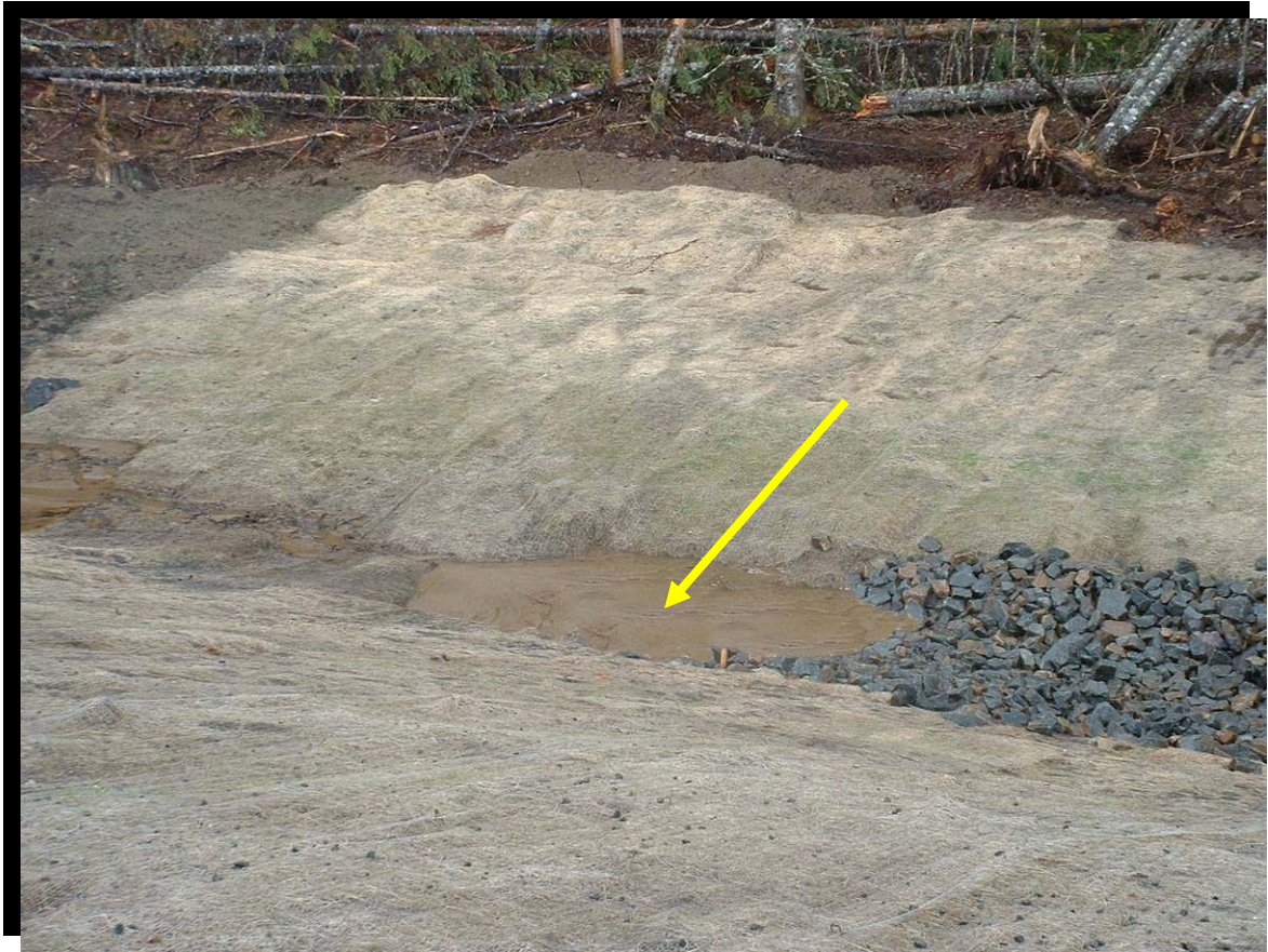
FIGURE 113 Fosse de captation des sédiments creusée à l'amont de l'empierrement d'un fossé. Route 175 dans la réserve faunique des Laurentides, au kilomètre 188, secteur du lac des Uries. (2004.1145)
