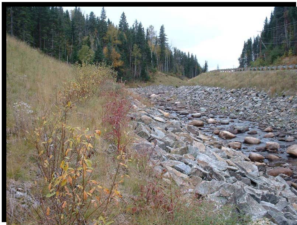
Figure 69 Déplacement d'un cours d'eau pour la reconstruction d'une route. - Stabilisation des sols par la technique de plantation : fagots et matelas de branches confectionnés avec des branches de cornouillers stolonifères, le tout mis en place sur une couche de terre végétale d'une épaisseur minimale de 200 mm. La terre végétale peut être remplacée par du terreau ou du compost. - Dans ce cas, le diamètre des branches prélevées pour la confection des fagots varie entre 15 mm et 25 mm et la longueur varie entre 1 500 mm et 2 000 mm. Le diamètre des branches prélevées pour la confection du matelas de branches varie entre 15 mm et 30 mm et la longueur varie entre 1 200 mm et 1 500 mm. - Le matelas de branches est recouvert de terre végétale et d'une natte de jute et fixé contre le sol avec des fils métalliques galvanisés. - Les travaux de végétalisation sont exécutés au printemps ou à l'automne mais idéalement l'automne. Route 381 à Ferland-et-Boilleau, rivière Bras d'Hamel. (1999.1072)
