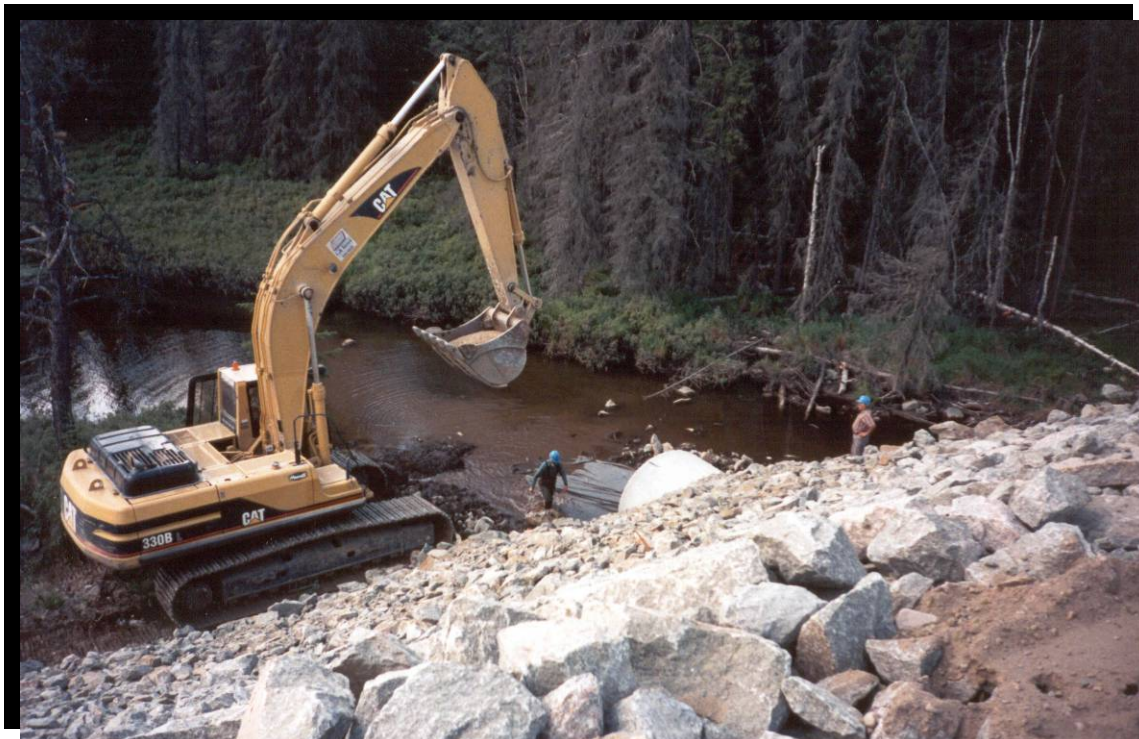
FIGURE 150 Ponceau circulaire en béton armé (TBA) dans l'émissaire du lac du Cran. Aménagement d'une frayère pour l'omble de fontaine en amont du ponceau. Route 167 dans la réserve faunique Ashuapmushuan, au kilomètre 46. (1998.1112)
