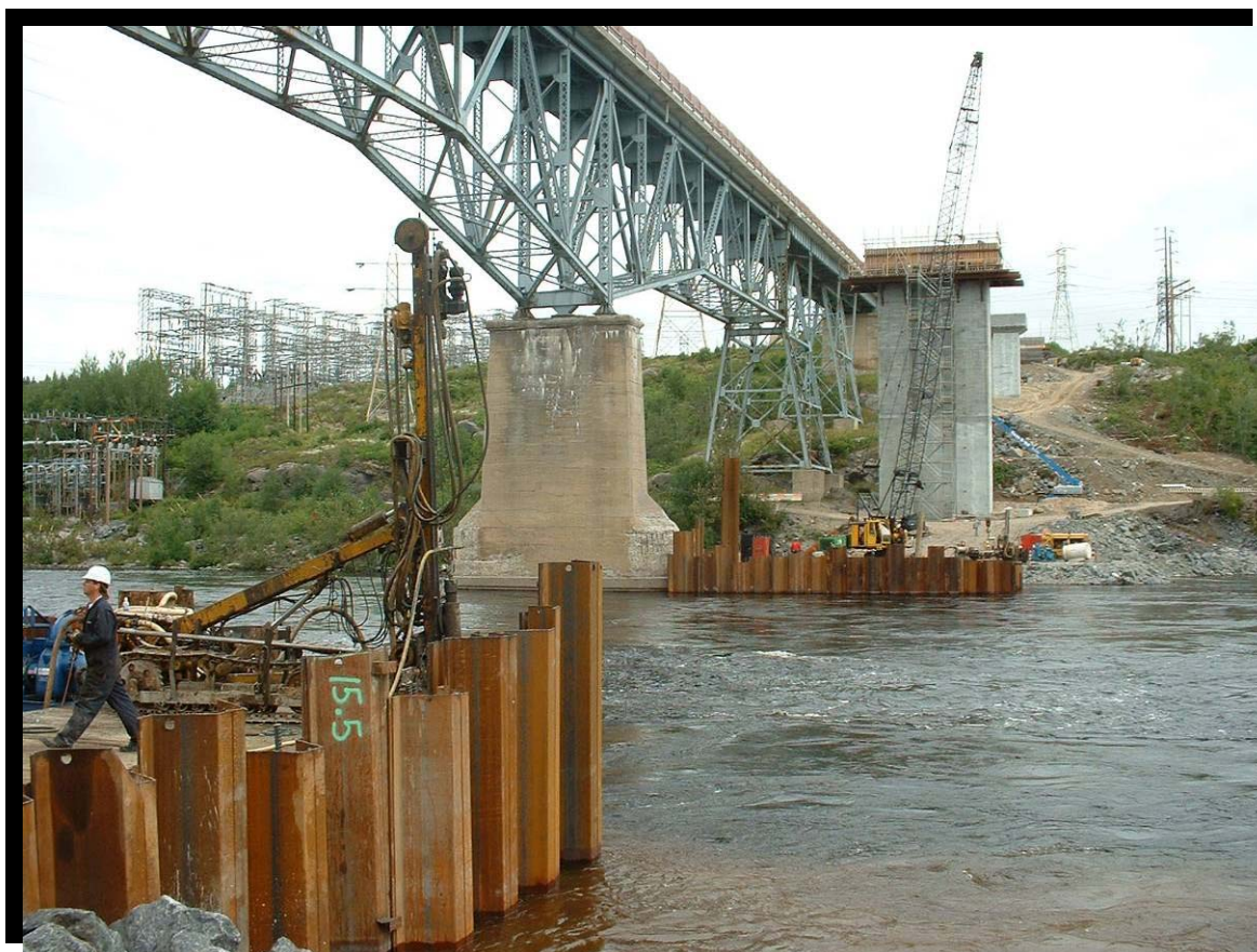
FIGURE 83 Batardeaux aménagés dans la rivière la Grande Décharge pour la construction de piliers. Matériaux utilisés : palplanches d'acier plantées sur roc, blocs et graviers. Route 169 à Alma. (2002.1140)
