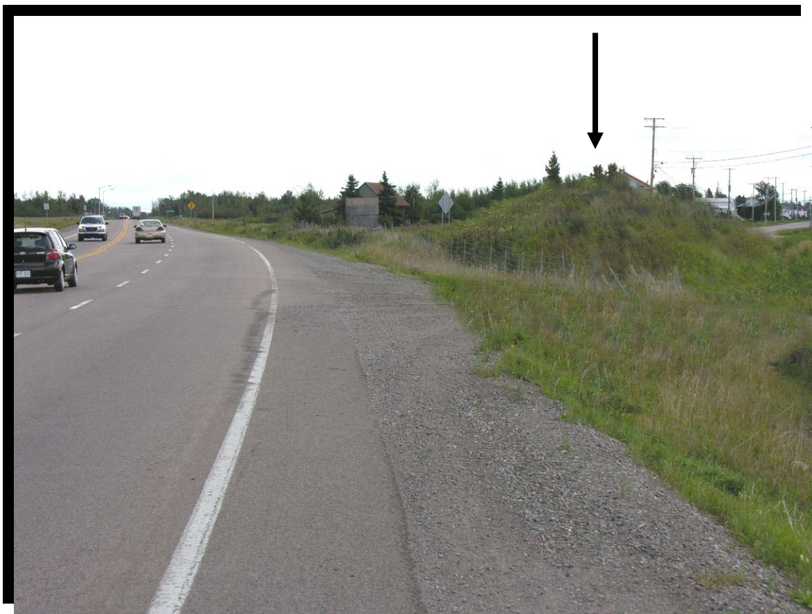
FIGURE 169 Écran visuel pour masquer l'ancien corridor de la route par rapport au nouveau tracé. Route 169, contournement nord à Roberval. (2005.1175)
