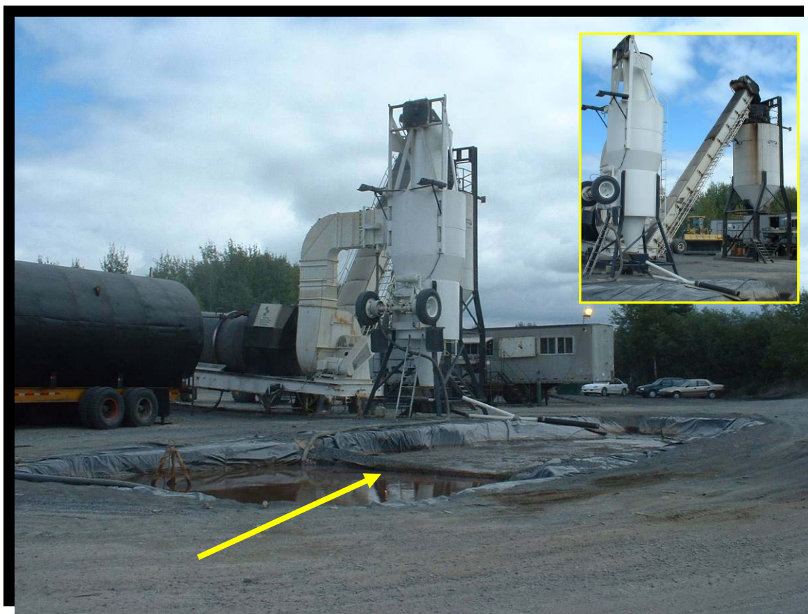
FIGURE 46 Étang de sédimentation d'une usine de béton bitumineux adjacent à l'emprise de l'autoroute en construction. Au coin droit, vue du site d'un autre angle. Autoroute 70 à Jonquière, dans le secteur du rang Saint-Benoît. (2002.1126)
