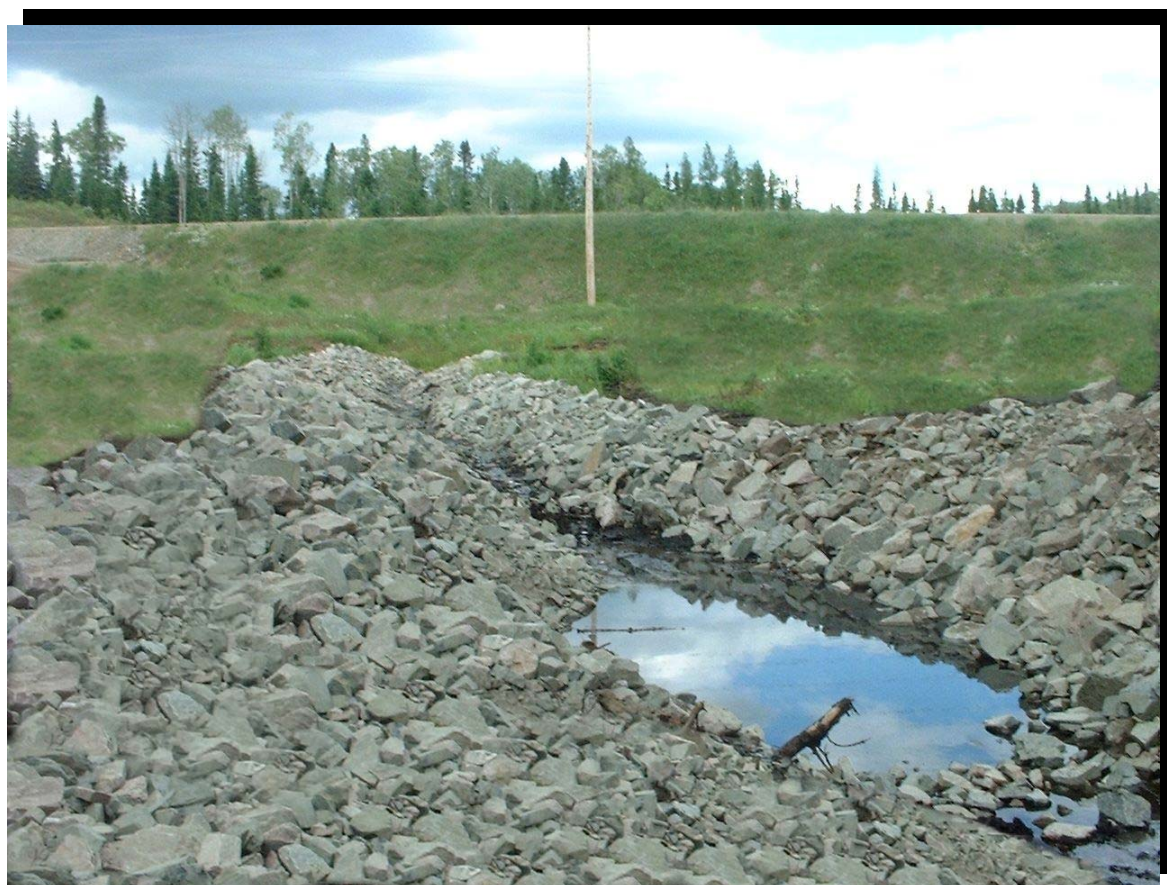
FIGURE 158 Le réaménagement des mares salines implique parfois la construction d'un bassin de sédimentation ou d'infiltration permanent lorsque les travaux sont localisés à proximité du milieu hydrique. Route 169 dans la réserve faunique des Laurentides, au kilomètre 47, près de la rivière Morin. (2001.1173)
