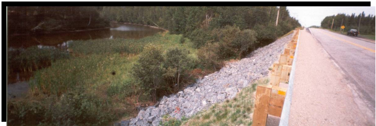
FIGURE 57 Remblai pour l'élargissement de l'accotement et la pose de glissières de sécurité. Protection de la végétation existante au pied du talus en bande riveraine Route 169 à Pérignonka, en bordure de la rivière Moreau. (1998.1064)
