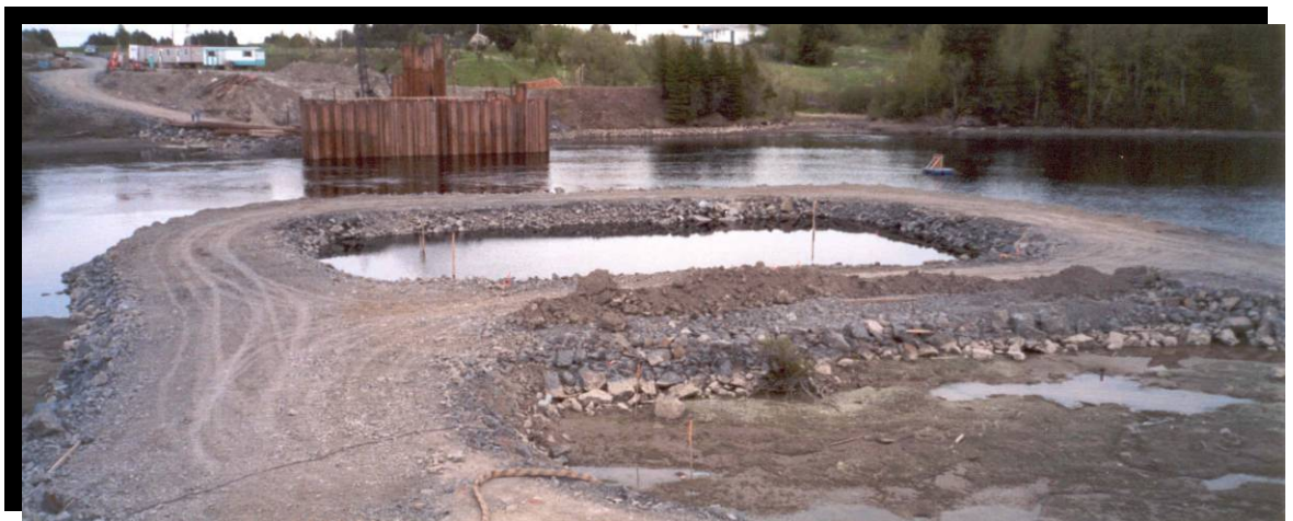
FIGURE 82 Batardeaux aménagés dans la rivière aux Sables pour la construction de piliers. Au premier plan : batardeaux constitués de sols dont les pentes sont stabilisées par de l'empierrement. En arrière-plan : batardeau constitué de palplanches d'acier. Autoroute 70 à Jonquière, pont de la rivière aux Sables. (2000.1139)
