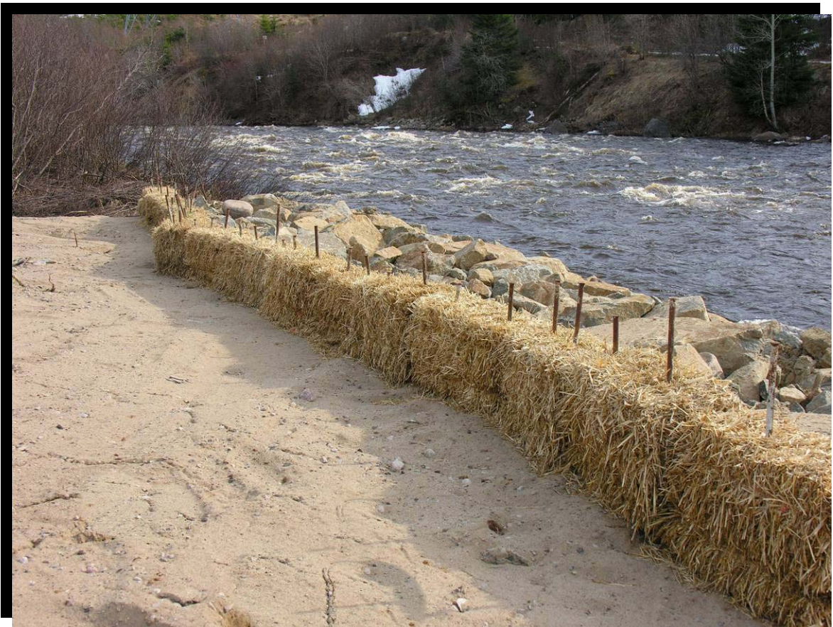
FIGURE 131 Filtre en ballots de paille le long d'un cours d'eau en attente de l'engazonnement. Route 169 dans la réserve faunique des Laurentides, au kilomètre 13, pont de la rivière Pikauba. (2005.1094)
