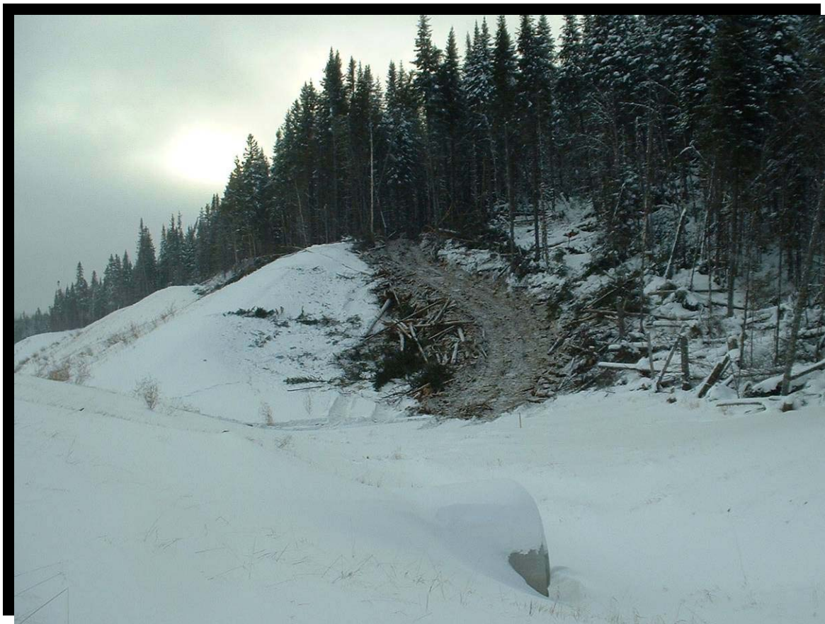
Figure 33 Chemin d'accès pour l'étude des sols. Route 175, réserve faunique des Laurentides, secteur du lac des Uries, au kilomètre 189. (2005.1186)
