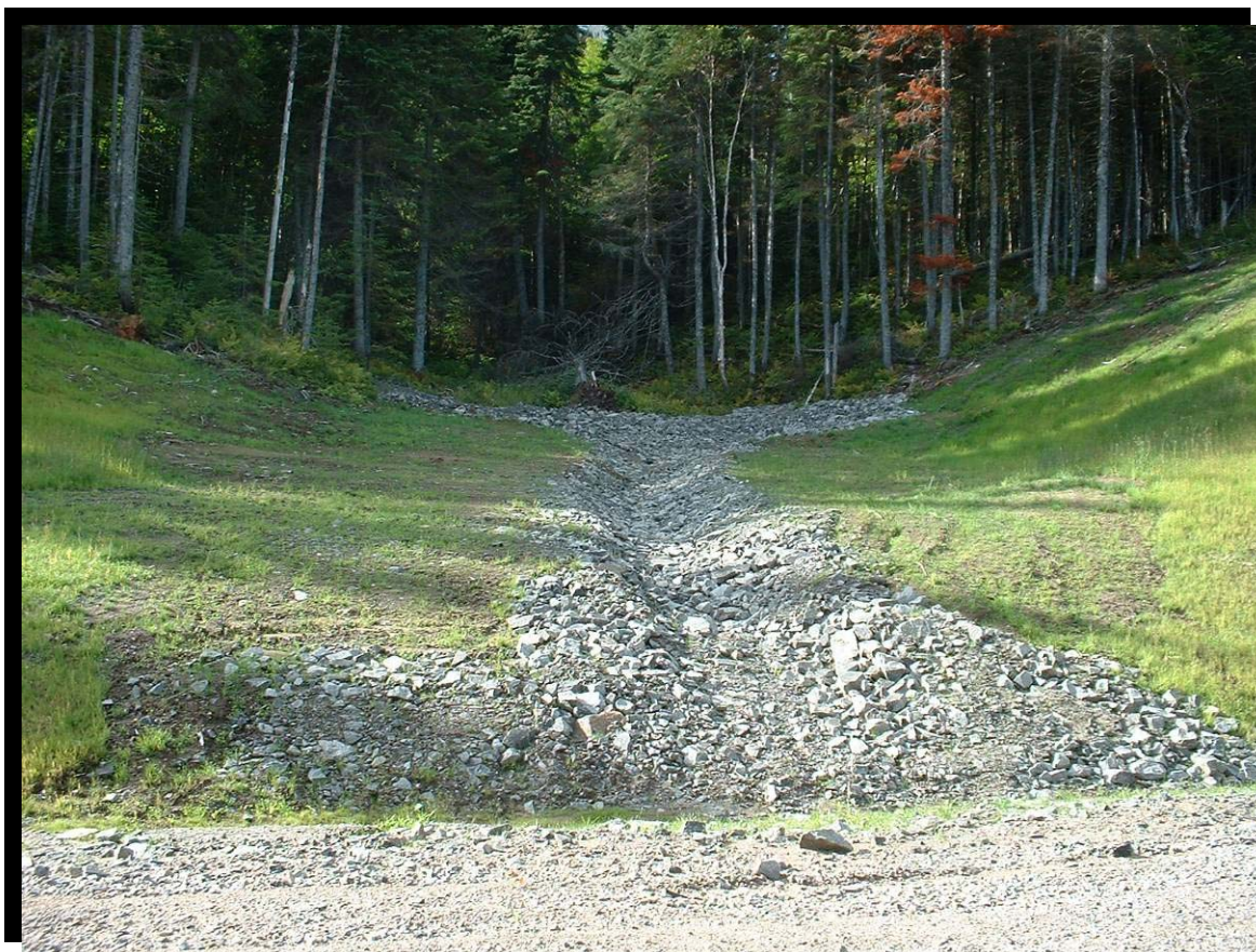
FIGURE 54 Vallonnement de terrain en haut de talus. (0000.1063) Après travaux correctifs. Empierrement d'un canal d'évacuation dans un talus de déblai à risque.
