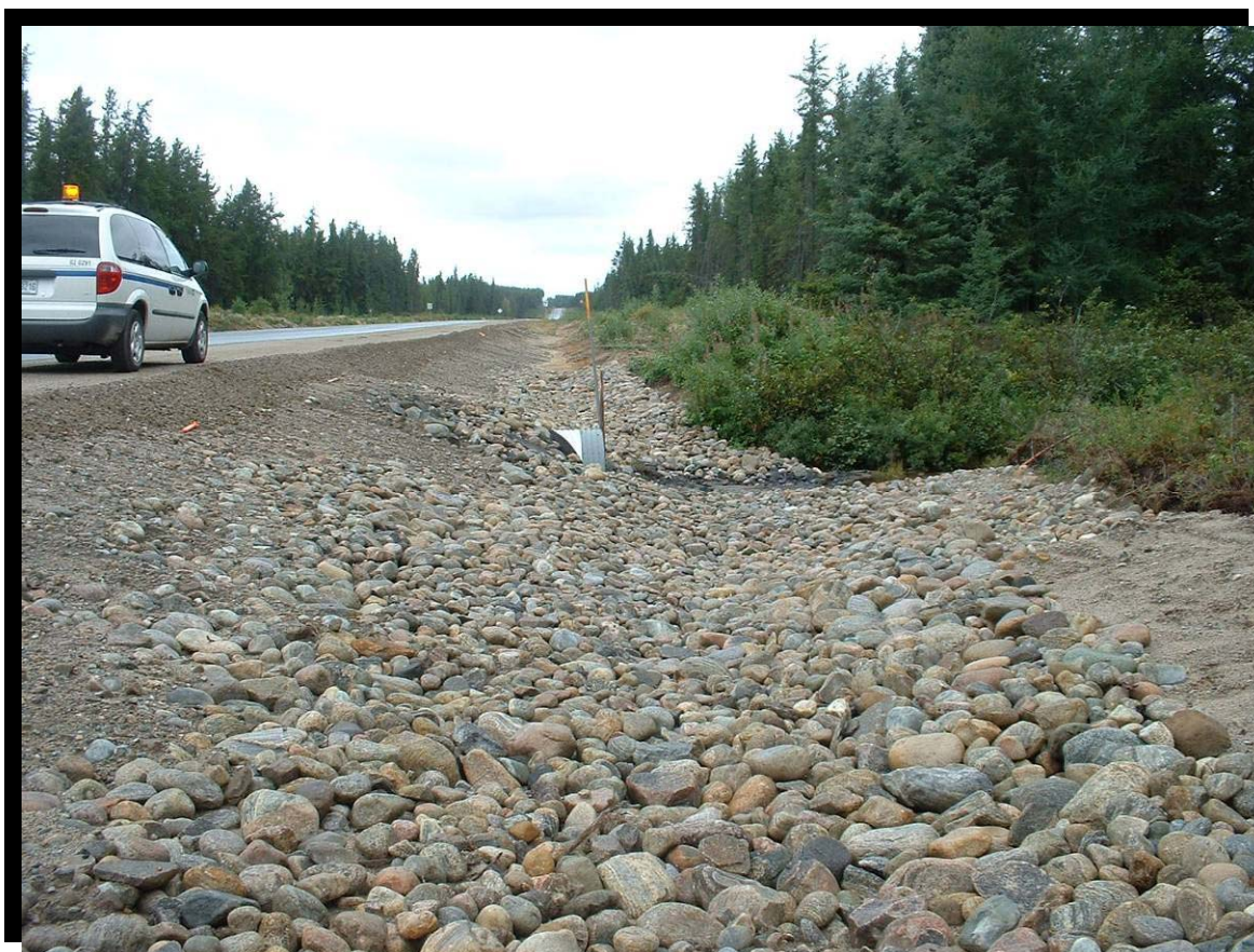
FIGURE 112 Empierrement des fossés sur une longueur de 30 mètres à partir de la LNHE du cours d'eau. Route 167 dans la réserve faunique Ashuapmushuan, du kilomètre 122 au kilomètre 129, secteur des cantons Lorne et Denaut. (2002.1144)
