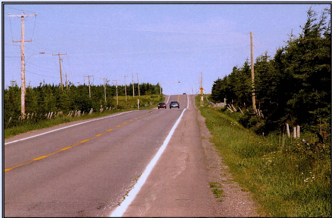
Photo 4 Projet 20-3371-9168, route 132, Sainte-Flavie, secteur 4 et 3, vue générale à partir du km 1+400, vers le nord-ouest (PATR05N4-63)
