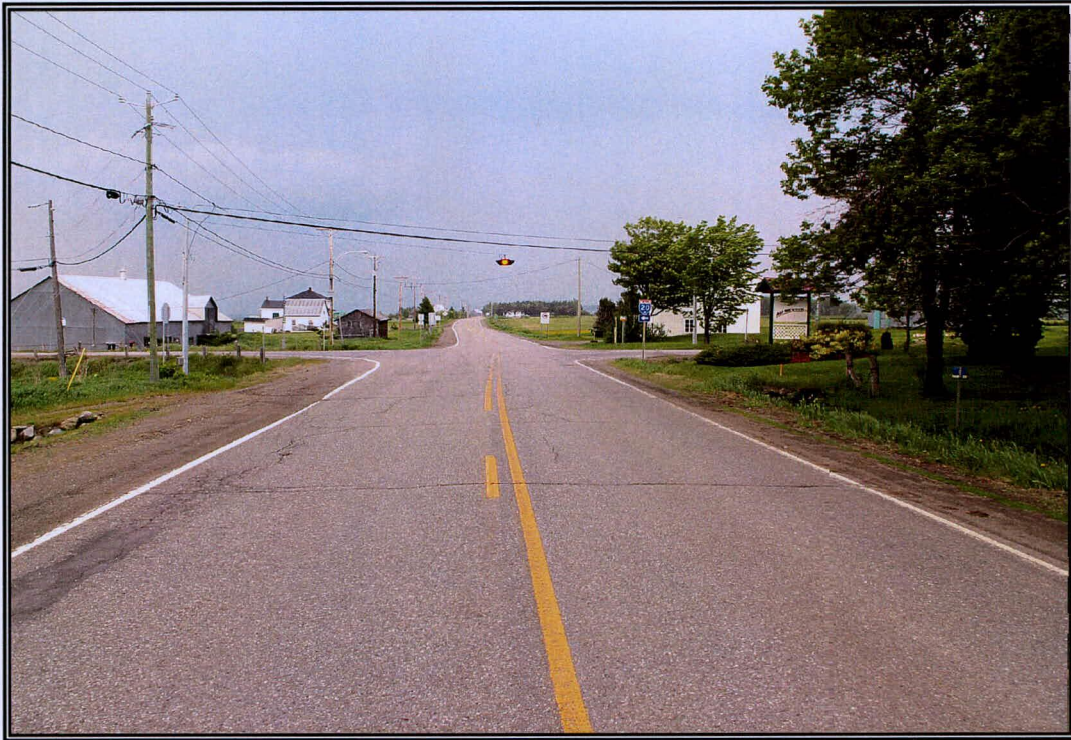
Photo 7 Projet 20-3374-8602-A, routes 230 et de la Station, Saint-André (Kamouraska), secteurs 1, 2, 3 et 4, vue d'ensemble à partir du km 0+000 vers le nord-es (PATR05N4-18)
