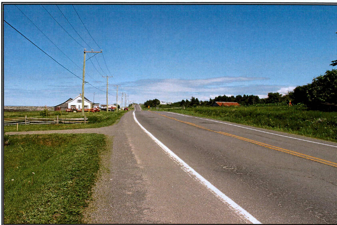
Photo 1 Projet 20-3371-9168, route 132, Sainte-Flavie, secteur 1, vue générale à partir du km 0+000, vers l'est (PATR05N4-42)
