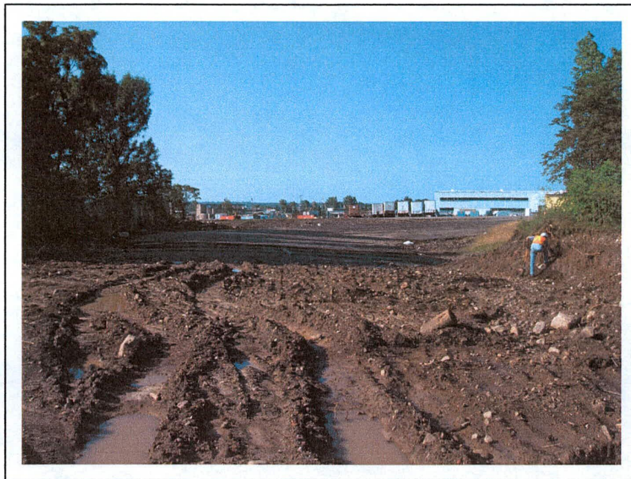
Photo 1 : (N.1-003) autoroute 15, Saint-Bernard-de-Lacolle, km 0+010, vu vers le sud, inspection visuelle
