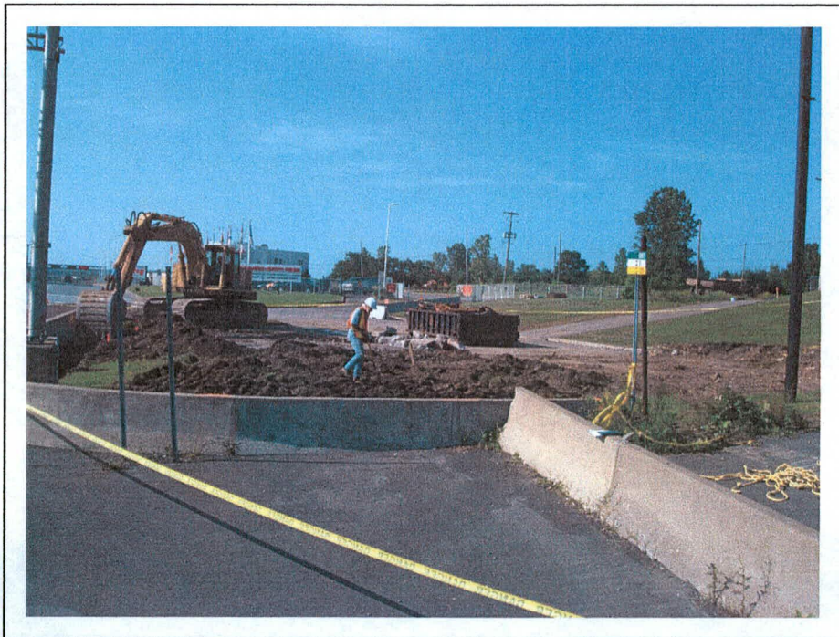
Photo 6 : (N.1-011) autoroute 15, Saint-Bernard-de-Lacolle, km 0+300, vu vers le sud, limite nord du projet
