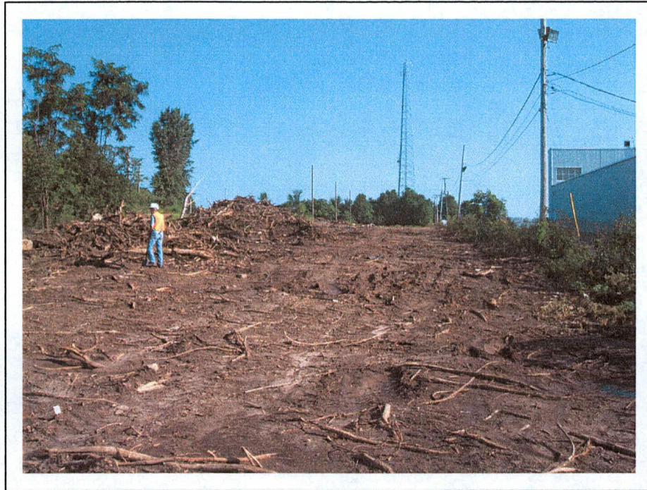
Photo 3 : (N.1-005) autoroute 15, Saint-Bernard-de-Lacolle, km 0+060, vu vers le nord, inspection visuelle
