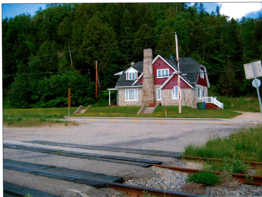
Photo 6 : Les Éboulements, projet 20-3971-0512, vue générale de la façade du no civique 128. Direction ouest.
