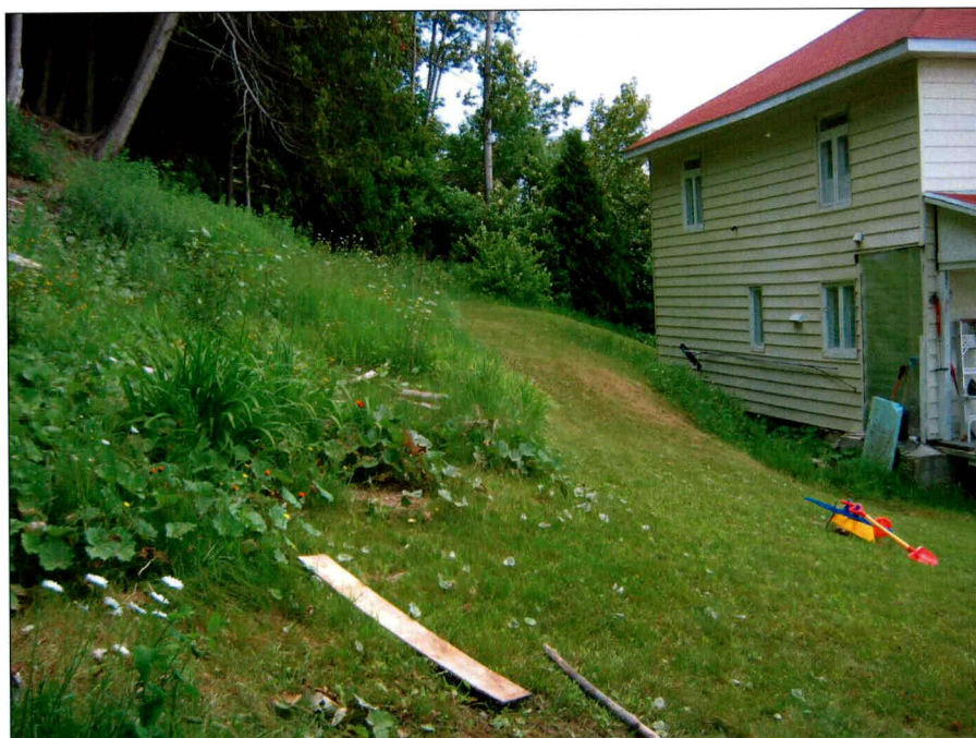
Photo 8 : Les Éboulements, projet 20-3971-0512, vue générale de l'arrière du no civique 100. Direction nord-nord-est.
