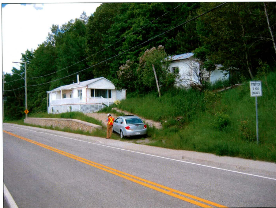
Photo 5 : Les Éboulements, projet 20-3971-0512, vue de la façade du no civique 144. Direction ouest.
