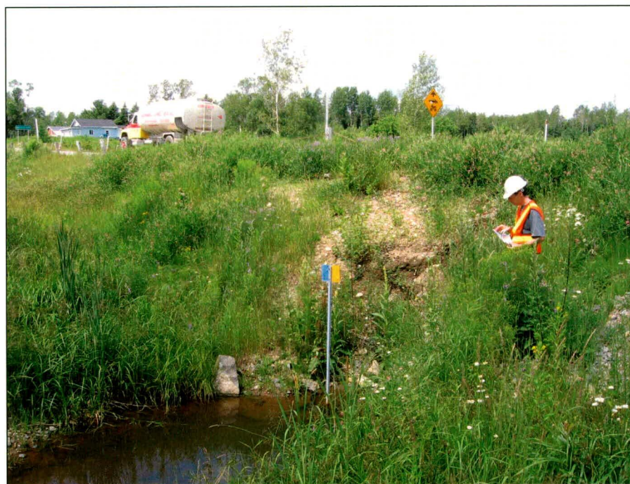
Photo 7 : Saint-Élie-de-Caxton, projet 20-3872-0440, ponceau 0935-0, vue du côté ouest de la route 351. Direction nord.
