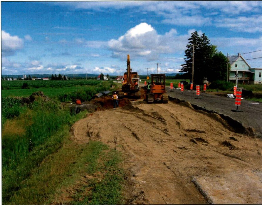
Photo 1 : Sainte-Anne-de-la-Pérade, projet 20-3873-0549, ponceau au km 2+304, côté ouest de la route 159, depuis le km 2+270. Direction nord.
