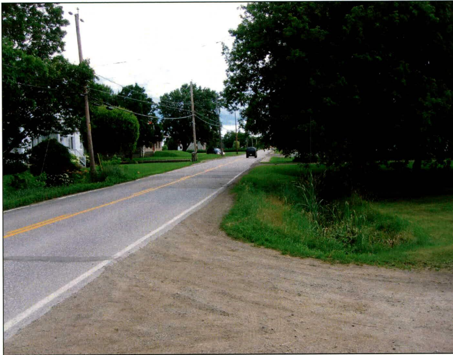
Photo 3 : Saint-Prosper, projet 20-3873-0549, vue d'ensemble. Direction nord-est.
