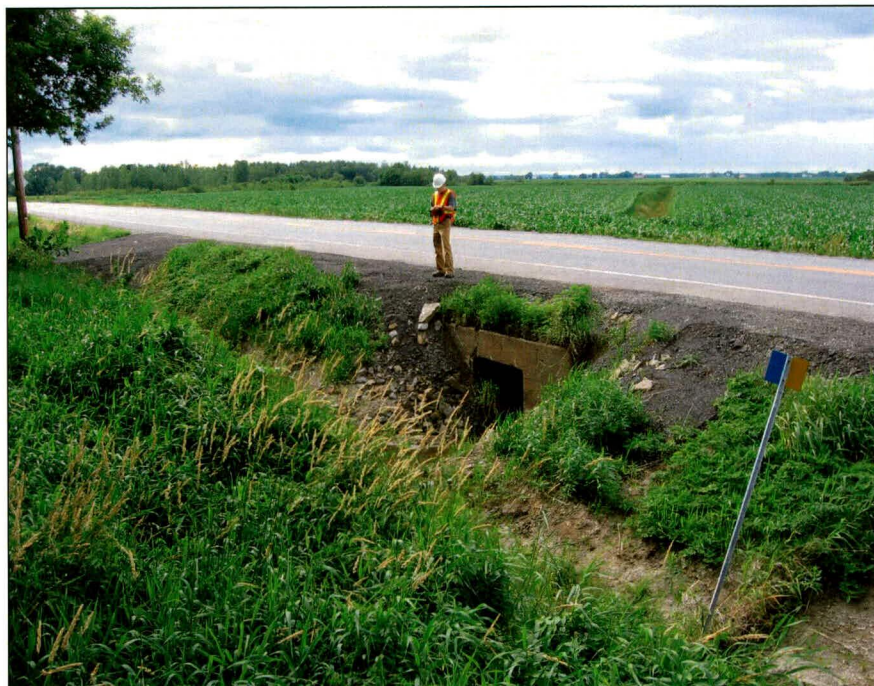
Photo 12 : Yamachiche, projet 20-3873-0535, ponceau ouest au km 4+180, côté sud de la route 138. Direction nord-ouest.
