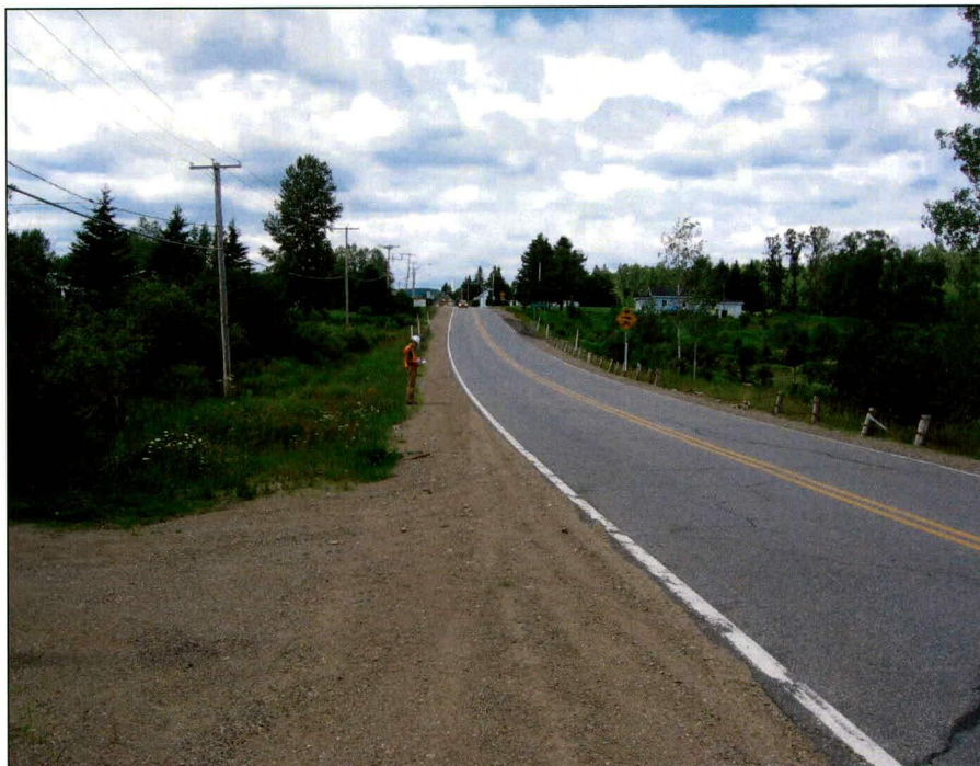
Photo 6 : Saint-Élie-de-Caxton, projet 20-3872-0440, ponceau 0935-0, vue générale. Direction nord-ouest.
