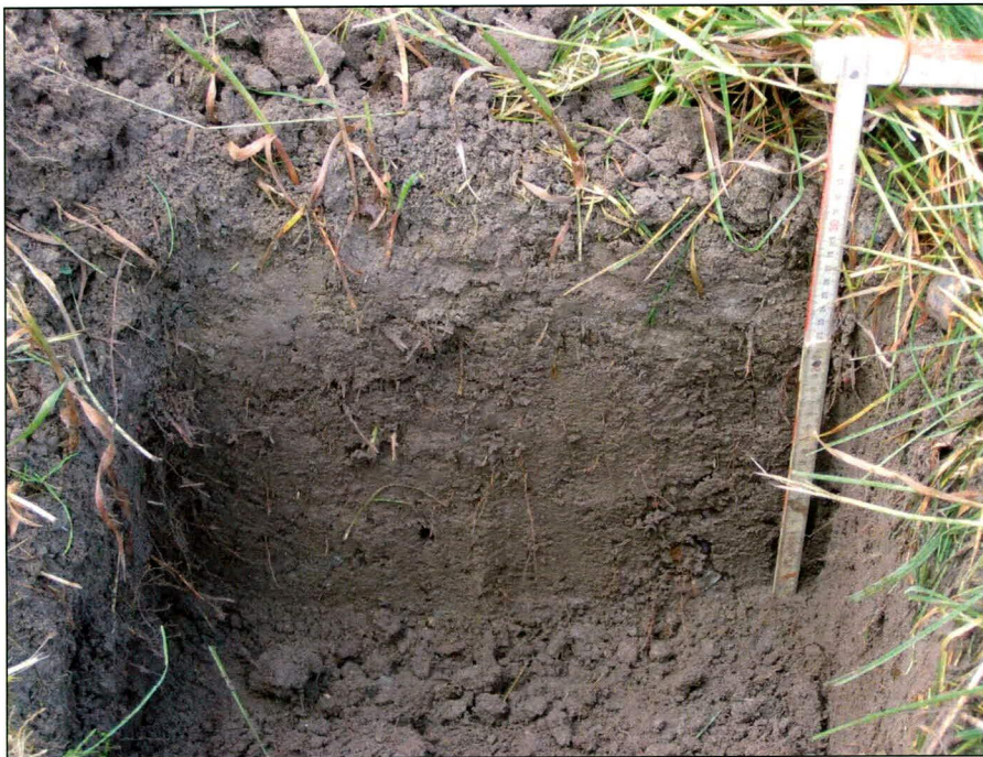
Photo 2 : Sainte-Anne-de-la-Pérade, projet 20-3873-0549, ponceau au km 2+304, paroi de sondage type. Direction sud-ouest.
