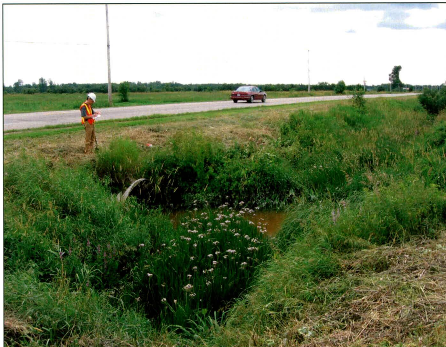
Photo 10 : Yamachiche, projet 20-3873-0535, ponceau au km 1+305, côté nord de la route 138. Direction sud-ouest.
