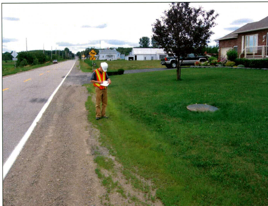
Photo 9 : Charrette, projet 20-3872-0440, ponceau 0924-0, vue du côté est de la route 351, terrain aménagé, drainage fermé. Direction nord-ouest.
