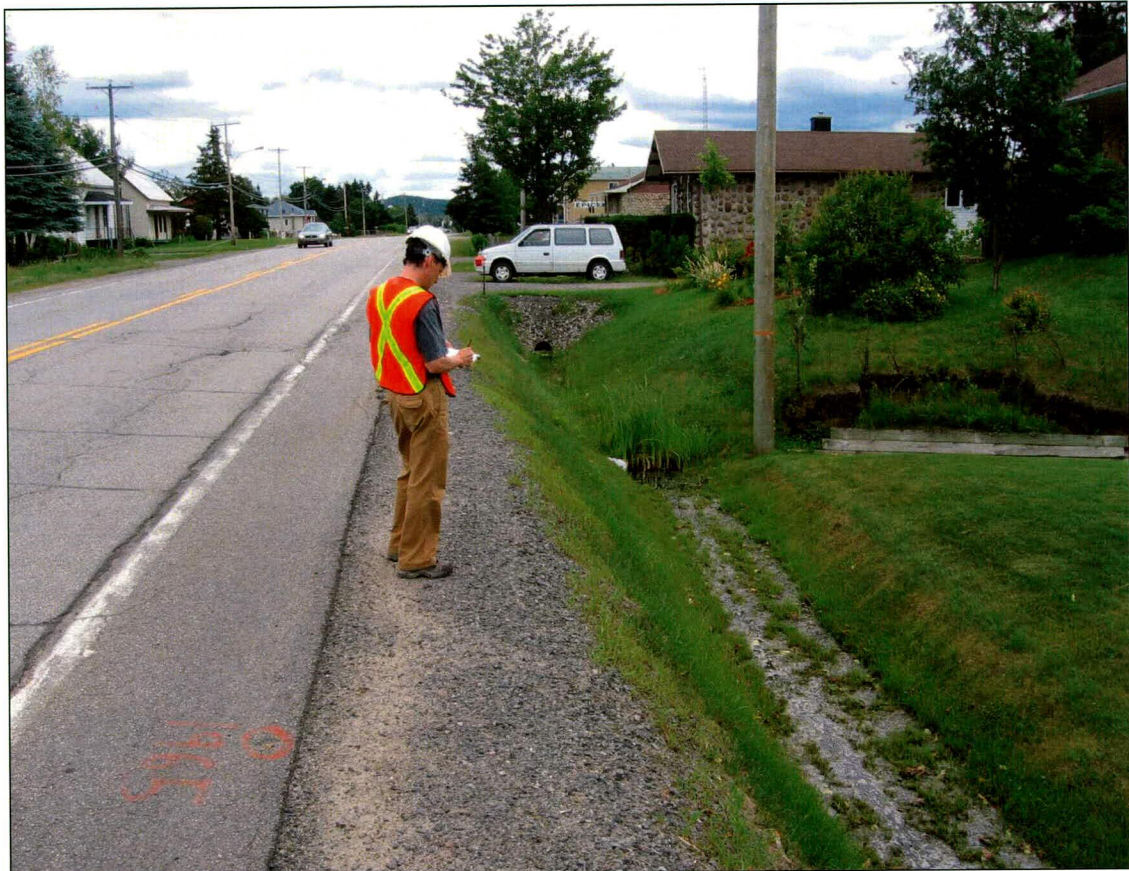
Photo 5 : Shawinigan, projet 20-3872-0440, vue générale du côté sud de la route 351. Vers le sud-est.
