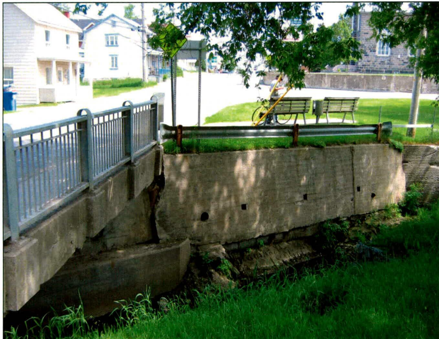
Photo 14 : Saint-Bernard, projet 20-3471-0227, côté sud du rang Saint-Georges, vis-à-vis l'assise du coin sud-est du ponceau. Direction nord-est.
