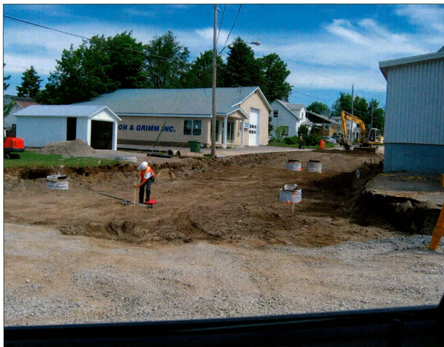
Photo 8 : Sainte-Claire, projet 20-3474-0055, côté est de la route 277, depuis le n° civique 125, à la jonction des rues Prévost et Bégin, excavations en cours. Direction nord.
