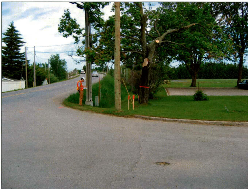
Photo 4 : Saint-Anselme, projet 20-3971-0511, côté nord de la route 277, depuis le km 2+840, fossé. Direction nord-ouest.
