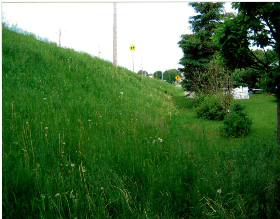
Photo 5 : Saint-Anselme, projet 20-3971-0511 côté nord de la route 277, depuis le km 2+570, remblai de la route à gauche. Direction nord-ouest.
