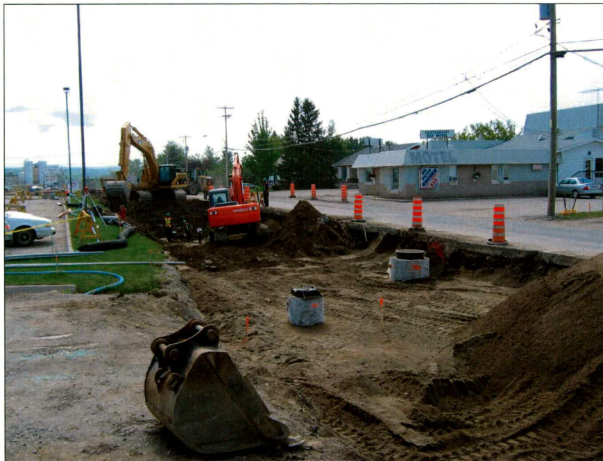
Photo 7 : Sainte-Claire, projet 20-3474-0055, côté est de la route 277, depuis le km 6+680, excavations en cours. Direction sud.
