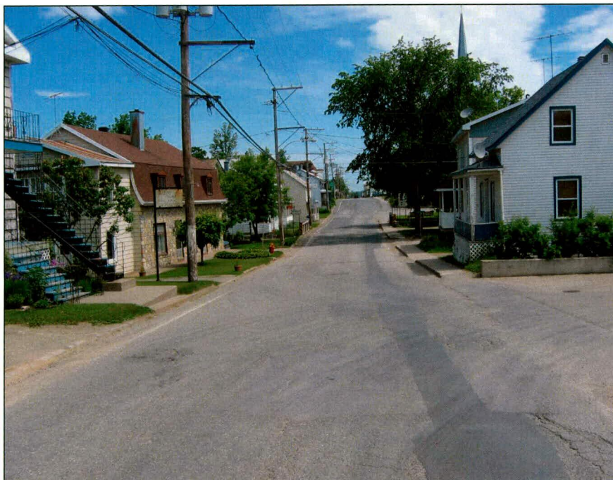
Photo 13 : Saint-Bernard, projet 20-3471-0227, côté sud du rang Saint-Georges, depuis le km 0+050 et le no civique 1435. Direction est.
