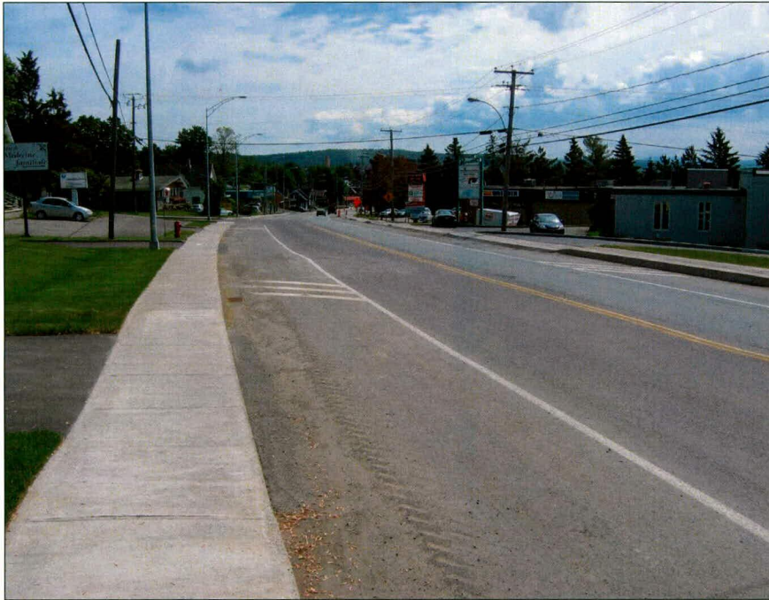
Photo 6 : Sainte-Claire, projet 20-3474-0055, côté est de la route 277, depuis le n° civique 855, travaux complétés. Direction sud-ouest.
