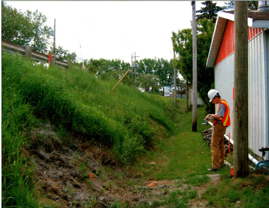
Photo 3 : Saint-Anselme, projet 20-3971-0511, côté sud de la route 277, depuis le km 2+790, fossé et assise de la route. Direction sud-est.
