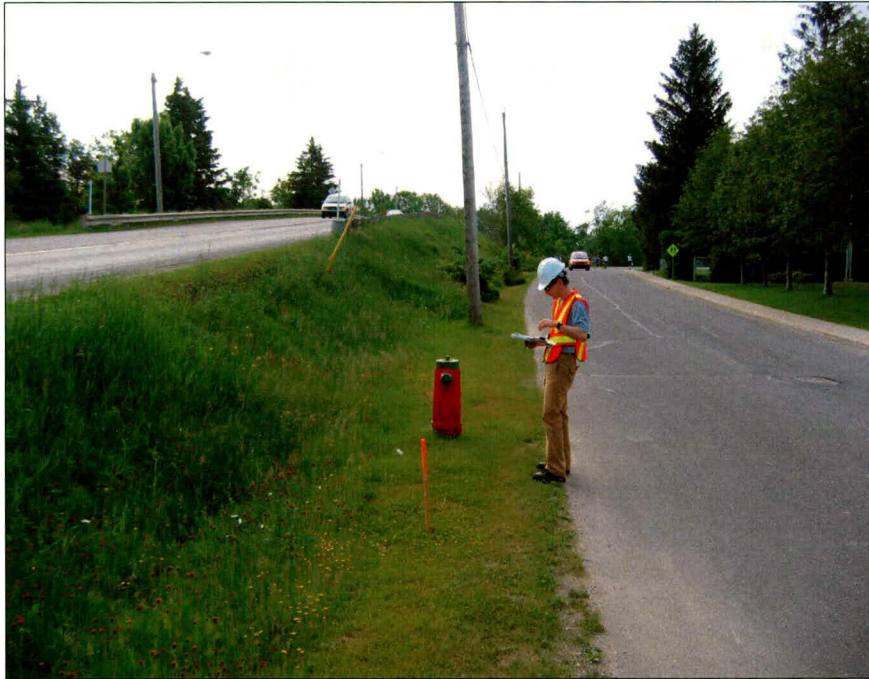
Photo 1 : Saint-Anselme, projet 20-3971-0511, côté sud de la route 277, depuis le km 2+540. Direction sud-est.
