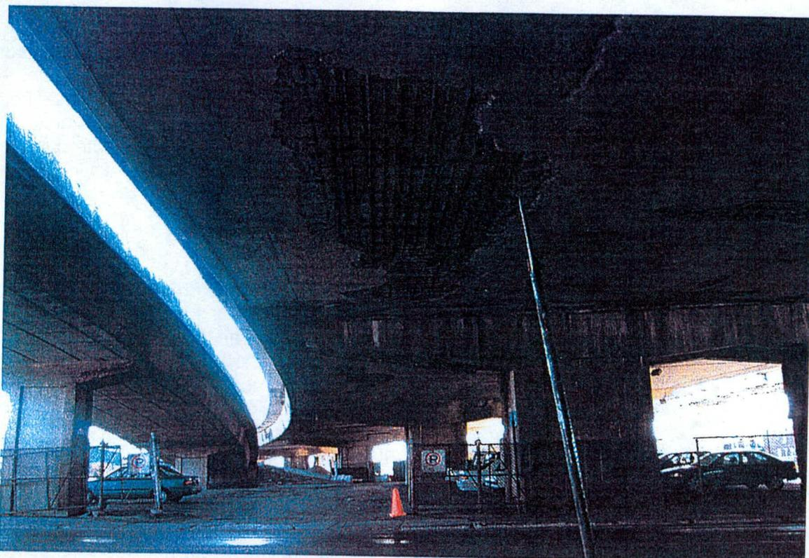
Figure 6 : Viaduc de La Vérendrye – exemple des dommages
