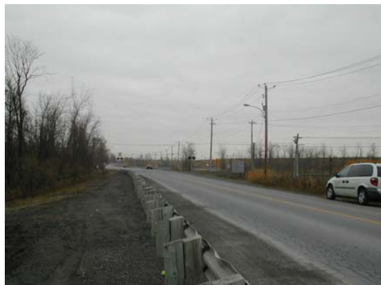
Vue sud du chemin Saint-Ignace vers l'emprise projetée
