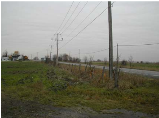
Vue sud du rang Saint-Pierre vers l'emprise projetée
