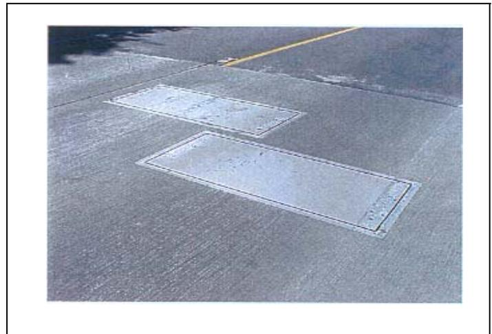
Le WIM est jumelé à une boucle de détection, ce qui permet de peser chacun des essieux, de calculer la distance entre chaque essieu (ce qui correspond à une classe de véhicule) et de mesurer la vitesse du véhicule. Le maximum de charge entre les essieux est différent selon la classification du véhicule. Les données fournies par un WIM sont les suivantes : volume de véhicules, vitesse, classification, poids, configuration, etc..
