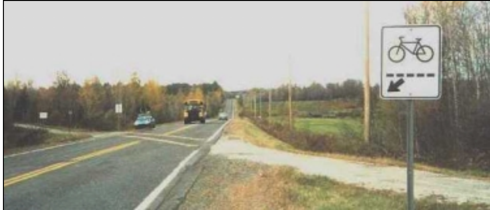
Photo 6-1 – Traversée de route à grande vitesse
