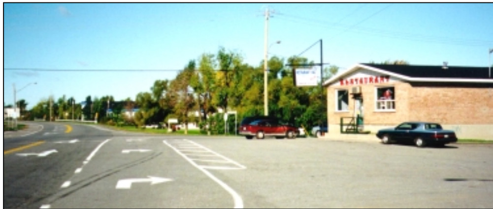
Photo 2-1 — Accès non défini et utilisation d'une partie de l'emprise routière pour du stationnement
