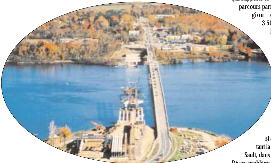
Pont interprovincial, construction du pont du Long Sault.
