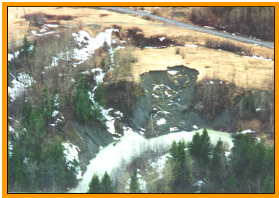
Figure 22 : Exemple de glissement rotationnel multiple en bordure de la rivière aux Vases, Shipshaw.
