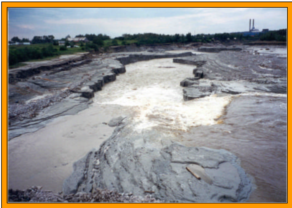
B : Vue vers l'aval à partir du pont de l'autoroute 70. Le nouveau lit situé au centre de l'ancien a environ 7 m de profondeur de plus.
