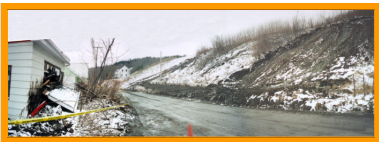
Figure 16 : Exemple d'un glissement superficiel dont les débris ont percuté une maison après avoir traversé la route; Saint-Fulgence, avril 1995.
