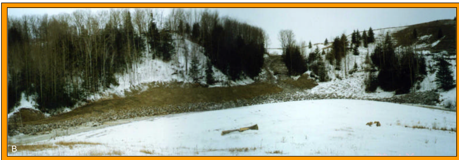
Le pied du talus est protégé de l'érosion par un enrochement en pierre. Le contrepoids est constitué de sable et il a été recouvert de terre végétale et ensemencé. (photo prise en janvier 1999, à la fin des travaux)
