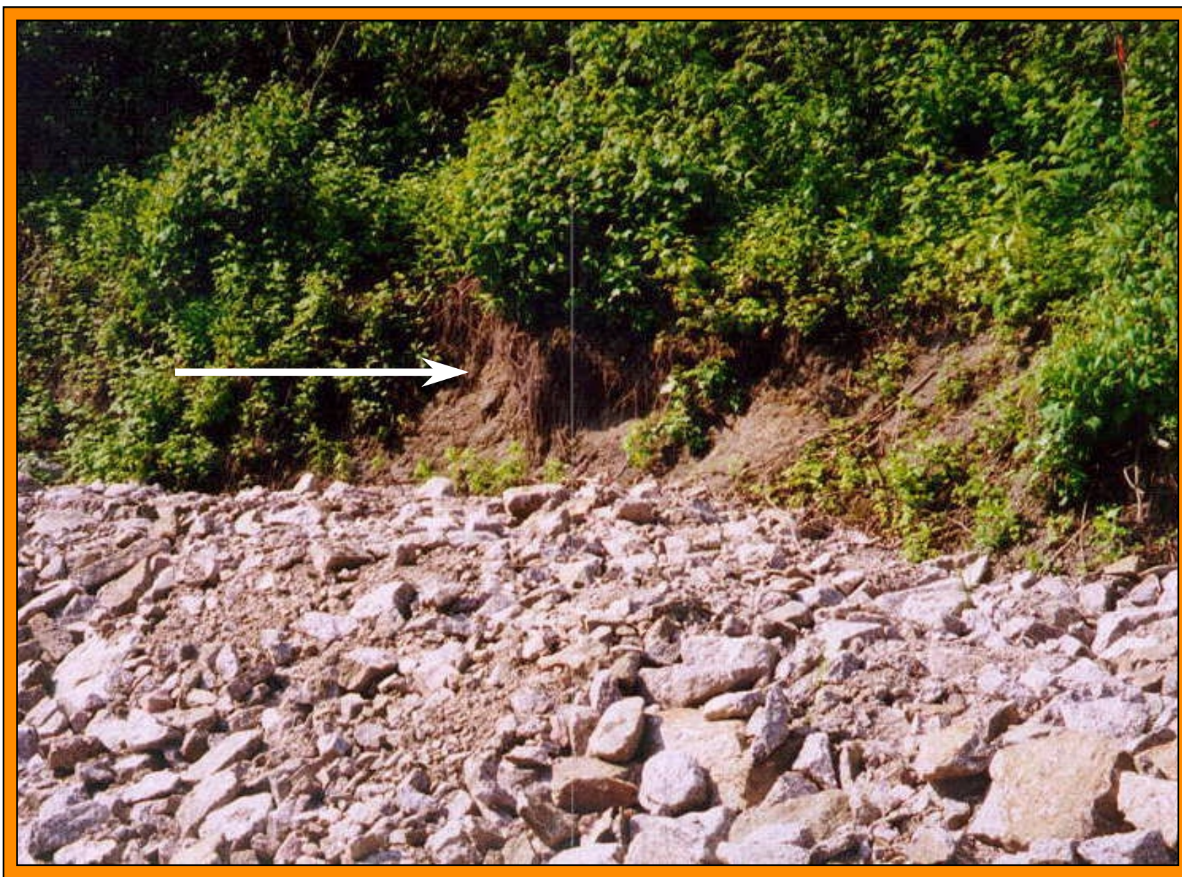
Figure 61 : Marque d'érosion encore apparente au-dessus de l'enrochement dans le ruisseau Bluteau (zone 1, fig. 53).
