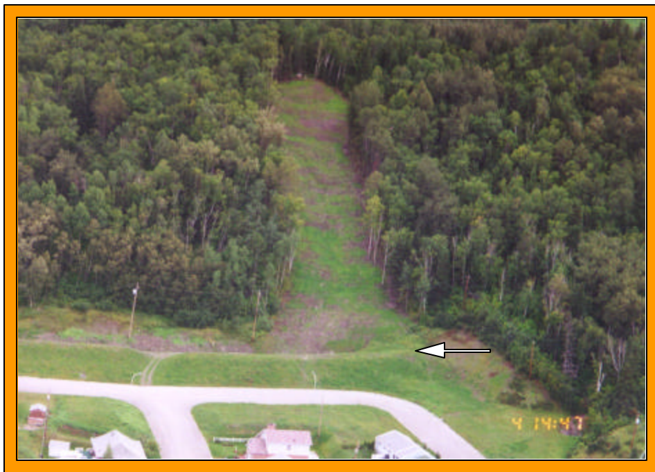
Figure 50 : Vue en hélicoptère de la digue en enrochement et de la cicatrice régalee du glissement de la rue Henry-McNicoll, La Baie.
