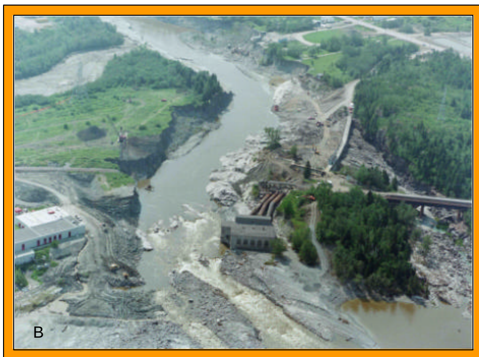
Figure 4 : Secteur du barrage Pont-Arnaud (rivière Chicoutimi) avant (A) et après (B) les événements de juillet 1996.
