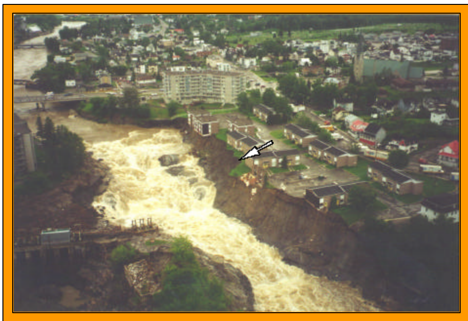
Figure 8 : Nouveau chenal de la rivière aux Sables creusé à la suite du débordement du barrage d'Abitibi-Price formant ainsi de nouvelles falaises instables, Jonquière.
