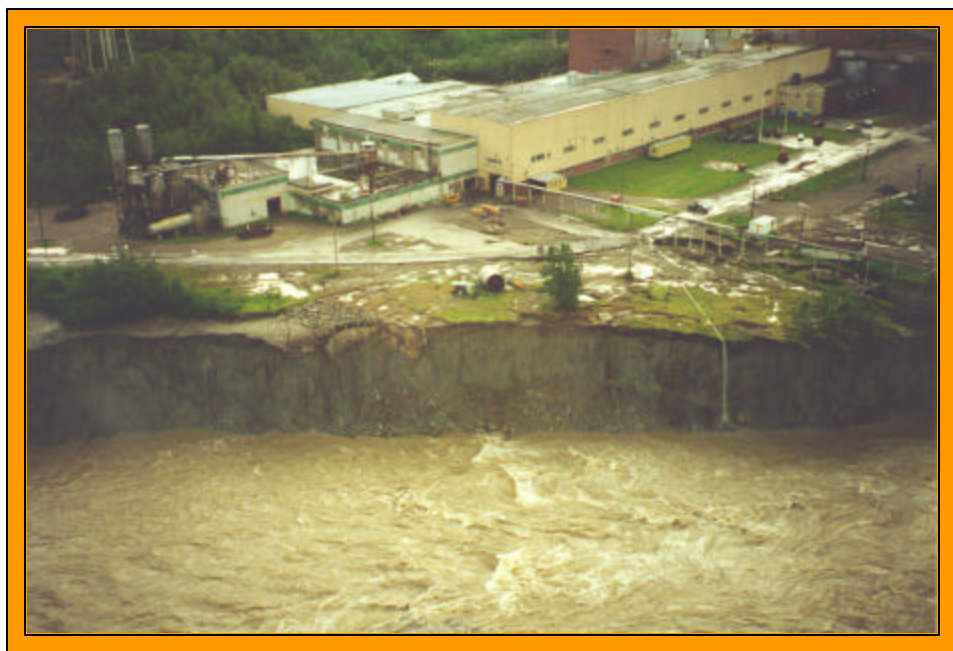
Figure 7 : Falaises instables provoquées par l'érosion; site du barrage d'Abitibi-Price, rivière aux Sables, Jonquière, secteur Kénogami.
