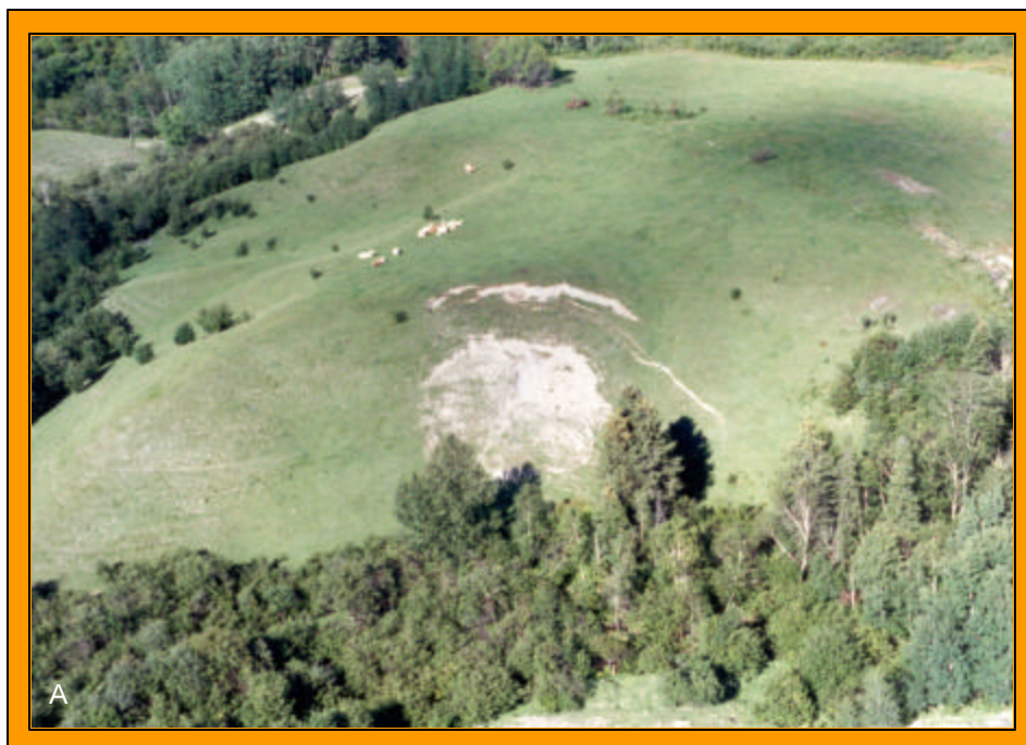
A : Talus affecté par un glissement superficiel et par de nombreuses fissures avec affaissement délimitant une zone de stabilité marginale (rang Saint-Wilbrod, Jonquière).
