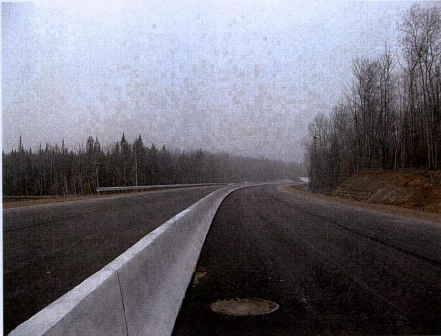
Photo 6.2.3 Option 2 – Route à quatre voies séparées avec glissière rigide (mur)
