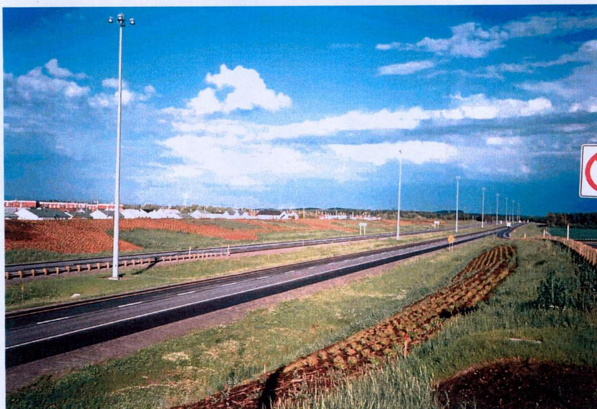
Photo 6.2.7 Option 6 – Autoroute à quatre voies avec un terre-plein de 15 mètres
