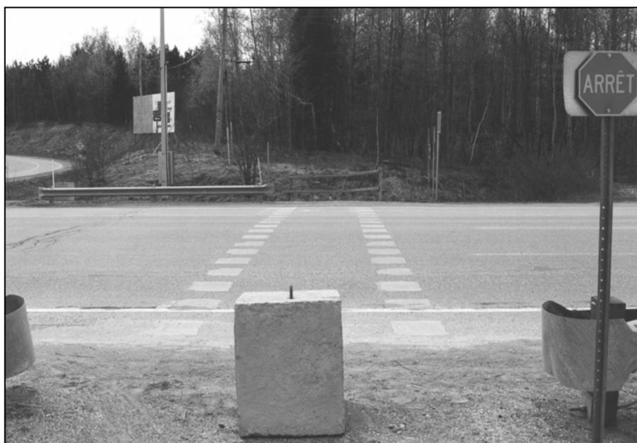
**Figure 19** Bloc de ciment utilisé comme séparateur de trafic, site Bromptonville I
