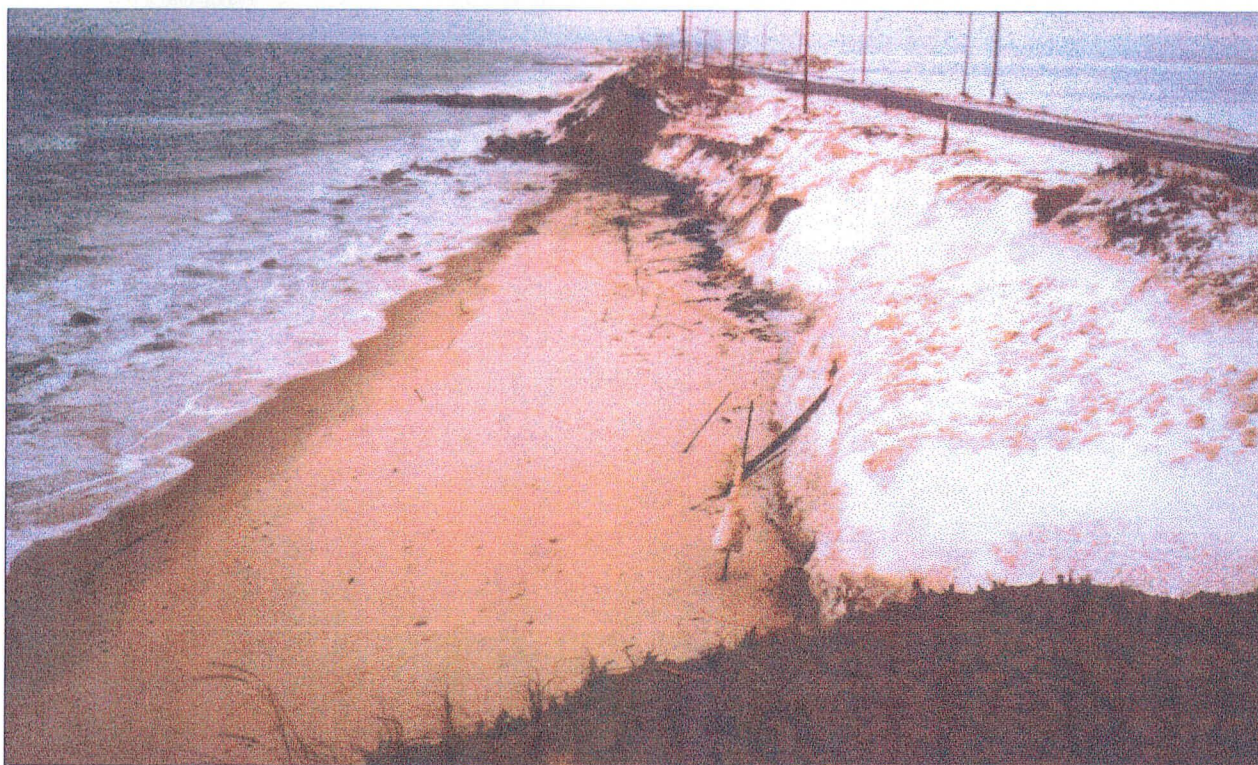
Photo 5.3. Vue du premier site d'érosion mesurant 220 mètres à partir de l'épi du mur #11395 en direction sud-ouest.
