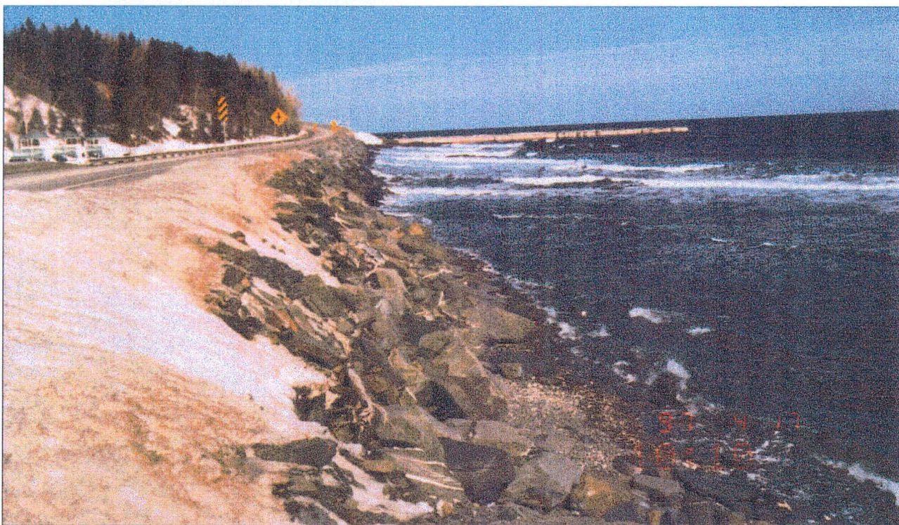
Photo 4.3. Vue vers l'ouest, secteur face à la halte routière.
