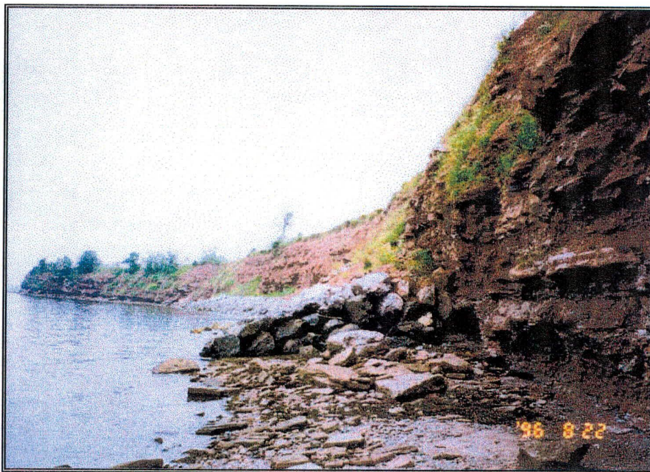
Photo 2.11 : Protection en enrochement mise en place en 1992.
