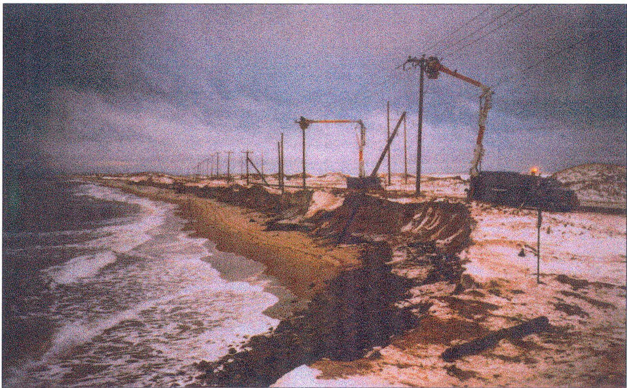
Photo 5.6. Déplacement obligatoire de 12 poteaux d'Hydro-Québec causé par l'avancement du haut de la plage vers la route.
