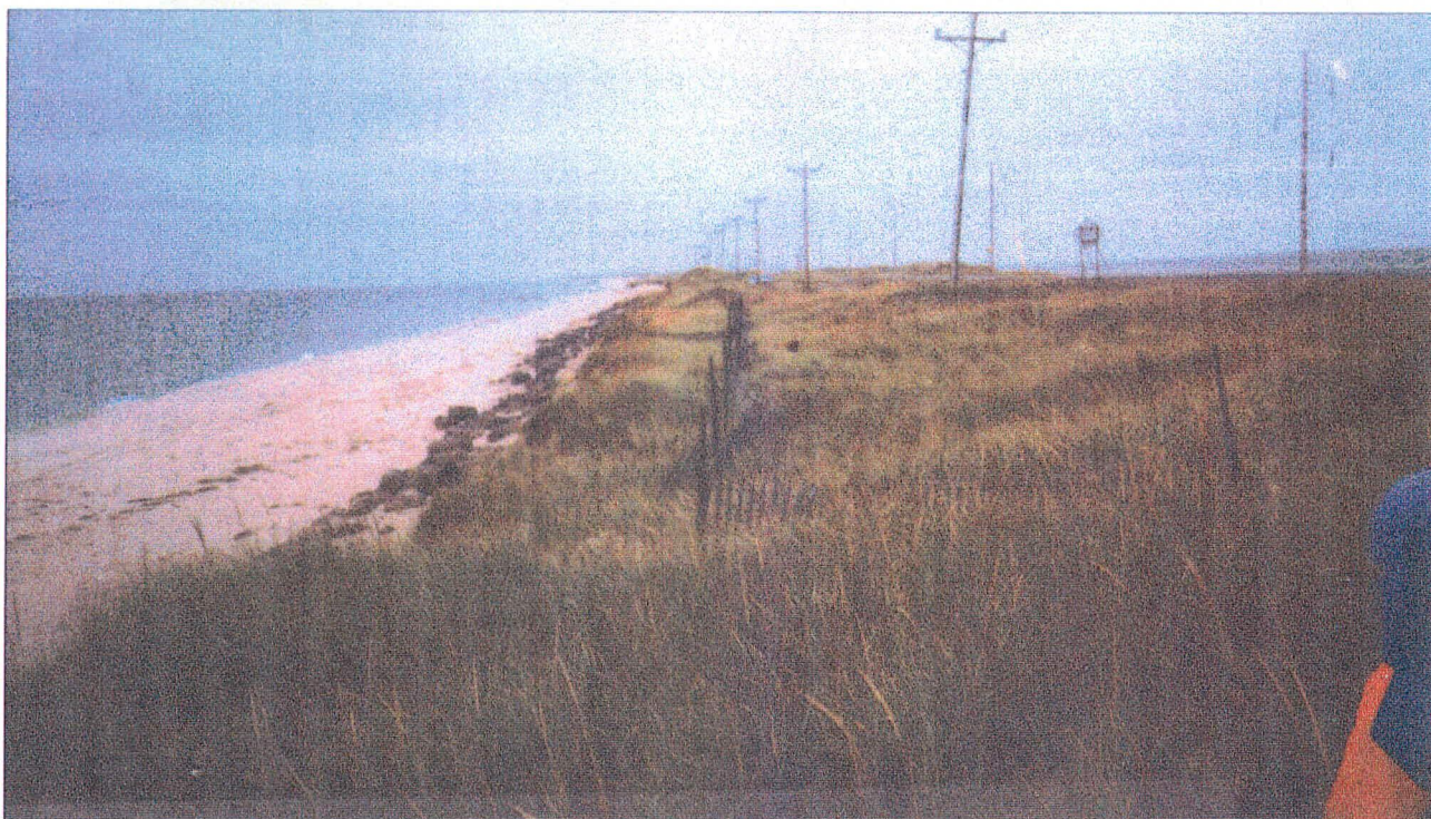
Photo 5.1. État des lieux en 1993. Espace tampon de plusieurs dizaines de mètres entre la côte et la route 199.
