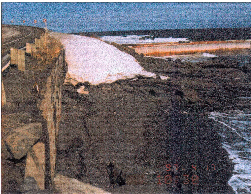
Photo 4.4. Portion du mur non protégée, immédiatement à l'ouest de la halte routière.
