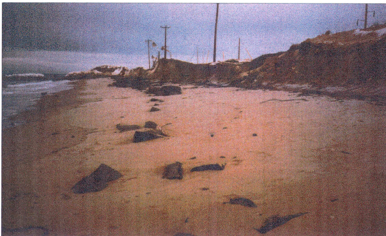
Photo 5.4. Érosion de la protection en pierre et rapprochement de la côte vers la route.
