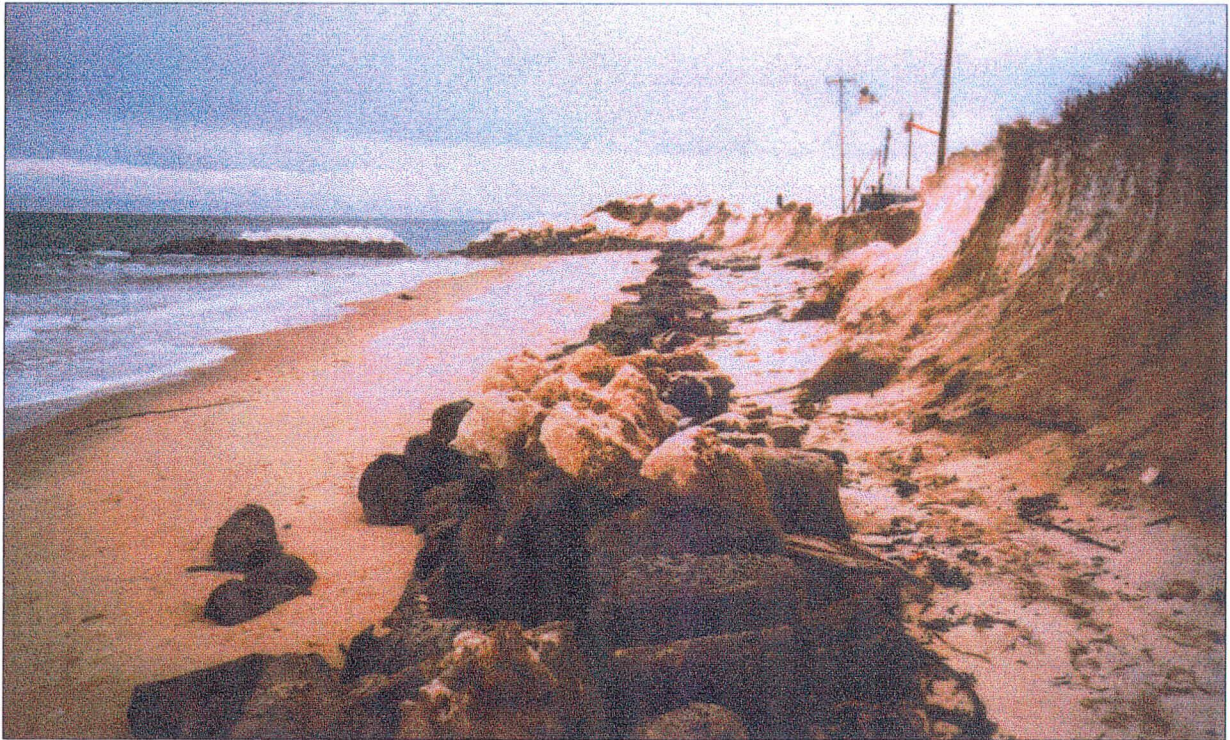
Photo 5.5. Recul de la côte et décrochement de la protection en pierre de la base du talus.
