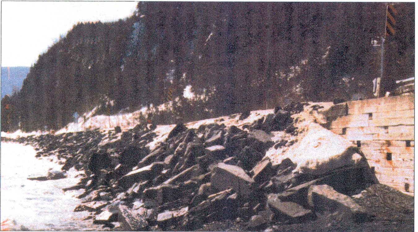
Photo 4.1. Vue des lieux vers l'est et de l'extrémité du mur existant.
