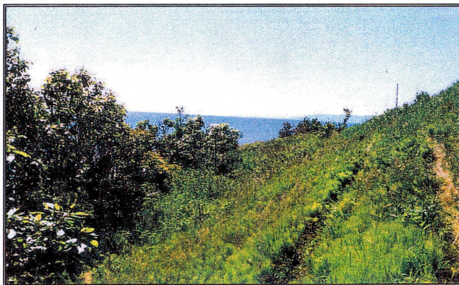
Photo 2.4 : Sommet du talus au droit de l'éroulement et remblai de la route 132.
