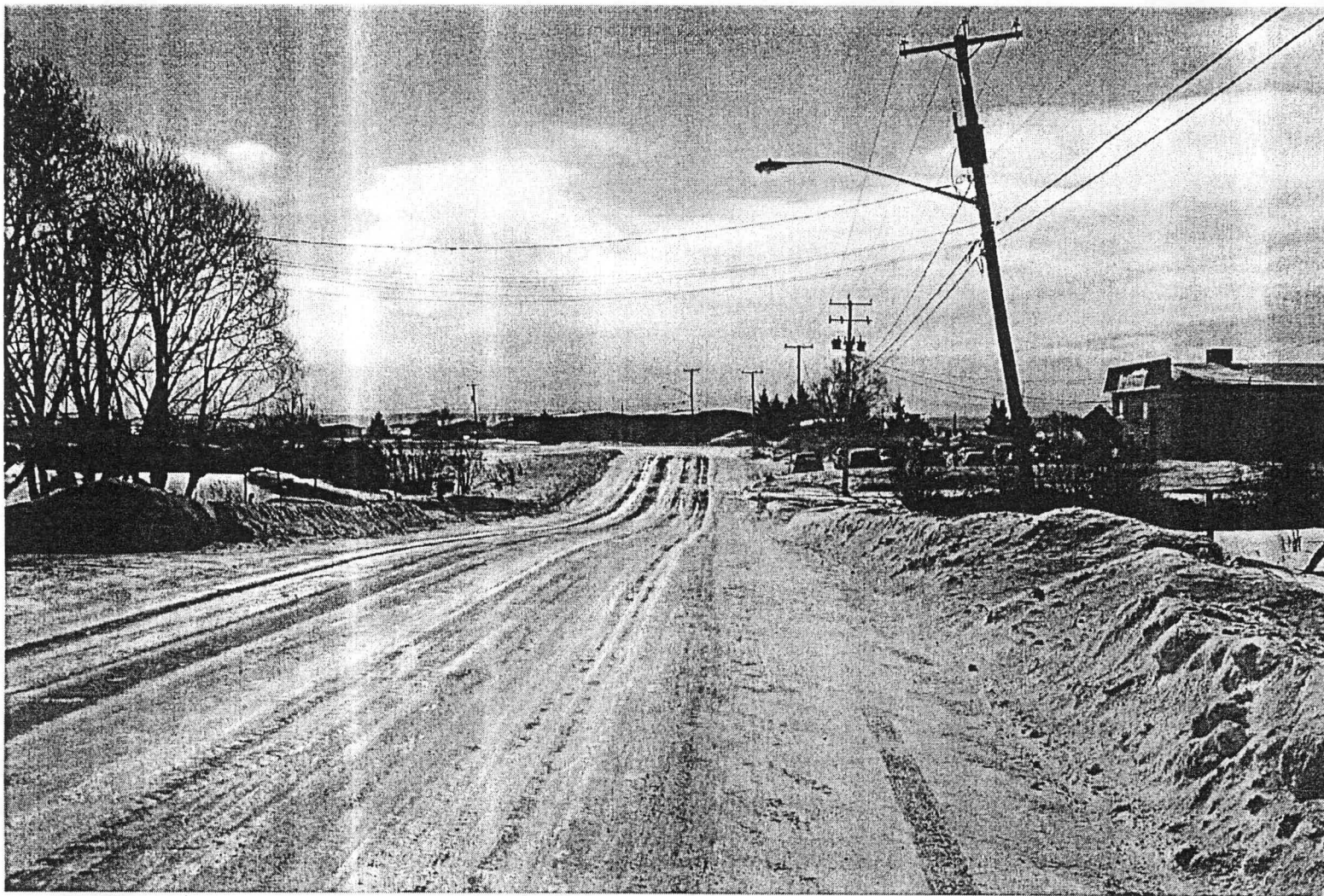
Description : Tracé nord rang St-Alphonse Nord vue vers le sud
