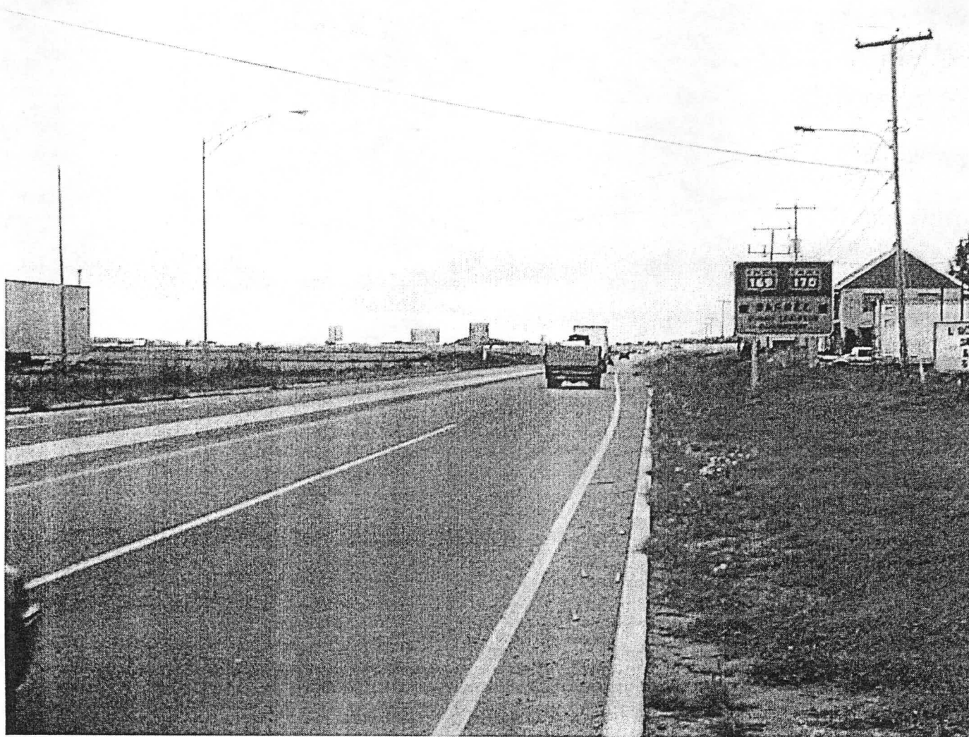
Description : Route 170 en direction ouest depuis l'intersection St-Alphonse
