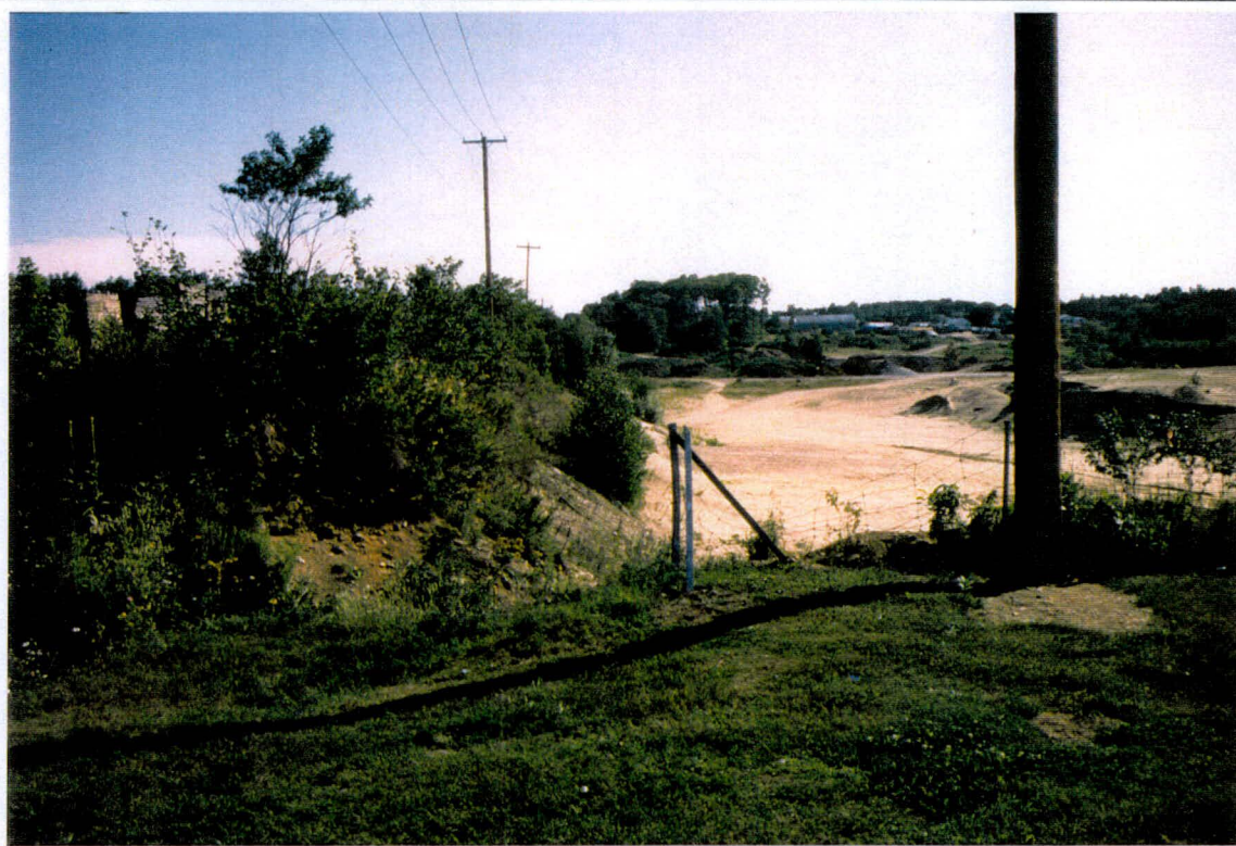
Photo 2: Projet 6571-8729, route 348 (nouveau tracé), secteur 2, vue d'ensemble à partir du km 0 + 800 vers le nord-est (NE)
