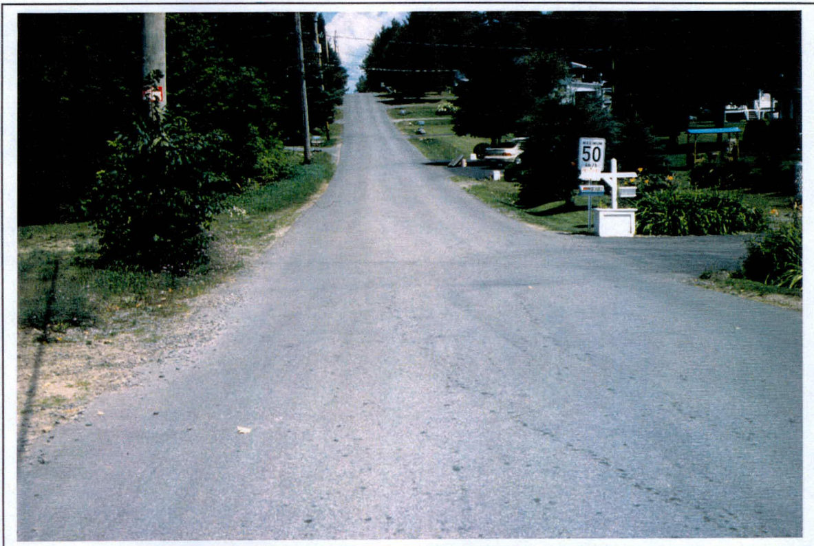
Photo 6: Projet 6571-8729, chemin des Lots, secteur 5, vue d'ensemble à partir du km 1 + 580 vers le nord-est (NE)
