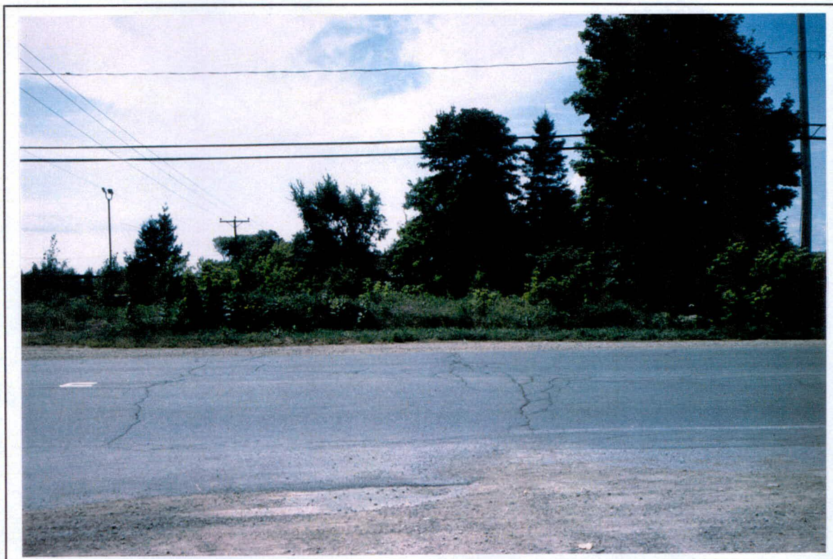
Photo 4: Projet 6571-8729, route 348 (nouveau tracé), secteur 3, vue d'ensemble à partir du km1+ 600 vers le sud-ouest (SO)
