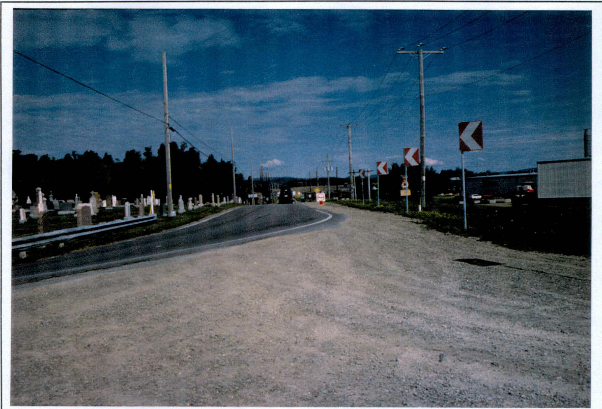
Photo 5 Projet 6571-8729, ancienne route 348, secteur 4, vue d'ensemble à partir du km 10 + 000 vers le nord (N)
