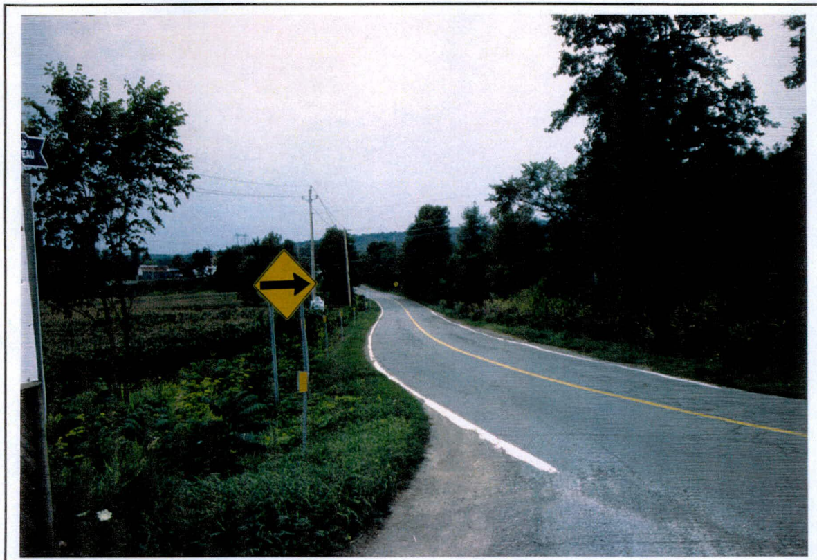
Photo 13: Projet 6574-8608, route 344, secteur 4, vue d'ensemble à partir du km 4 + 060 vers le nord-ouest (NO)
