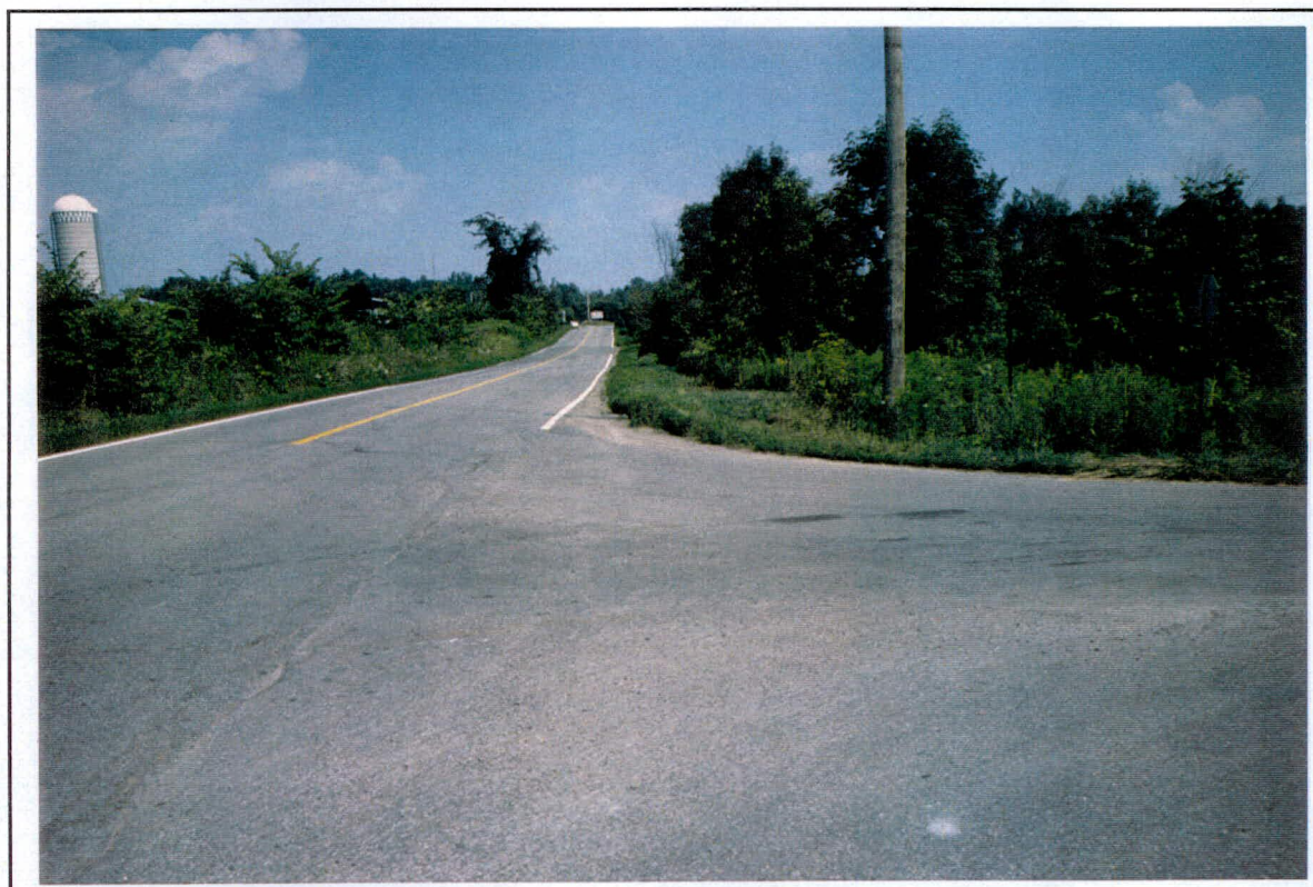
Photo 14: Projet 6574-8608, route 344, secteurs 4 et 5, intersection route 344 et chemin Latour à partir du km 4 + 540 vers le sud-est (SE)
