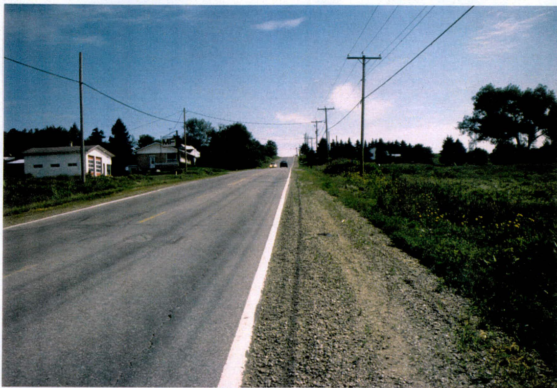
Photo 1: Projet 6571-8729, route 348, secteur 1, vue d'ensemble à partir du km 0 + 200 vers le sud-ouest (SO)
