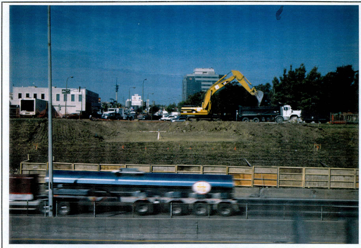
Photo 1: Projet 5200-9681, boulevard l'Acadie / autoroute 520, secteur 1, vue d'ensemble des travaux vers le nord (N)
