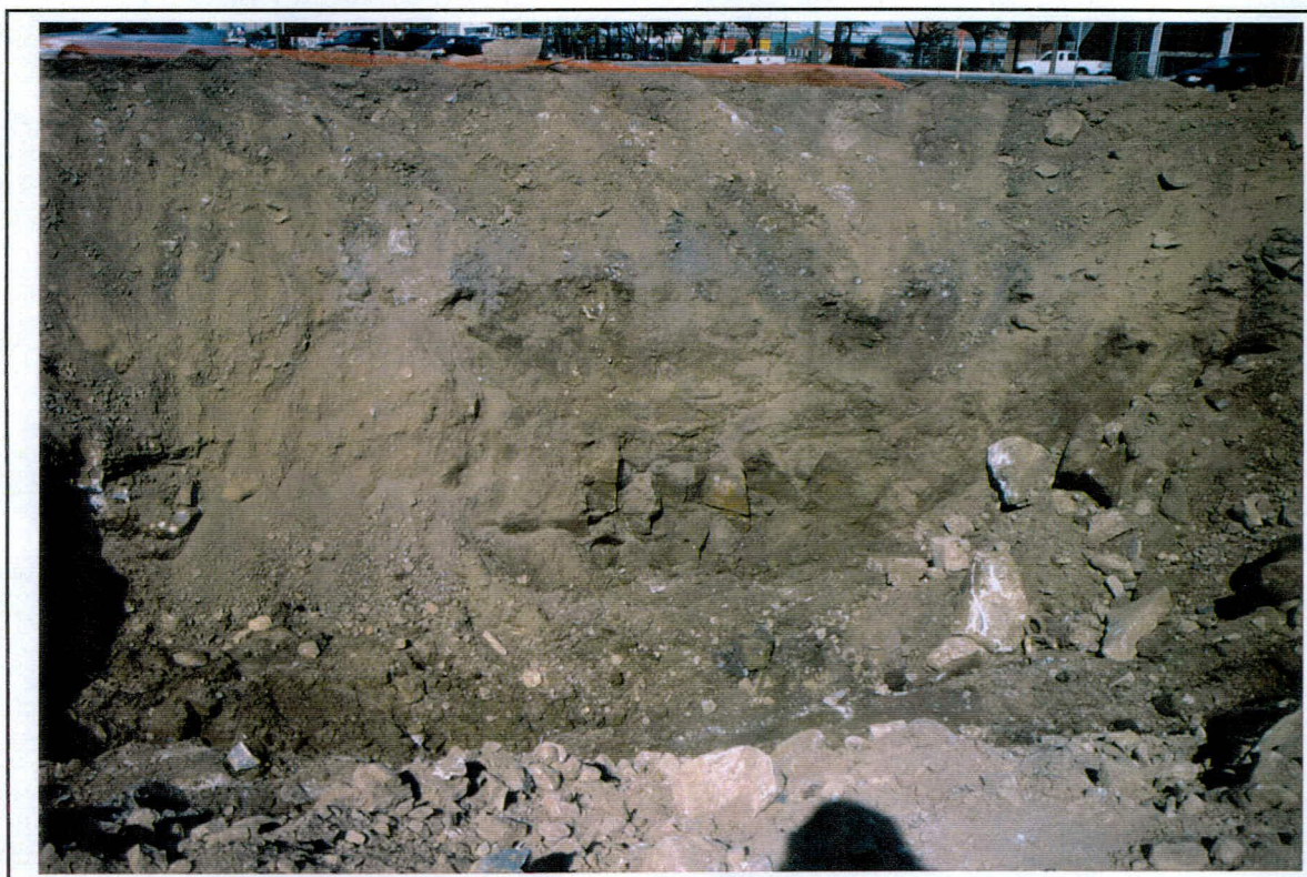
Photo 2: Projet 5200-9681, boulevard l'Acadie / autoroute 520, secteur 1, stratigraphie du remblai (N)
