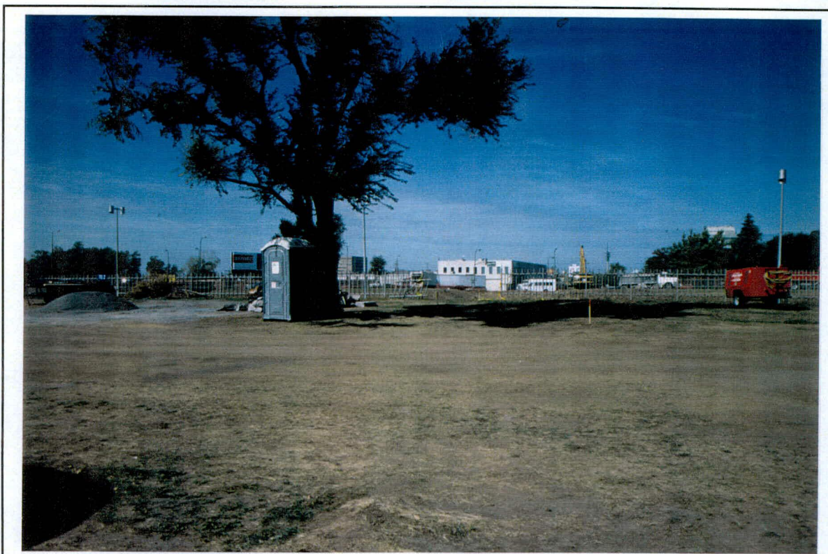
Photo 4: Projet 5200-9681, boulevard l'Acadie / autoroute 520, secteur 2, vue d'ensemble des travaux vers le nord-ouest (NO)
