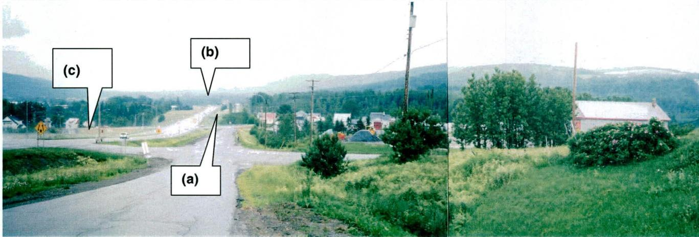
VUE EN DIRECTION SUD. Le projet s'insérera dans l'emprise actuelle et s'harmonisera à la forme urbaine car : **(a)** raccordement du chemin Parkington et de l'avenue du Longeron, **(b)** abaissement du profil de la route 185 et maintien du niveau actuel de la route 295 et **(c)** terre-plein de 15 m ensemençé.
