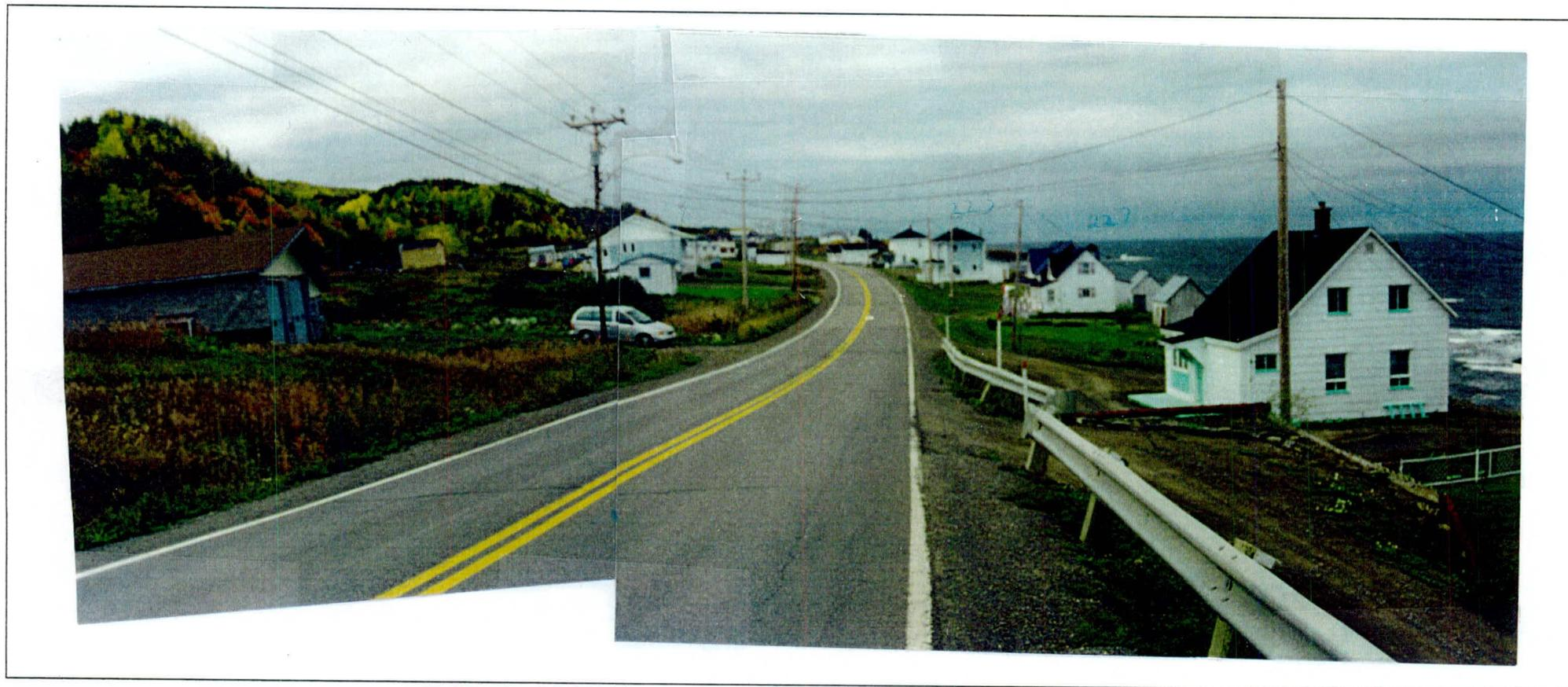
Photo 1 : Aperçu du secteur à l'ouest du projet à partir du ch. 1+060. Nos civique 229 à l'avant-plan. Accès précaire aux résidences du côté nord au début du projet. Présence d'une glissière de sécurité et mur de soutènement de l'entrée privée de la résidence no. civique 231, au ch. 1+060g.
