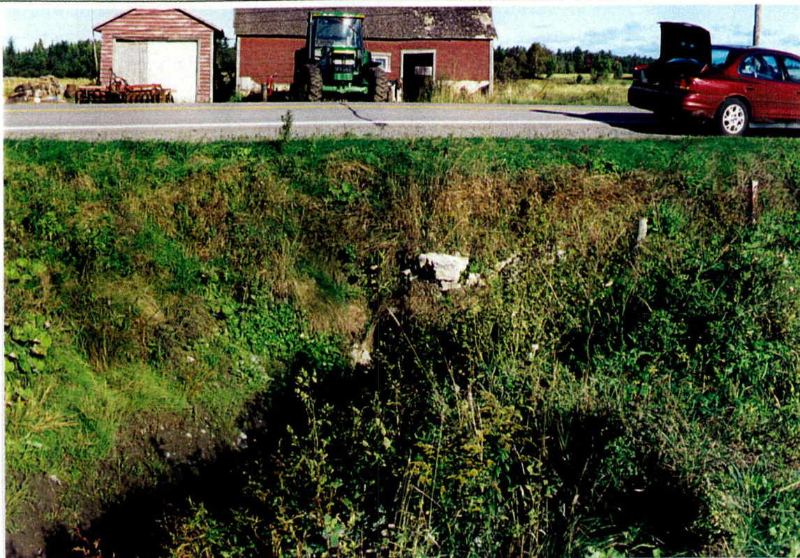
Photo 13 Projet 3973-9908, route 358, 10+400 – 11+200 (N)
