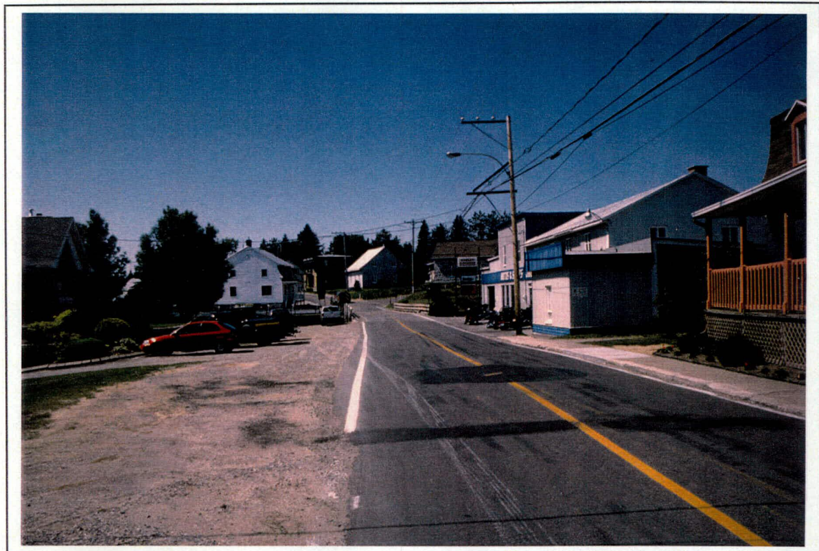
Photo 4 Projet 3973-9219, route 354, secteurs 1 et 2, vue générale (SO)
