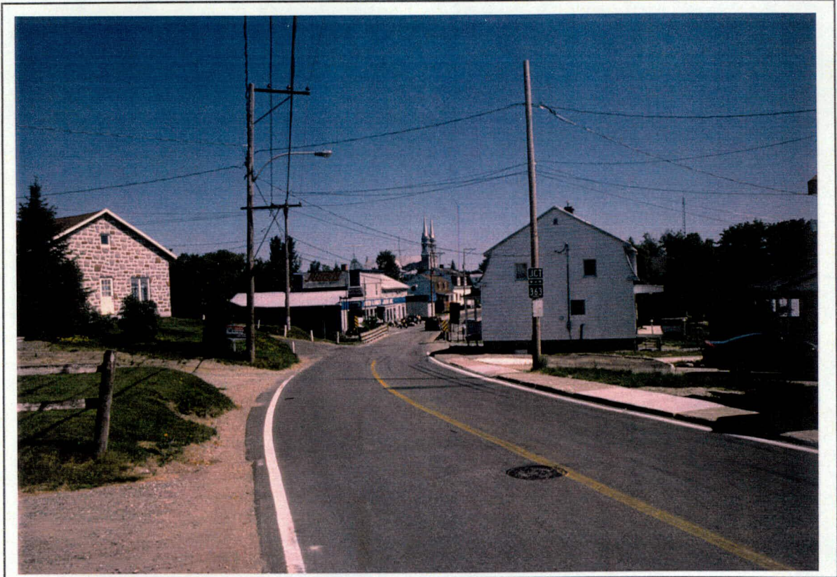
Photo 3 Projet 3973-9219, route 354, secteurs 1 et 2, vue générale (NE)
