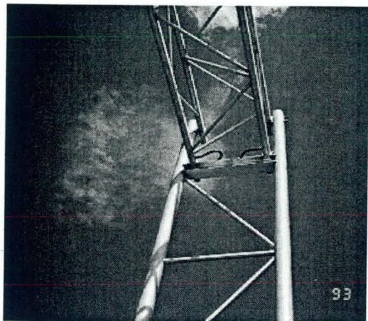
L'alliage d'aluminium 6063-T6 choisi pour les poteaux permet une conification facile et un traitement thermique qui l'amène à un niveau de résistance supérieur à celui de l'aluminium de charpente de type 6061-T6. Les membrures secondaires et la poutre d'appui sont en alliage d'aluminium 6061-T6.
