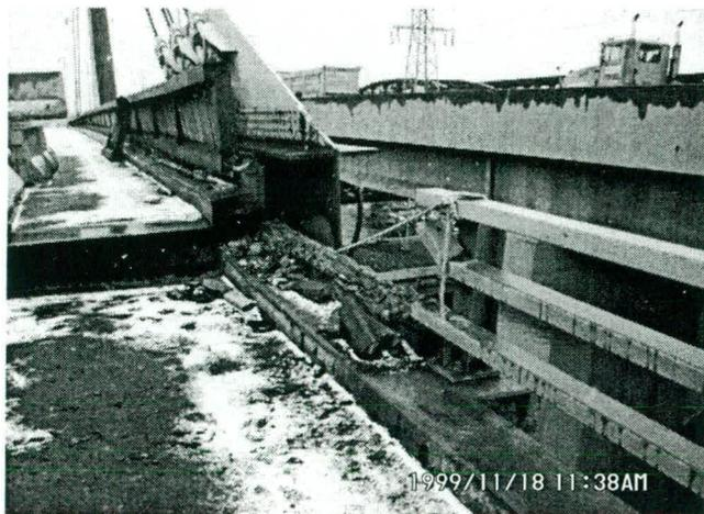
Le 17 novembre 1999, tôt le matin, une plaque ancrant une bielle à l'unité de fondation s'est sectionnée amenant le soulèvement de l'extrémité du tablier de 600 mm du côté aval du pont, alors que la travée de 94 m présentait une flèche excessive. Le pont fut alors fermé à toute circulation.
