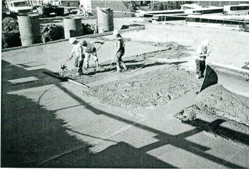
Figure 8 : Finition de la dalle de construction
