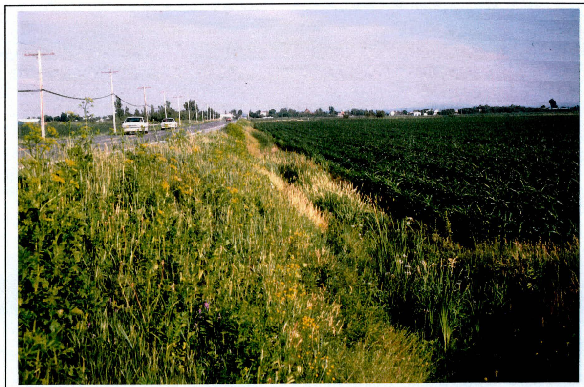
Photo 18: Projet 5472-9802, route 132, secteur 2, vue d'ensemble à partir du chaînage 0 + 000 vers le sud-est. (SE)
