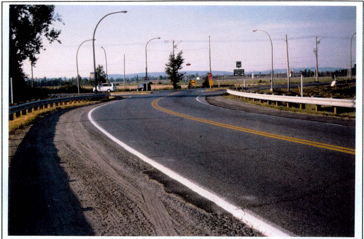
Photo 22: Projet 5473-9309, bretelle d'accès A-540, secteur 2, à partir du chaînage 2 + 080 vers le nord. (N)
