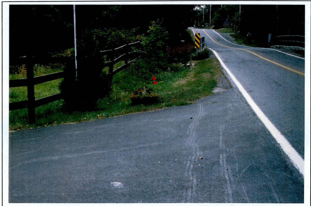
Photo 6: Projet 5472-9223, route 202, secteur 1, portion nord. (E)
