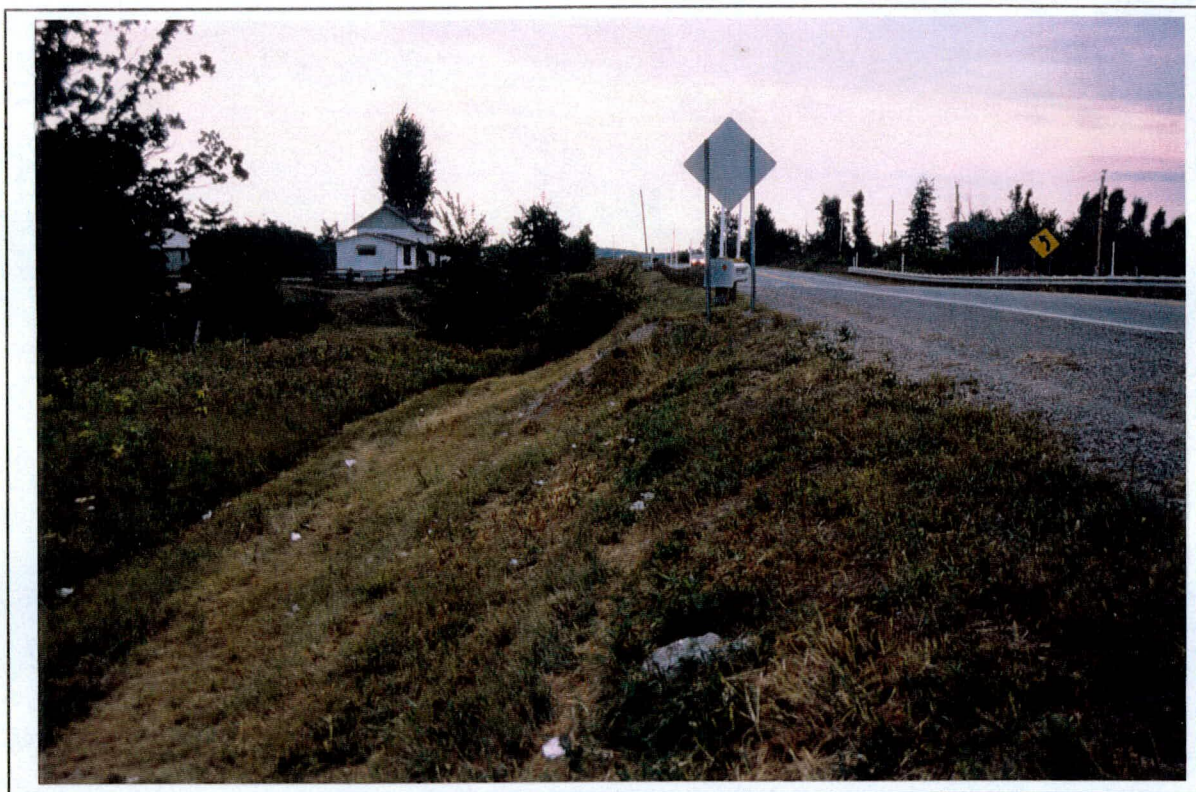
Photo 19: Projet 5472-9806, route 138, portion sud du secteur 1, vue d'ensemble à partir du chaînage 4 + 900 vers le sud-ouest. (SO)
