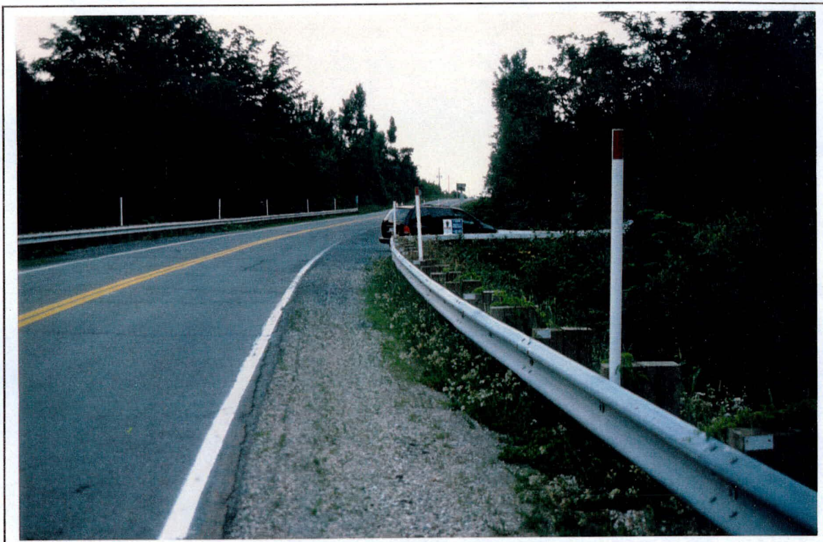
Photo 15: Projet 5472-9724, Montée de la frontière - Huntingdon, secteur 1, de chaînage 0 + 250 vers 0 + 400. (N)
