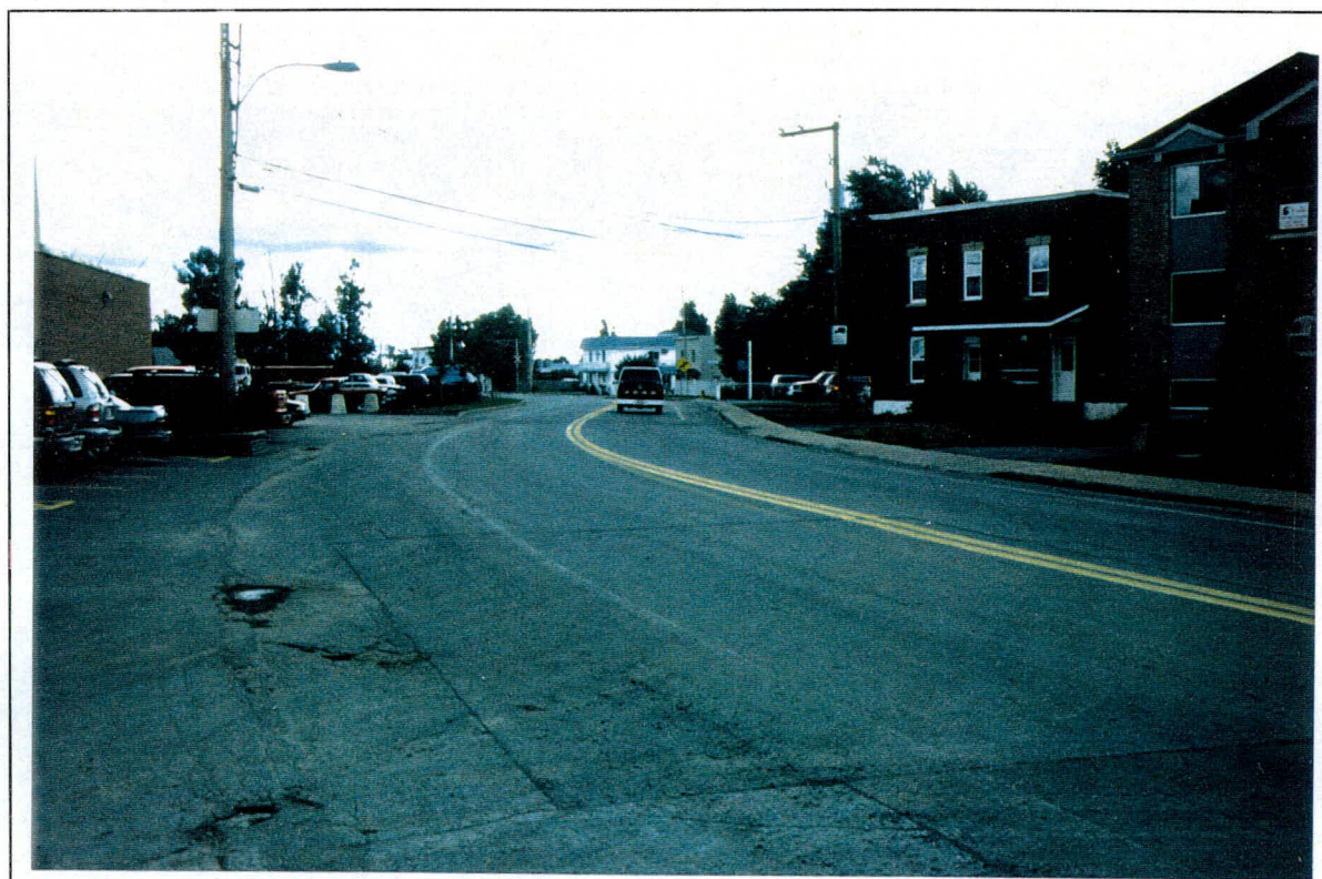
Photo 2: Projet 5471-9309, route 209, secteur 1, vue d'ensemble à partir du chaînage 1 + 175 vers le sud-ouest. (SSO)
