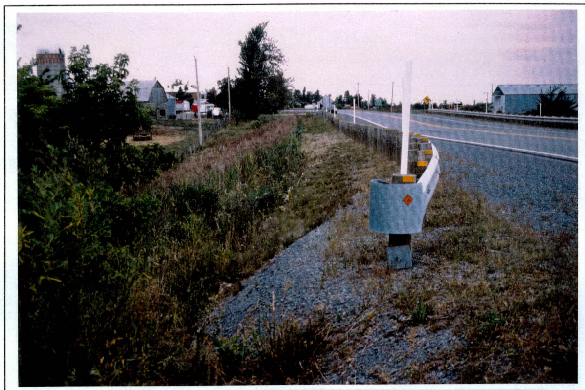
Photo 20: Projet 5472-9806, route 138, portion nord du secteur 2, vue d'ensemble à partir du chaînage 4 + 700 vers le nord-est. (NE)
