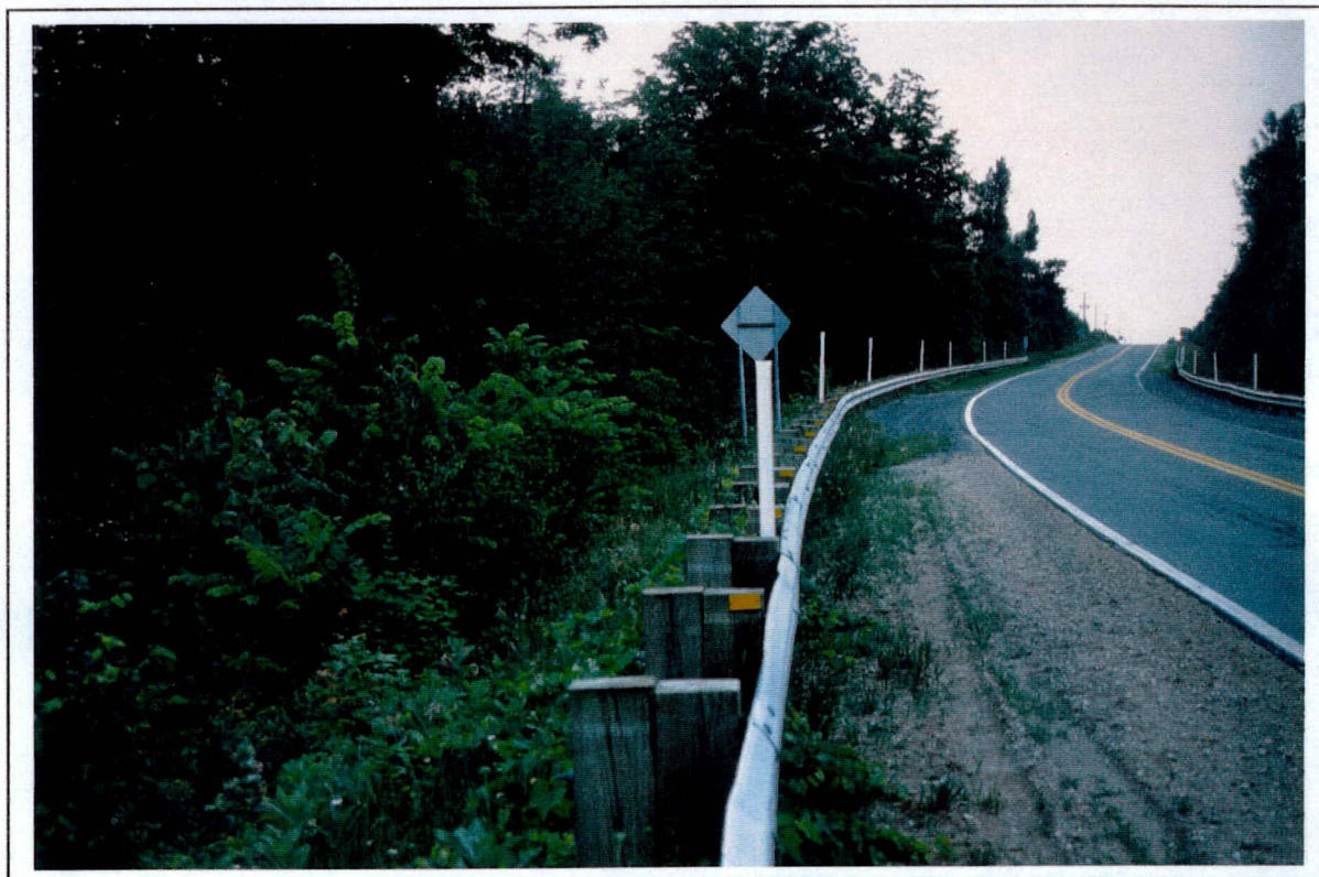
Photo 16: Projet 5472-9724, Montée de la frontière - Huntingdon, secteur 2, de chaînage 0 + 250 vers 0 + 400. (N)
