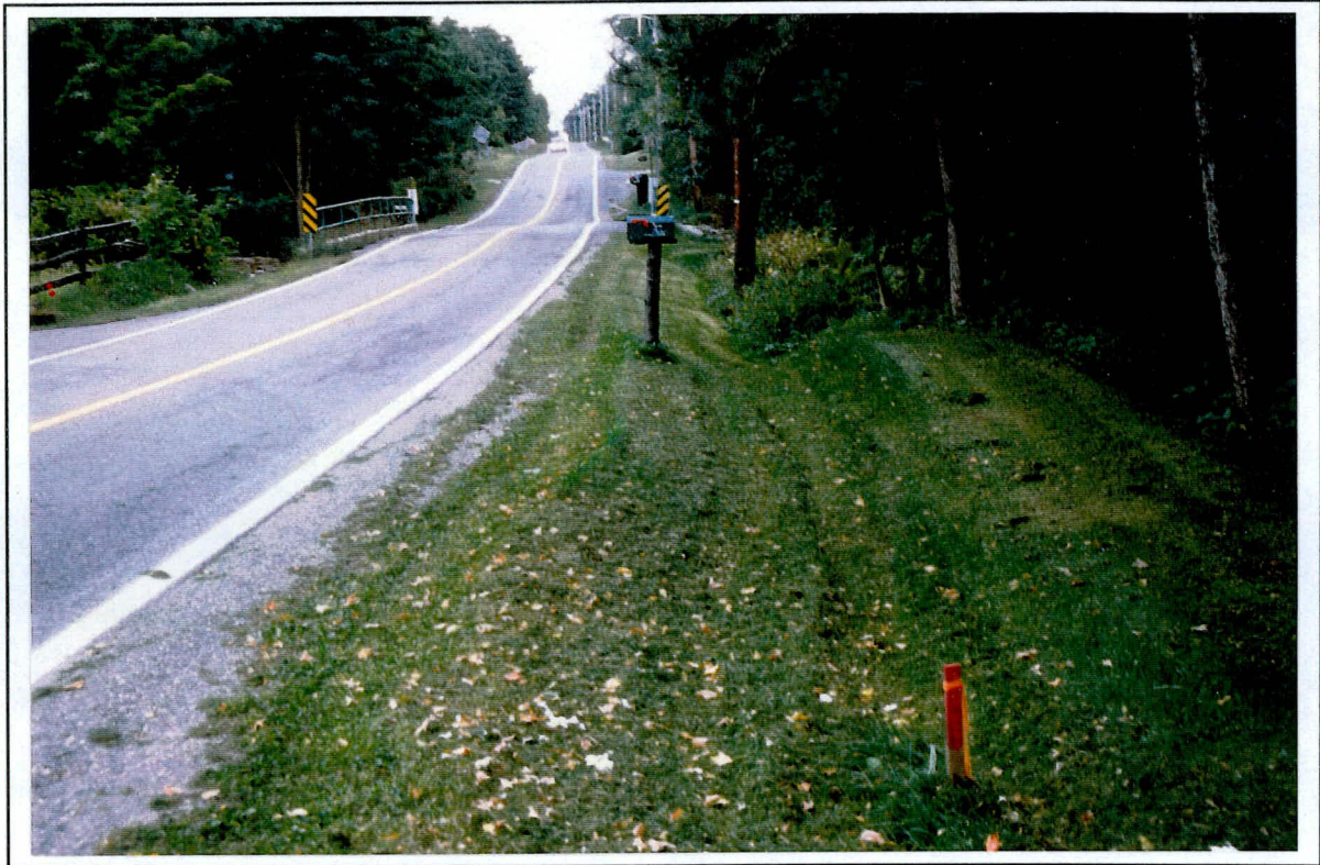
Photo 5: Projet 5472-9223, route 202, secteur 1, portion sud. (E)
