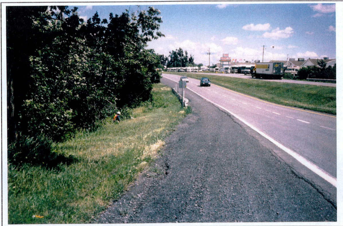
Photo 25: Projet 5474-9324, route 104, secteur 1, portion nord de l'emprise. (SE)
