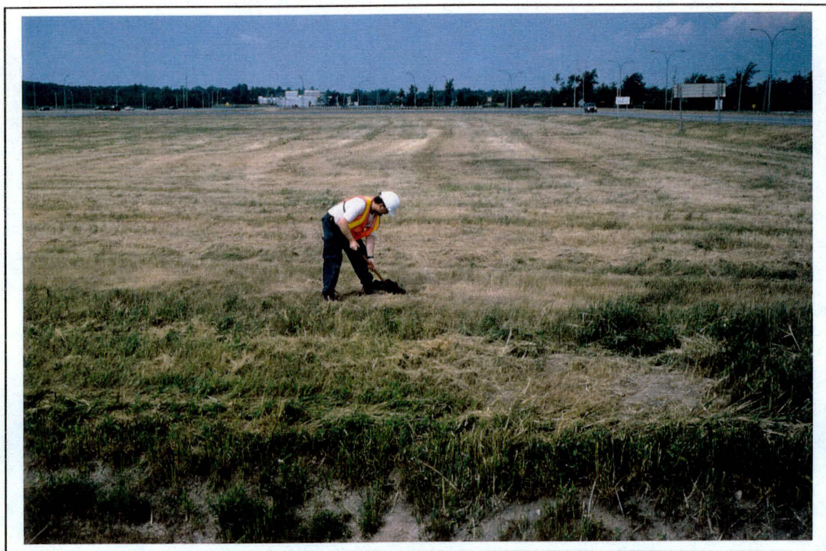
Photo 24: Projet 5473-9735, A-40 / avenue St-Charles, secteur 2, portion sud-est, sondage en cours. (E)
