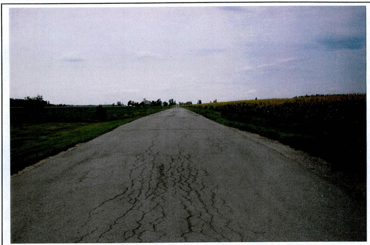
Photo 7: Projet 5472-9503, rang du Dix, secteur 1, vue générale vers le nord. (NNO)
