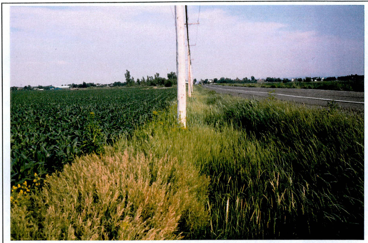
Photo 17: Projet 5472-9802, route 132, secteur 1, vue d'ensemble à partir du chaînage 0 + 000 vers le sud-est. (SE)
