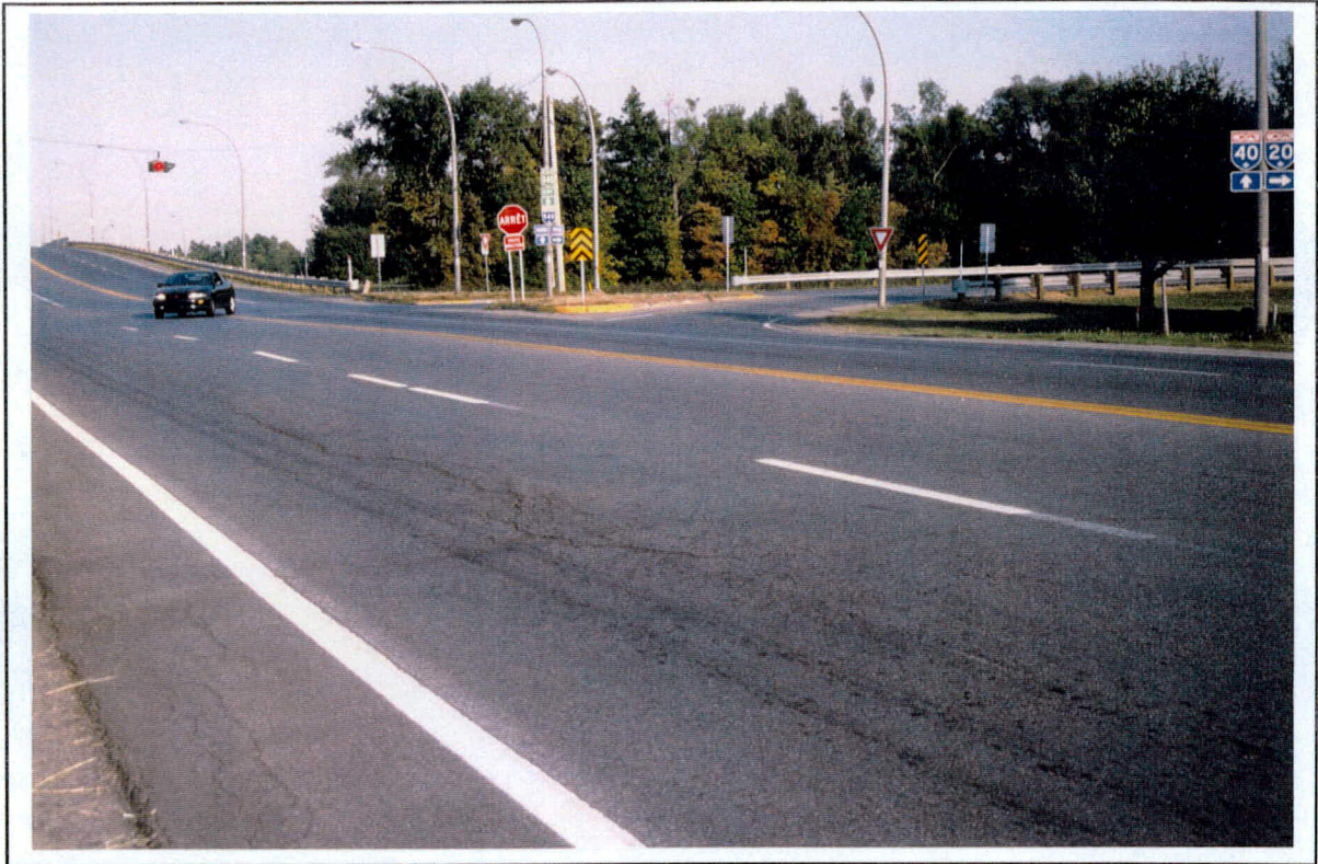
Photo 21: Projet 5473-9309, route 340, secteur 1, à partir du chaînage 1 + 000 vers l'est. (SE)
