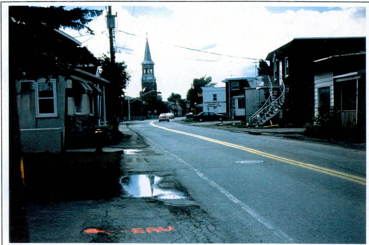
Photo 1: Projet 5471-9309, route 209, secteur 1, vue d'ensemble à partir du chaînage 1 + 500 vers le sud. (S)
