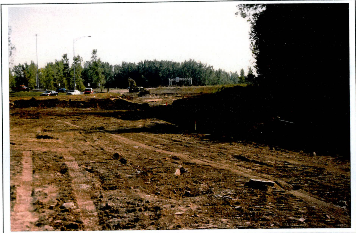
Photo 11: Projet 5100-9789, autoroutes 13 et 440 secteur 2, vue d'ensemble à partir du chaînage 21 + 280 vers le sud. (S)
