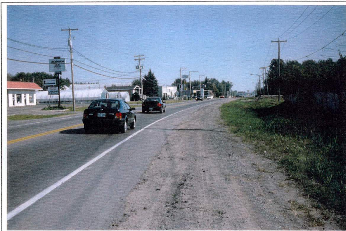
Photo 9: Projet 5100-9646, route 148, secteur 1, vue générale à partir du chaînage 4 + 320 vers le sud-est. (SSE)
