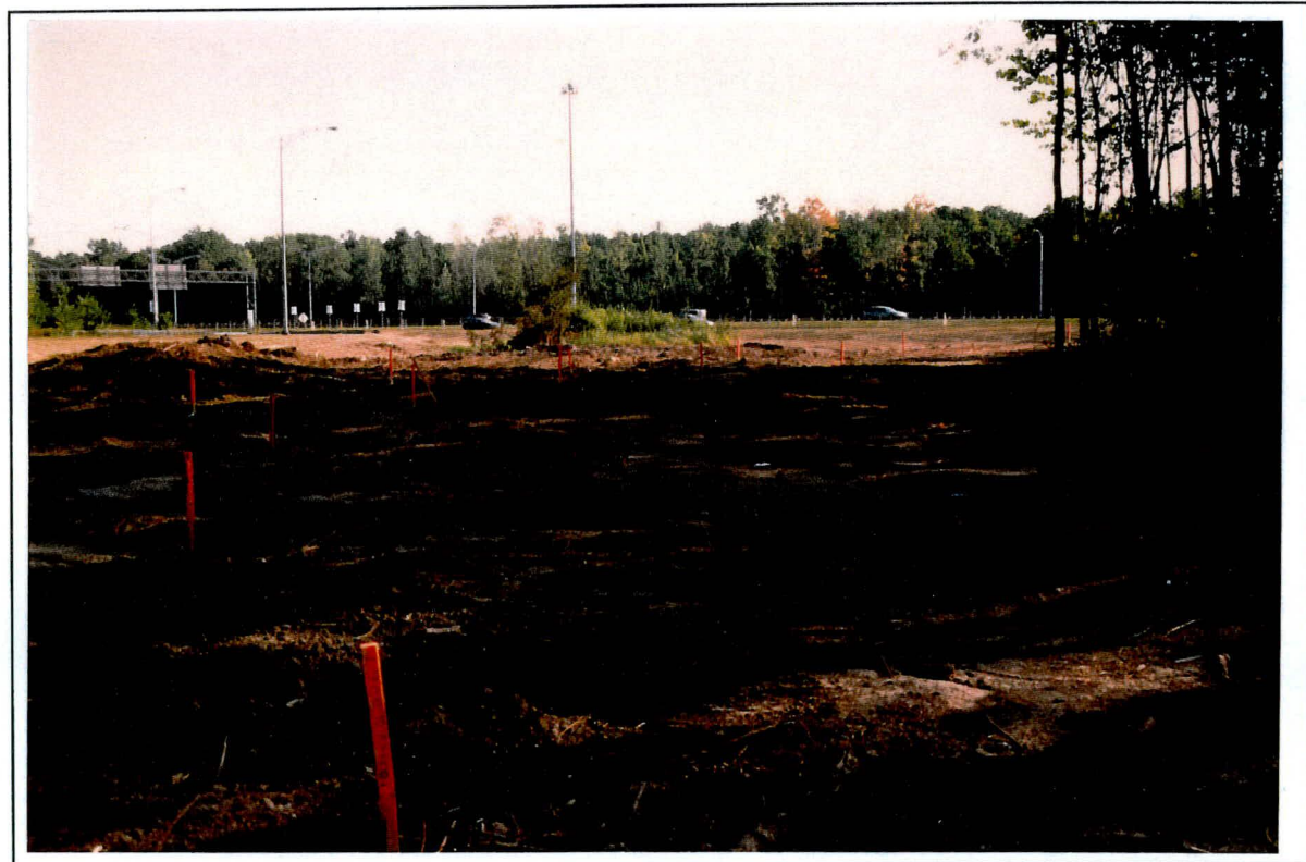
Photo 12: Projet 5100-9789, autoroutes 13 et 440, secteur 3, vue d'ensemble à partir du chaînage 26 + 100 vers l'ouest. (SSO)
