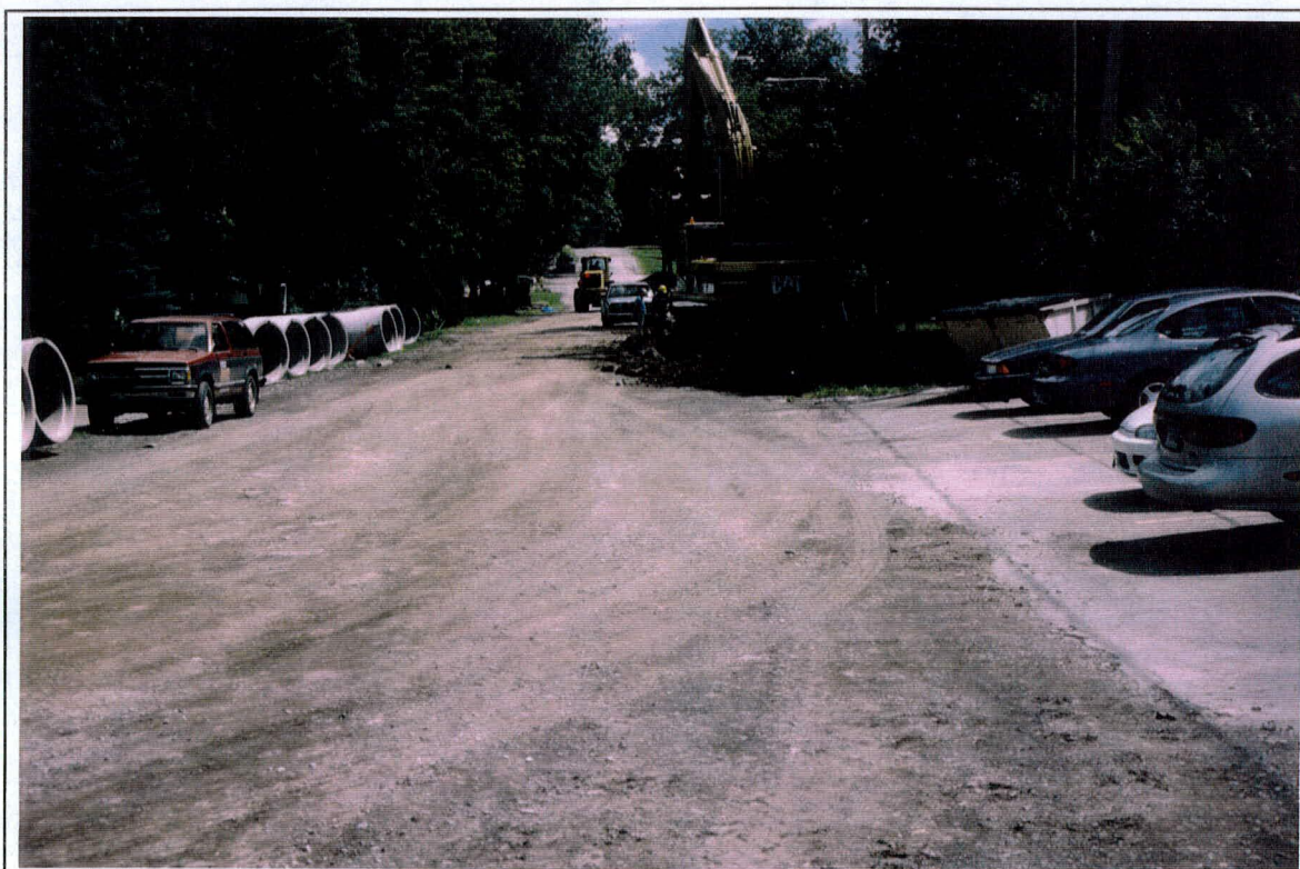
Photo 4: Projet 5100-9427, 51 e Avenue, secteur 3, vue d'ensemble à partir du chaînage 0 + 000 vers le sud-est. (SE)
