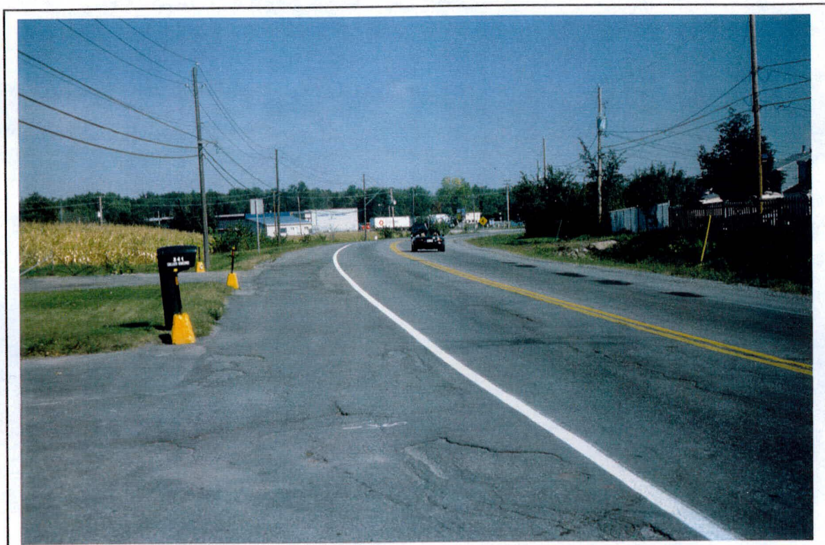
Photo 5: Projet 5100-9445, route 148, secteur 1, vue générale à partir du chaînage 3 + 980 vers le sud-est. (SE)
