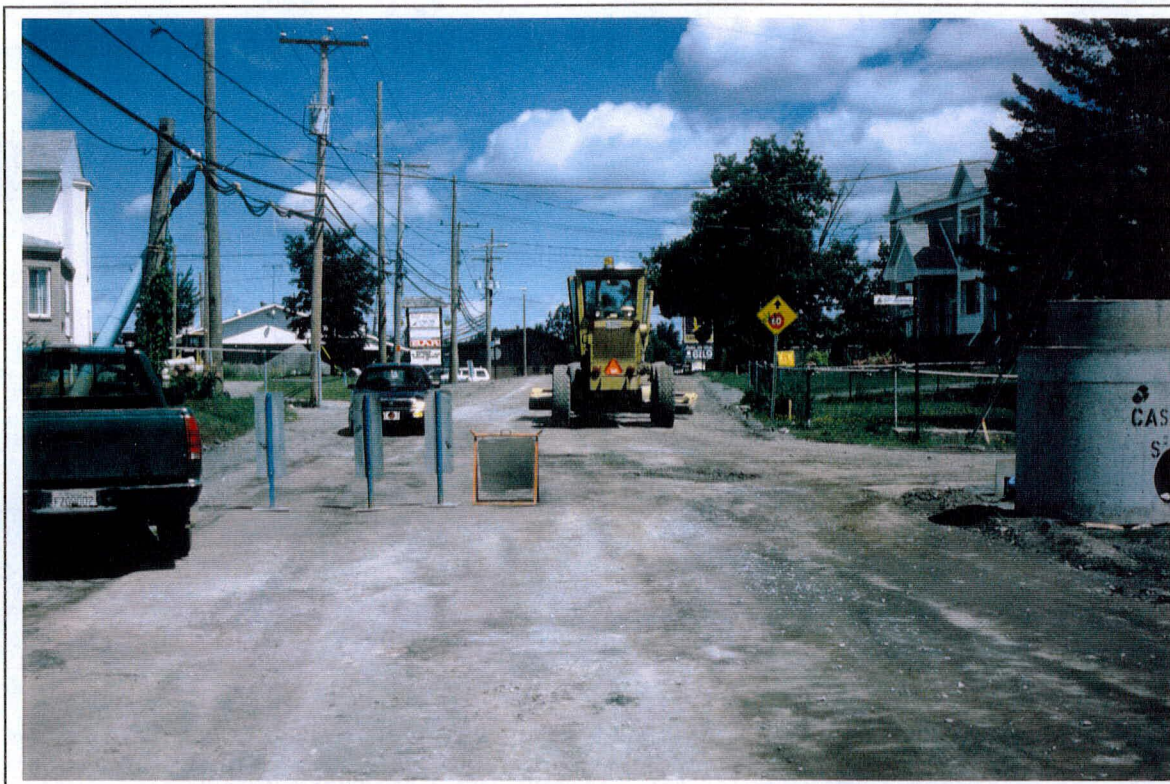
Photo 3 Projet 5100-9427, route 344, secteur 1, vue d'ensemble à partir du chaînage 0 + 187 vers le nord-est. (NE)
