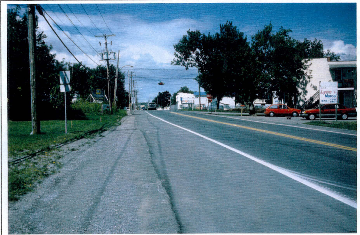
Photo 7: Projet 5100-9505, route 335, secteur 1, vue générale à partir du chaînage 1 + 312 vers le nord. (N)
