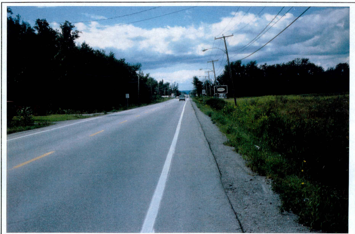
Photo 2: Projet 5100-9418, route 337, secteur 1, vue d'ensemble à partir du chaînage 0 + 900 vers le nord-ouest. (NNO)
