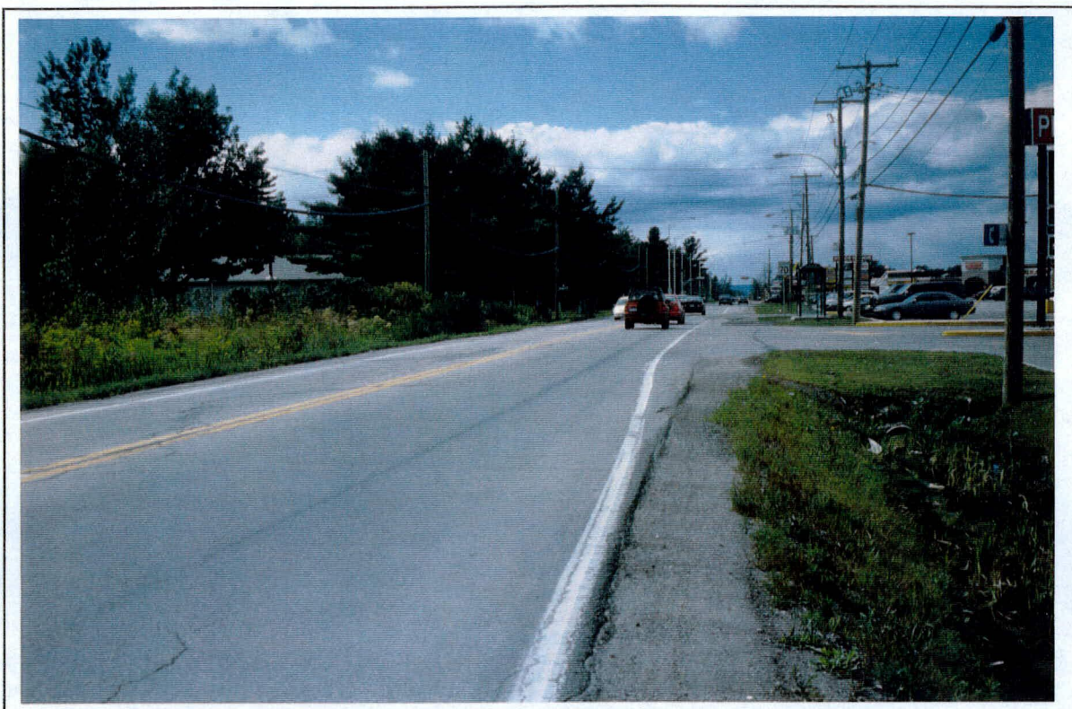
Photo 1: Projet 5100-9418, route 337, secteur 1, vue d'ensemble à partir du chaînage 0 + 325 vers le nord-ouest. (NNO)
