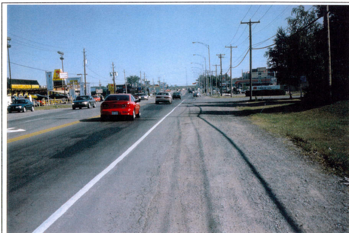
Photo 10: Projet 5100-9646, route 148, secteur 1, vue générale à partir du chaînage 5 + 660 vers le sud-est. (SSE)
