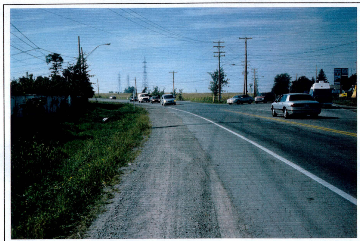
Photo 6: Projet 5100-9445, route 148, secteurs 1 et 2, vue générale à partir du chaînage 4 + 320 vers le sud-est. (NO)
