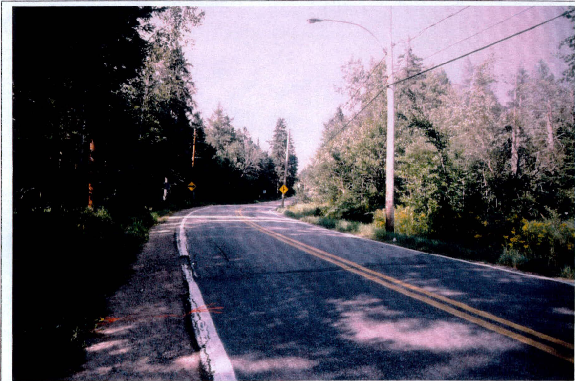
Photo 6 Projet 3973-9724 Route 369, secteur 2, à 9+ 960 (NE)
