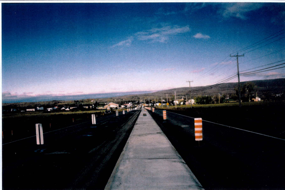
Photo 1: Projet 3972-8023, Route 367, vue générale à 9+500. (N)
