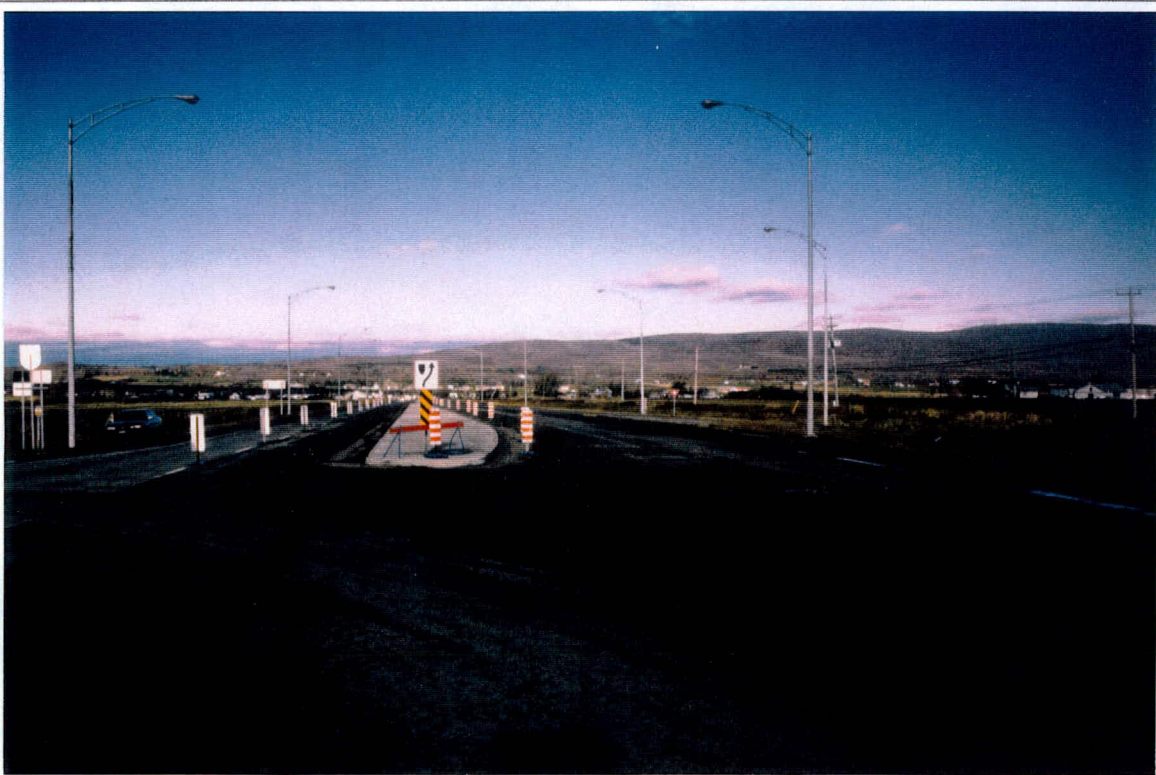
Photo 2: Projet 3972-8023, Route 367, vue générale à 9+990. (N)
