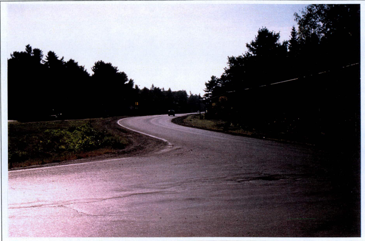
Photo 3 Projet 6571-8730, Route 364, secteur 1, vers chaînage 0 + 200. (SE)
