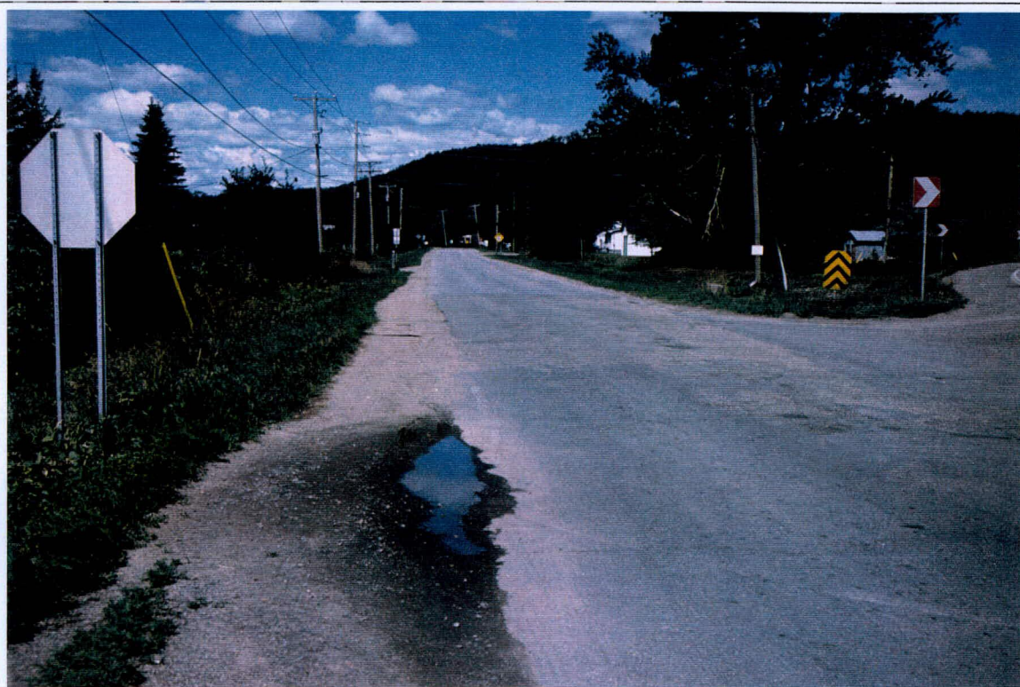
Photo 14: Projet 6574-8625, secteurs 1 et 2, vue d'ensemble de l'intersection à partir du chaînage 15 + 100. (O)
