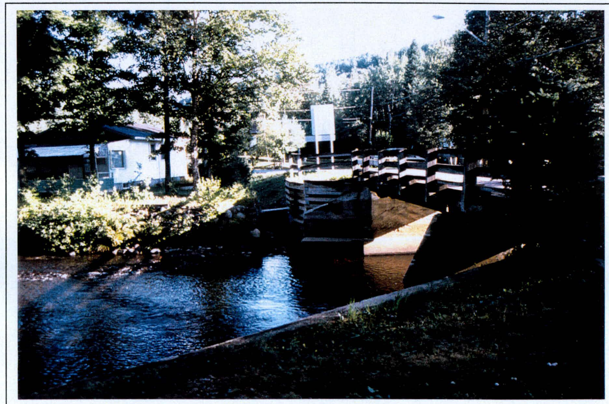
Photo 8: Projet 6571-9821, rue Dupont, secteur 2, vue d'ensemble. (S)
