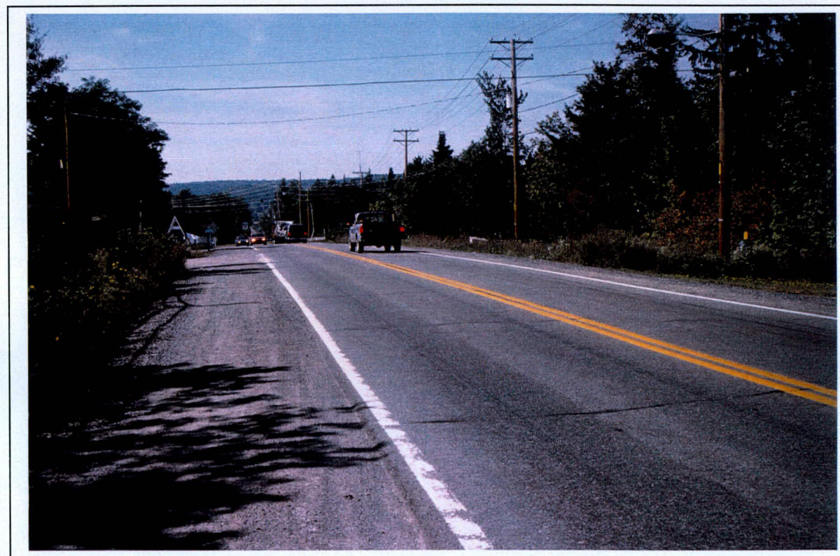
Photo 6: Projet 6571-9128, route 337, secteur 2, vue vers le sud à partir du chaînage 13 + 120. (O)
