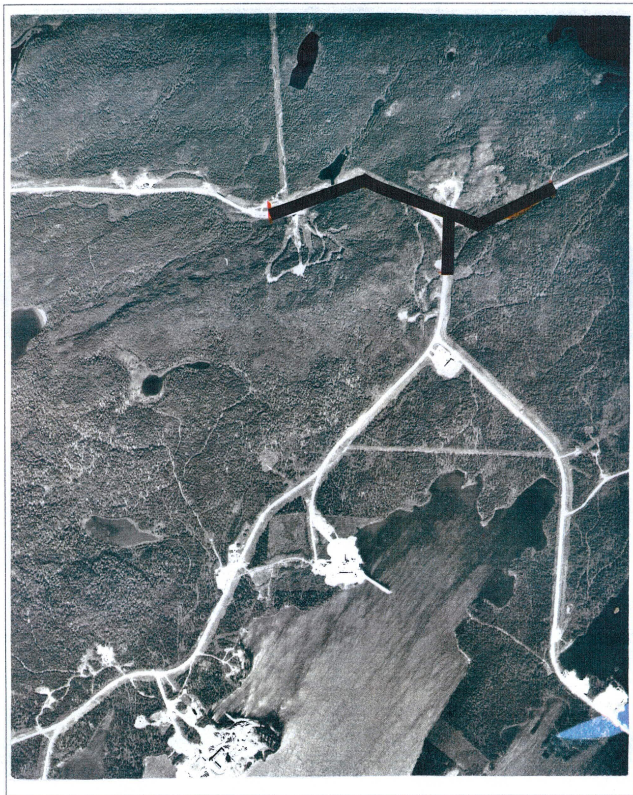
Figure 18 Localisation sur photo aérienne du projet 3772-9613, route 167
