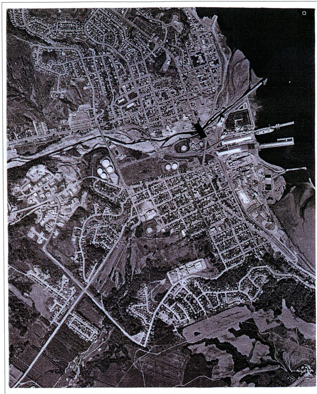
Figure 6 Localisation sur photo aérienne du projet 3671-9828, route 170
