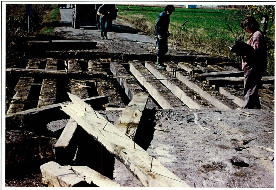
**Photo 10:** Détail d'assemblage du tablier (poutres posées parallèlement) du pont du chemin de la Rivière-à-la-Guerre, Saint-Anicet Paroisse. Direction sud-ouest (cliché D-95-R5:08).
