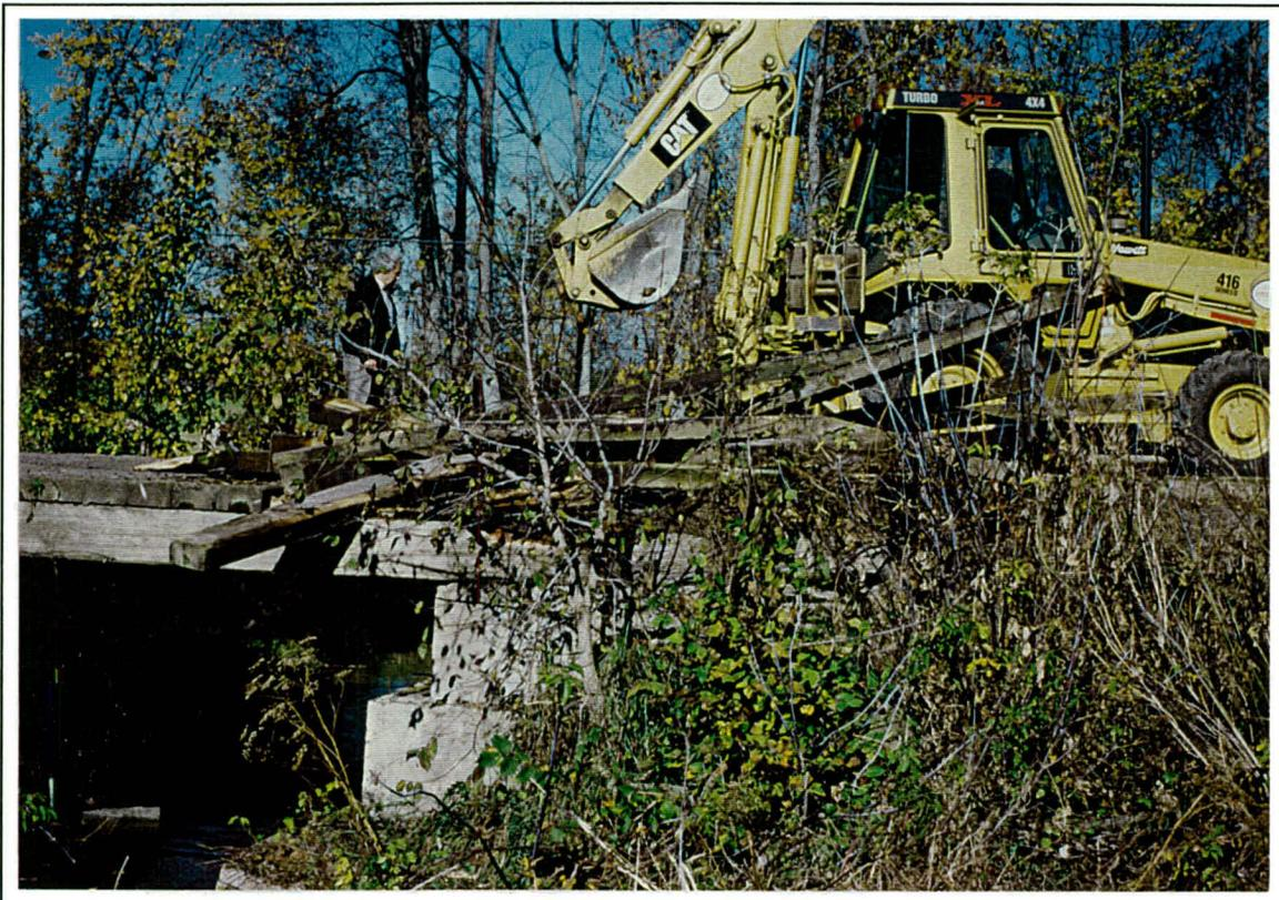
**Photo 9 :** Démantèlement de la structure de bois du tablier du pont du chemin de la Rivière-à-la-Guerre, Saint-Anicet Paroisse. Direction nord-ouest (cliché D-95-R5:06).
