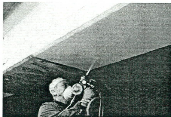
Figure 3: Métallisation au pistolet à flamme
