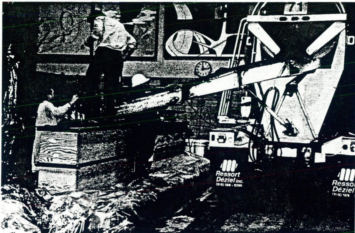
Figure 14. Coulage du béton
