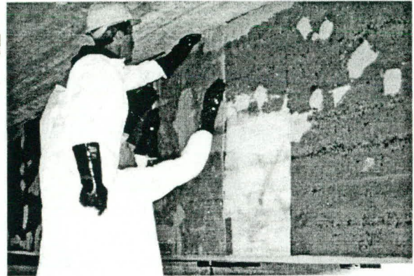
Figure 1 : Mise en place des matériaux composites : (a) renforcement en flexion (Carbodur); (b) bandes en U (Sikawrap)
